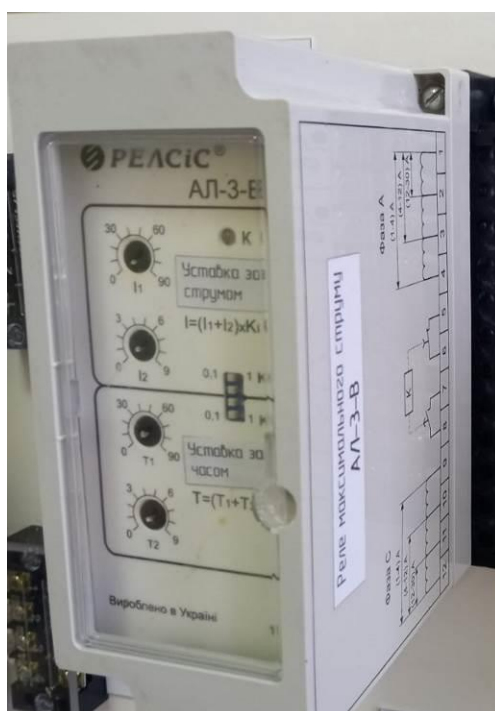
Рисунок 2.1 – Реле реле максимального струму АЛ-3-В
