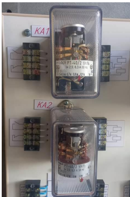
Рисунок 3.7 – Реле струму РТ-40/2
