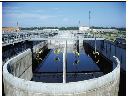
Рис. 14. Схеми розташування горизонтальних мішалок Flygt в коридорах аеротенку за технологію УСТ- процесу
