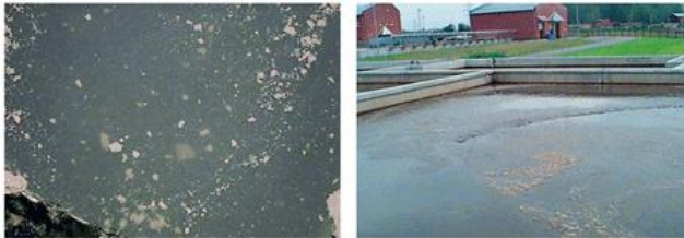
Рис. 9. Сплиття активного мулу на поверхню вторинних відстійників
