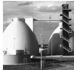
Рис. 4. Залізобетонні метантенки очисної станції Галле-Норд (Німеччина)
