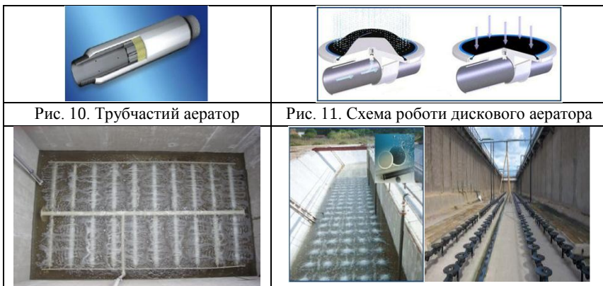
Рис.12. Вигляд трубчастої (а) та мембранної (б) системи аерації в роботі
