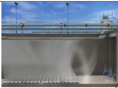
Рис. 13. Сумісна робота дискових аераторів з низько обертовими мішалками
