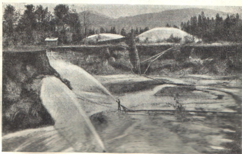
Фиг. 354. Общий вид разработки, оборудованных гидромониторами и гидроэлеватором.
