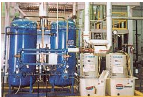
Рис 3.3 Система пом'якшення води цеолітом натрію
