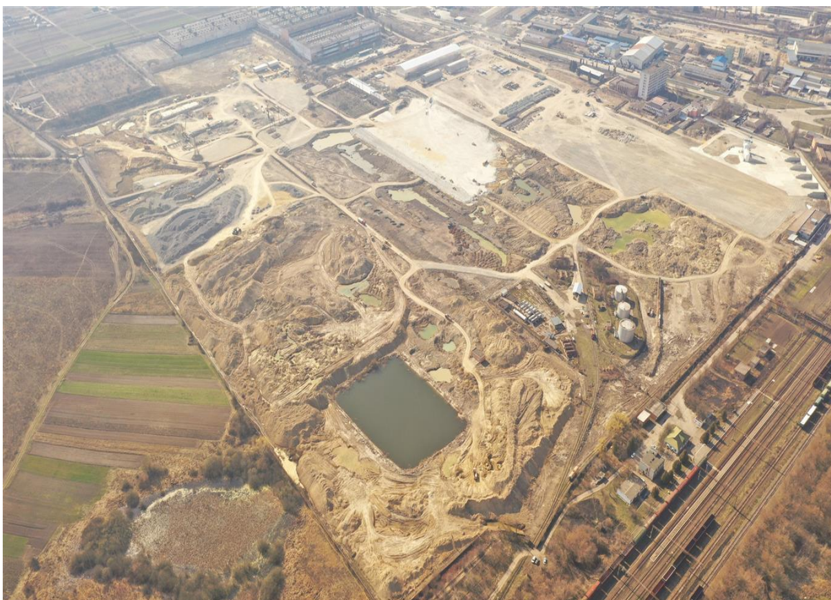
Малюнок 1.4. – Підготовчі роботи до початку будівництва ТОВ «Кроноспан Рівне»
