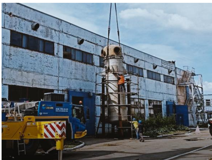
Рис 1.3– Виготовлення нестандартного обладнання
