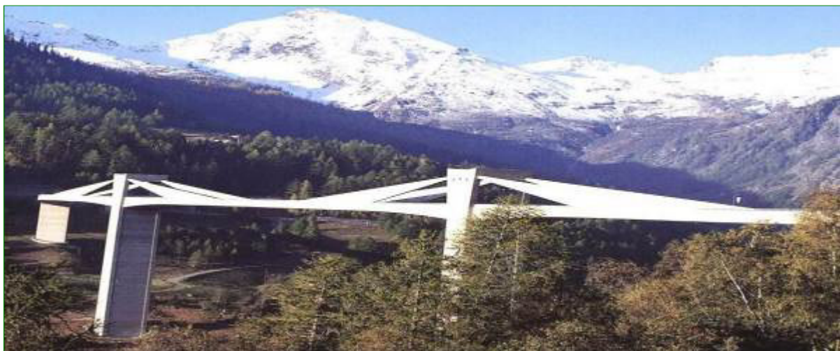
Рис. 2.17. Автодорожний віадук у Швейцарії
