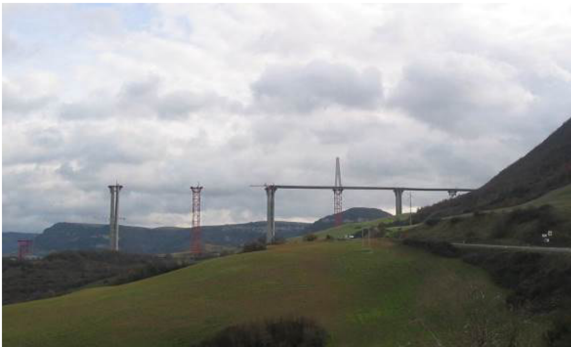
Рис. 53. Стан будівництва віадук Мійо (початок 2004 року)
