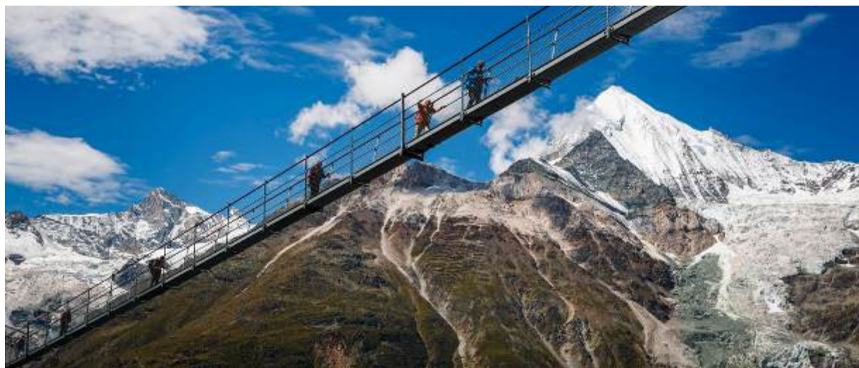
Рис. 37. Вид на підвісний міст Шарля Куонена (Швейцарія)
