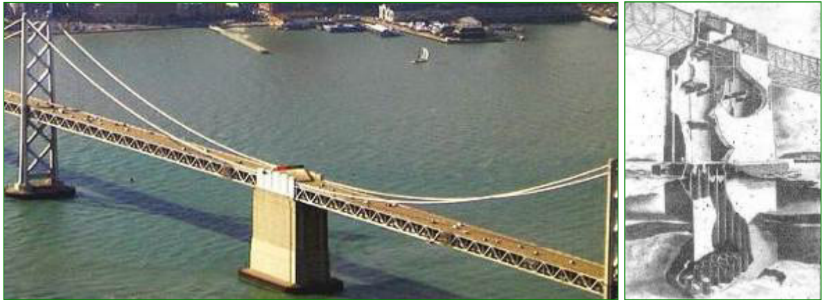
Рис. 4.19. Загальний вигляд та проміжна анкерна опора Оклендського мосту
