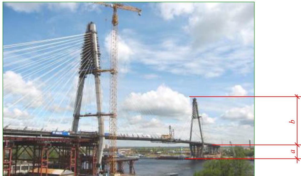
Рис. 3.10. Ромбічні плоскі рами пілонів моста (показано співвідношення відстаней a та b )
