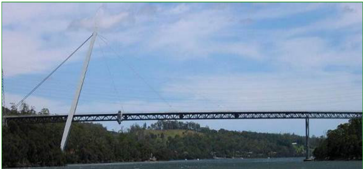
Рис. 8.27. Вантовий автодорожній металевий міст Бетмана (Batman Bridge) через річку Теймар на острові Тасманія в Австралії (збудований у 1968 році)
