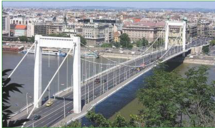
Рис. 4.23. Єлизаветинський міст у Будапешті (схема: 57+290+57м). Міст має стійки пілонів, що гойдаються, шарнірно прикріплені до опор; при цьому балка жорсткості пропущена крізь отвори у стійках пілонів
