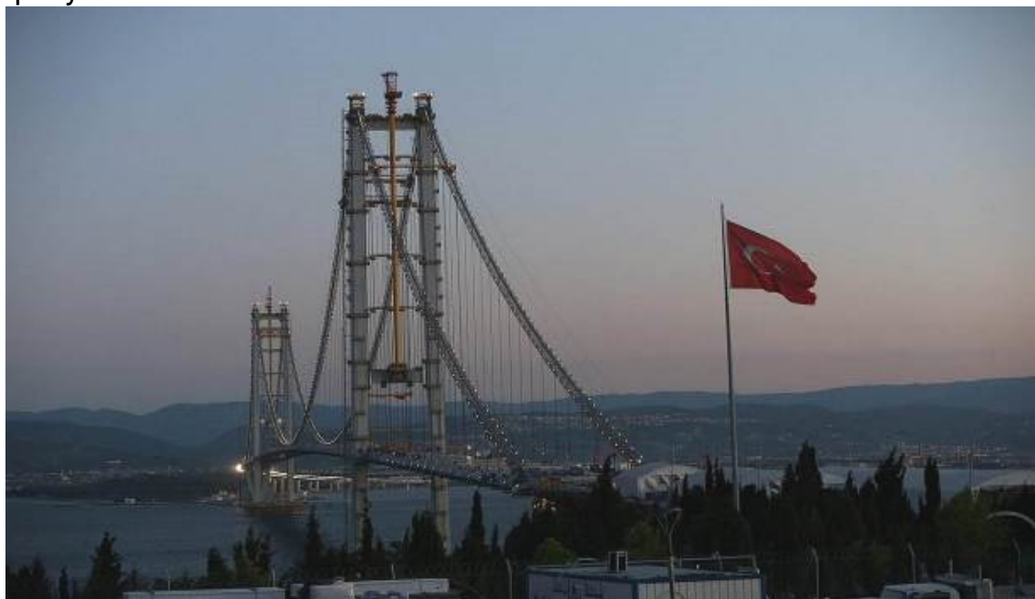
Рис. 41. Підвісний міст Осман Газі або міст через Ізмітську затоку (Туреччина)
