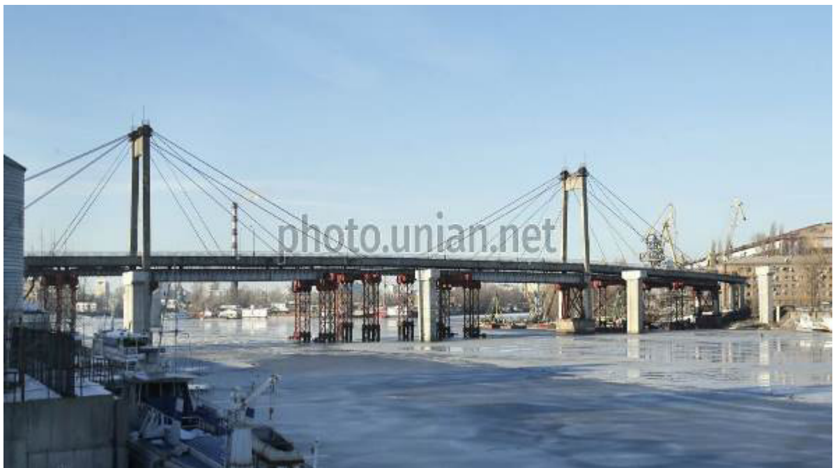
Рис. 1.14. Міст через Київську гавань (Рибальський міст), ріка Дніпро. Київ
