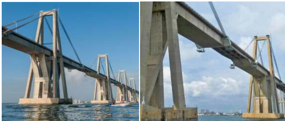
Рис. 7.18. Рамно-вантова система Моранді – загальний вигляд вантових прогонових будов мосту через озеро Маракайбо (Венесуела)
