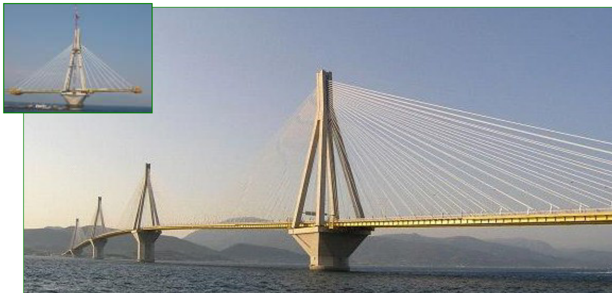
Рис. 7.13. Багатопрогоновий вантовий міст Ріон – Антіріон через затоку Корінфа біля міста Патри в Греції довжиною 2290 м і шириною 26,3 м (2004 р.) Розмір основних прогонів моста по 560 м
