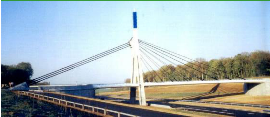
Рис. 8.16. Вантова система двопрогонового вантового шляхопроводу у Франції
