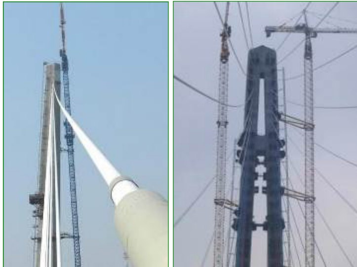
Рис. 9.2. Провисання вант вантових мостів
