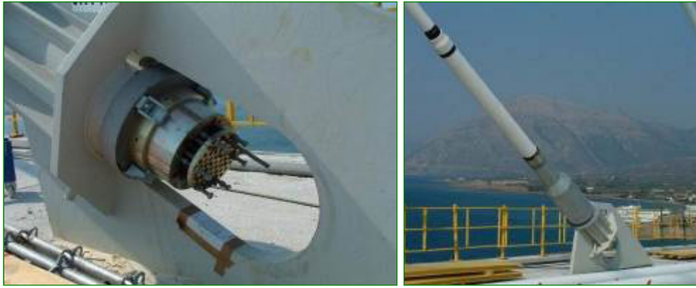
Рис. 3.6. Кінцевий анкер, опорна плита, напрямна та антивандальна труби вант мосту Ріон–Антиріон у Греції
