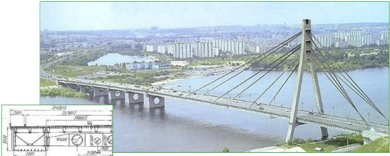
Рис. 6.8. Міст через Дніпро у Києві (нині Північний міст) з основним прогоном 300 м. Перший у СРСР великий вантовий міст. Побудований 1976 р.
