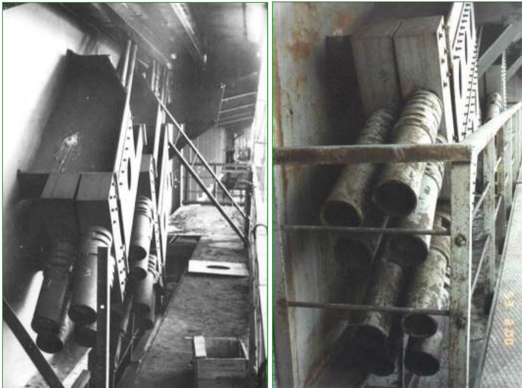
Рис. 3.2. Анкери з холоднотвердіючими сумішами
