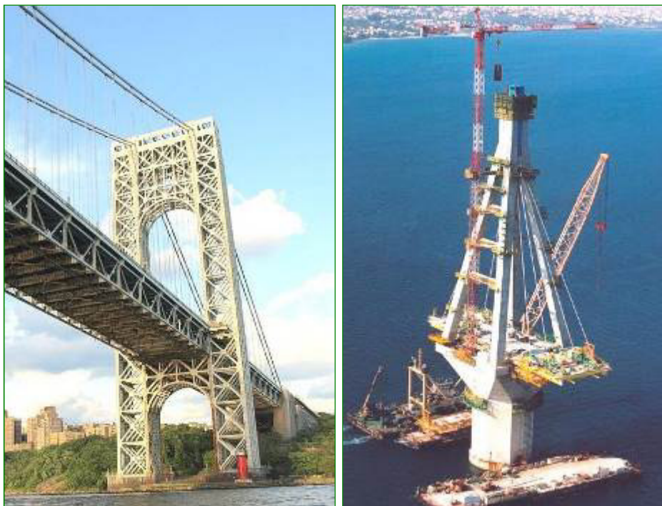
Рис. 3.9. П-подібна плоска рама пілону моста Джорджа Вашингтона в США та просторова А-подібна рама пілону вантового моста Ріон-Антиріон в Греції
