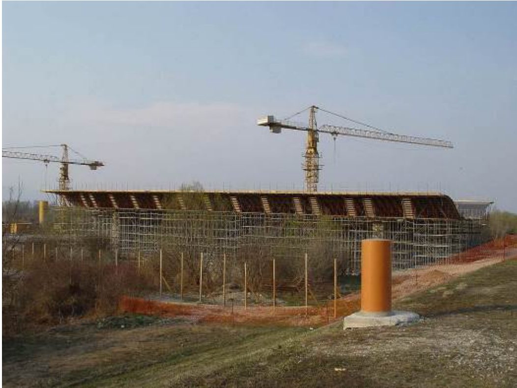
Рис. 121. Вітчизняний міст, або Міст Батьківщини (Хорватія). Початковий етап будівництва
