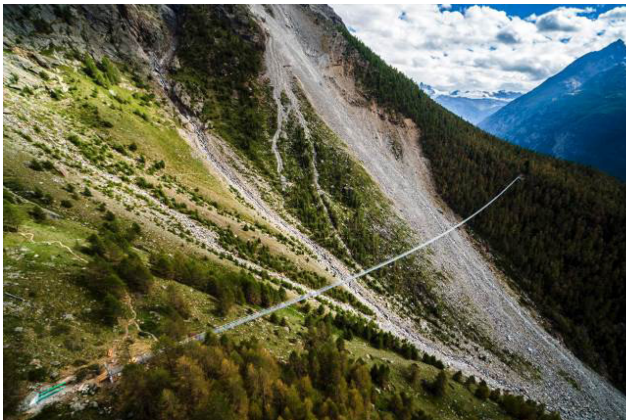
Рис. 38. Вид на підвісний міст Шарля Куонена (Швейцарія)
