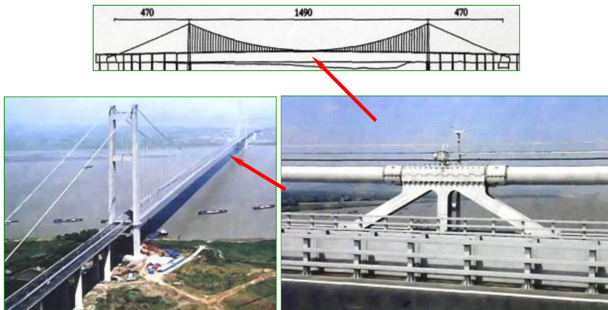
Рис. 5.9. Кріплення кабелю до балки жорсткості мосту Раньянг
