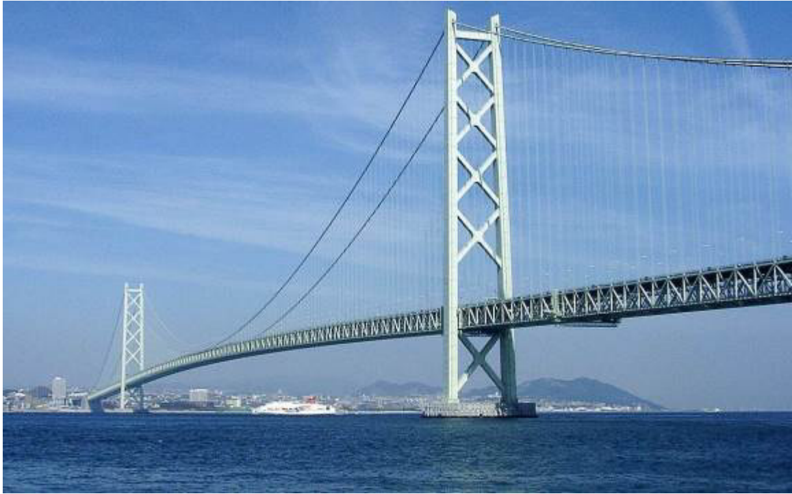
Рис. 2. Вигляд прогонової будови мосту Акасі в Японії
