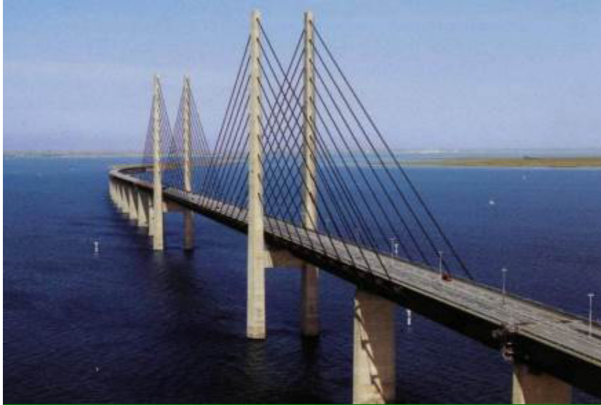
Рис. 1.10. Мостовий перехід через протоку Ересунн між Данією та Швецією довжиною 16,2 км з тунелем та вантовим мостом із основним прогоном 490 м, побудований у 2000 р.
