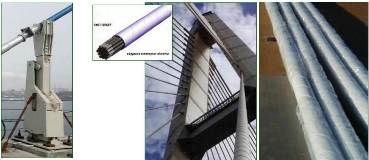
Рис. 10.10. Фрикційний демпфер вант моста через Босфор Східний та демпфуючі пристрої у вигляді гвинтоподібного зовнішнього ребра на оболонці вант
