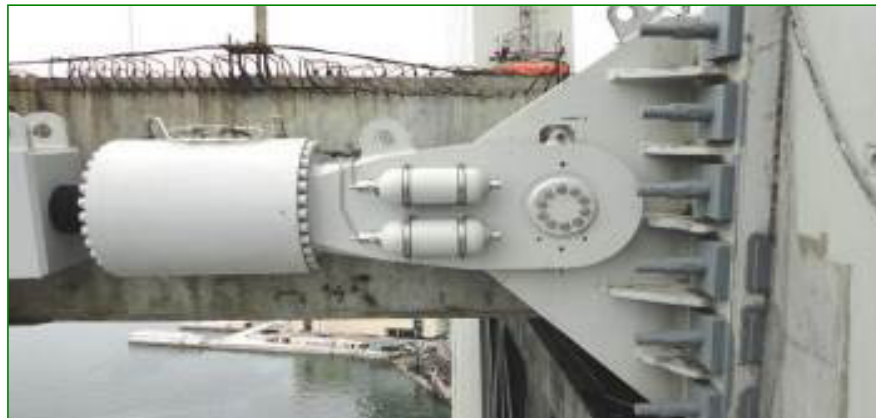
Рис. 10.9. Демпфер (амортизатор) вантової бухти через бухту Золотий Ріг
