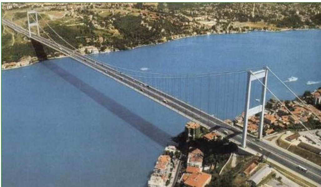
Рис. 4.6. Однопрогоновий автодорожний підвісний міст через Босфор в Туреччині (величина прогону, що перекривається, 1090 м)
