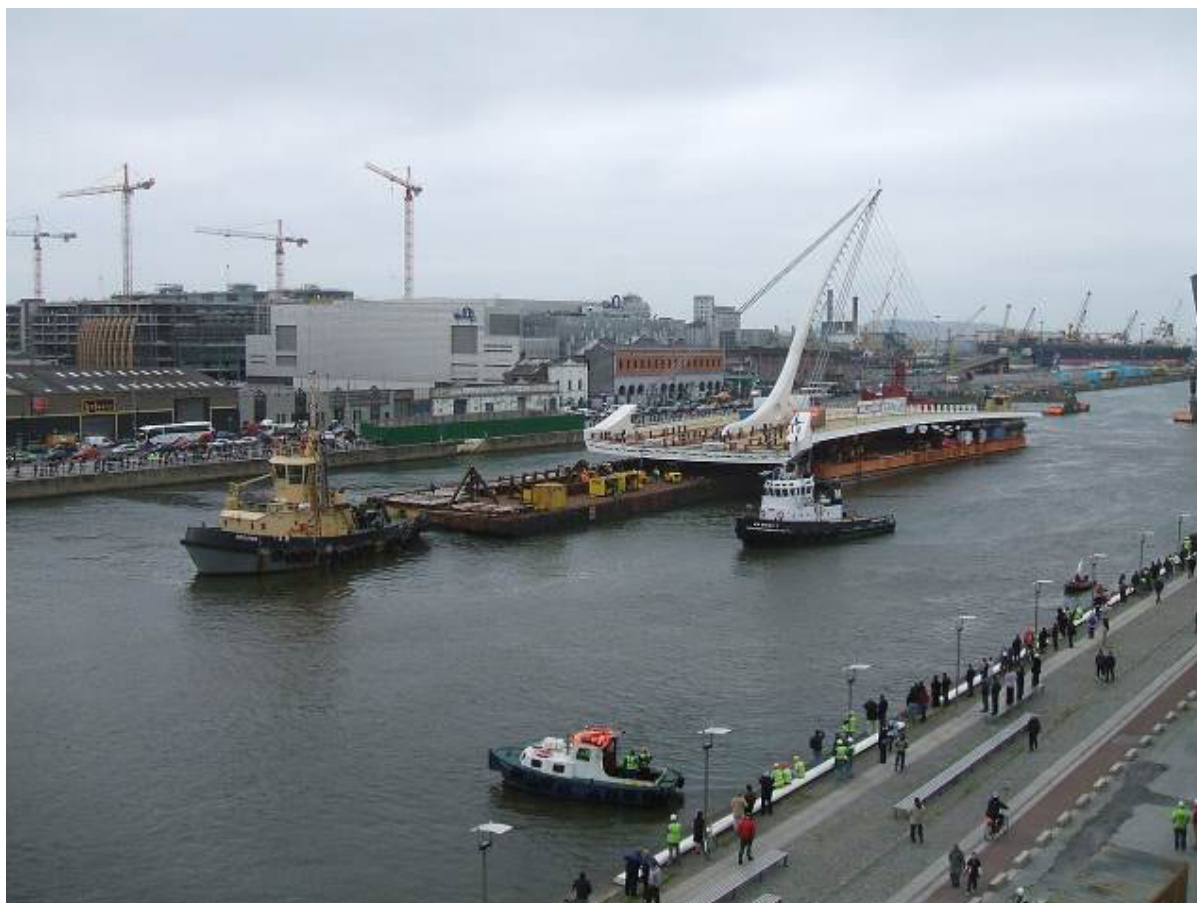
Рис. 90. Міст Семюеля Беккета. Транспортування мосту по річці Ліффі (13 травня 2009 року)
