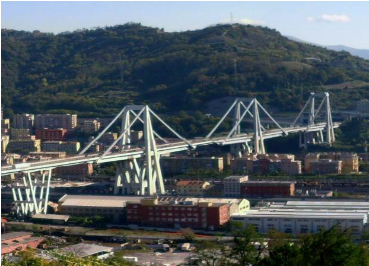
Рис. 84. Вид на Віадук Польчевера або Міст Моранді (Італія). Панорама мосту до катастрофи. Це чотирьохсмуговий вантовий міст з трьома 90 — метровими пілонами
