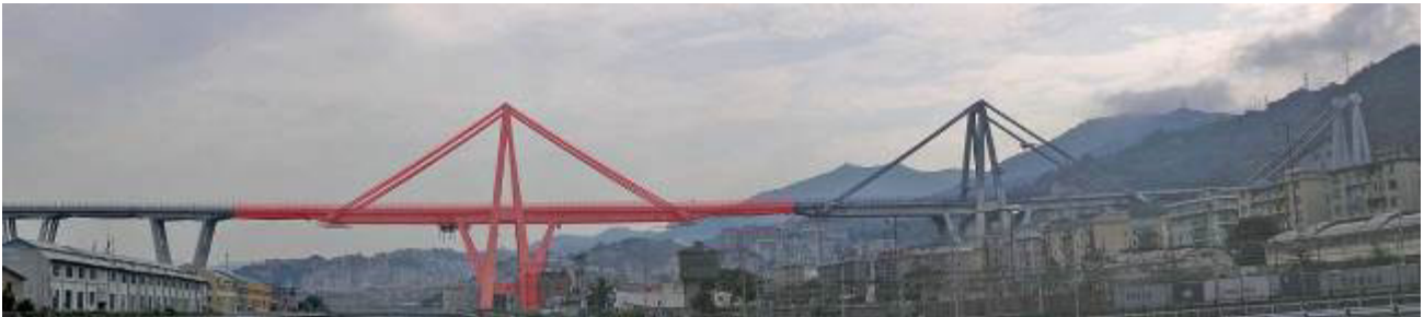
Рис. 83. Вид на Віадук Польчевера або Міст Моранді (Італія). Панорама мосту до катастрофи. Червоним позначено постраждалу частину мосту
