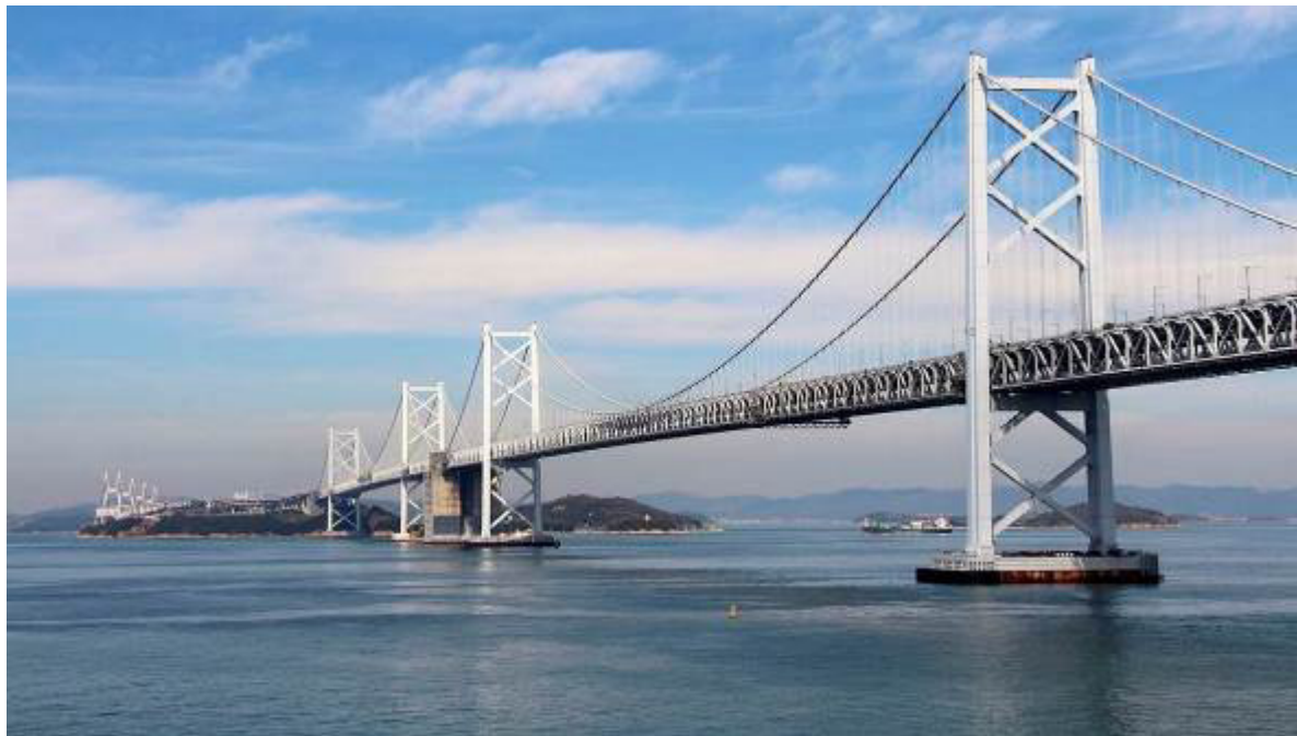
Рис. 34. Міст Мінамібісан-Сето (поряд) та Кітабісан-Сето (вдалині). Добре видно бетонну змичку між ними
