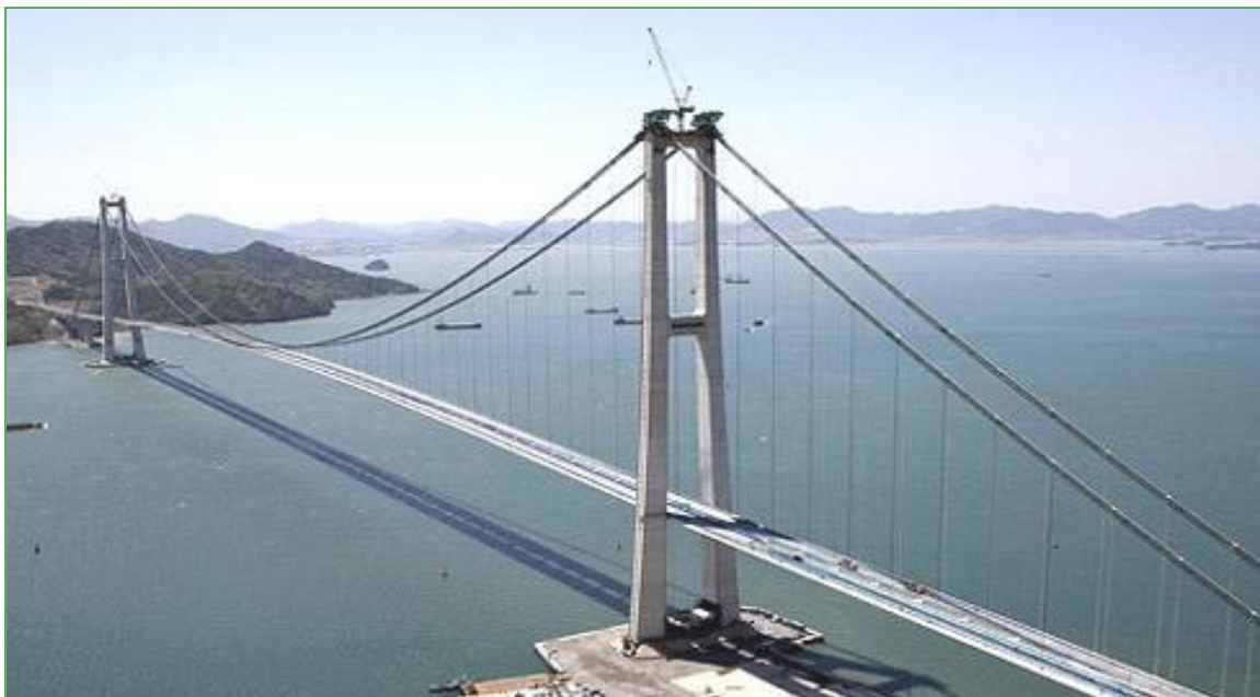
Рис. 4.13. Трьохпрогоновий підвісний міст Лі Сун Шина в Кореї (величина основного прогону 1545 м – один з найбільших за величиною прогону міст у світі)
