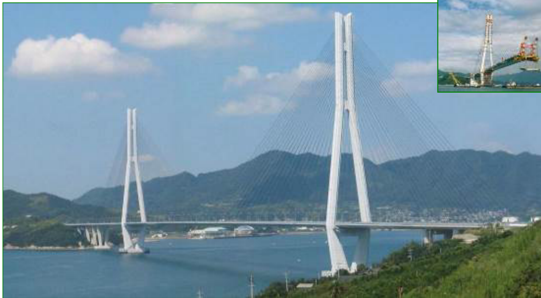
Рис. 7.10. Вид та монтаж прогону мосту Татару в Японії
