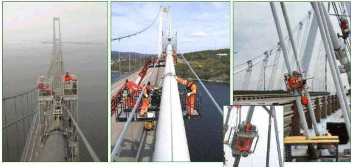
Рис. 2.8. Моніторинг кабелів і підвісок підвісних мостів
