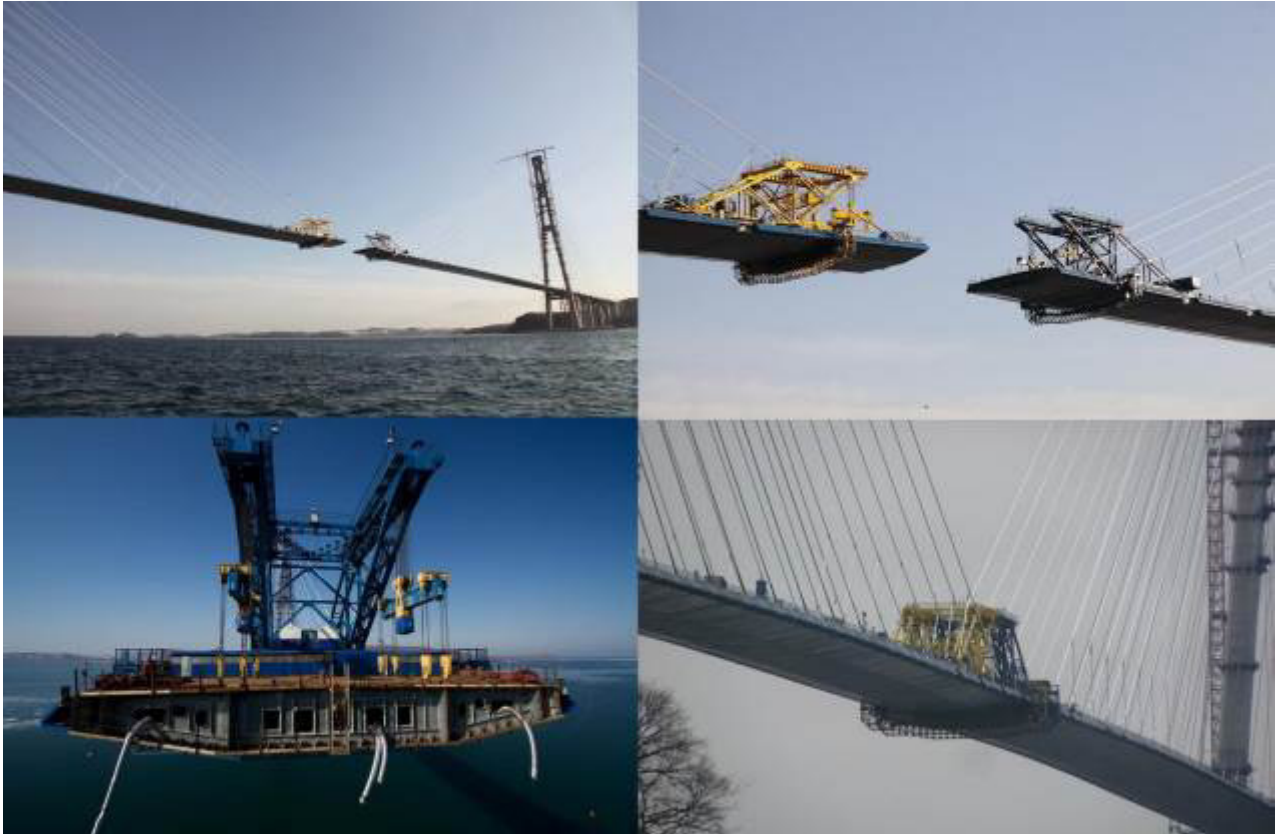
Рис. 3.31. Монтаж балок жорсткості вантового моста на острів Російський
