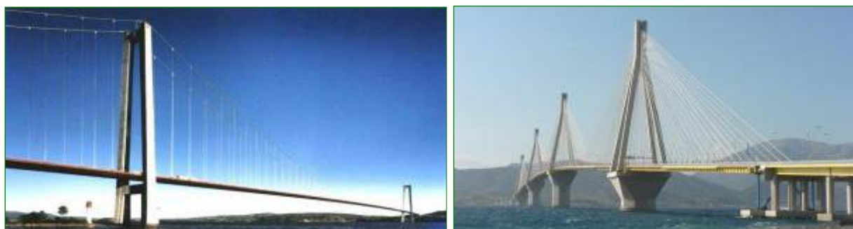
Рис. 3.13. Мости у Швеції та Греції без спирання балок на пілони (повністю ізольовані від пілонів балки жорсткості, пов'язані з ними лише пружними демпферами, призначеними для сприйняття сейсмічного навантаження)
