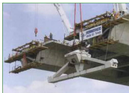
Рис. 7.5. Схеми перерізів балки твердості. Етап монтажу дельтаподібної рами
