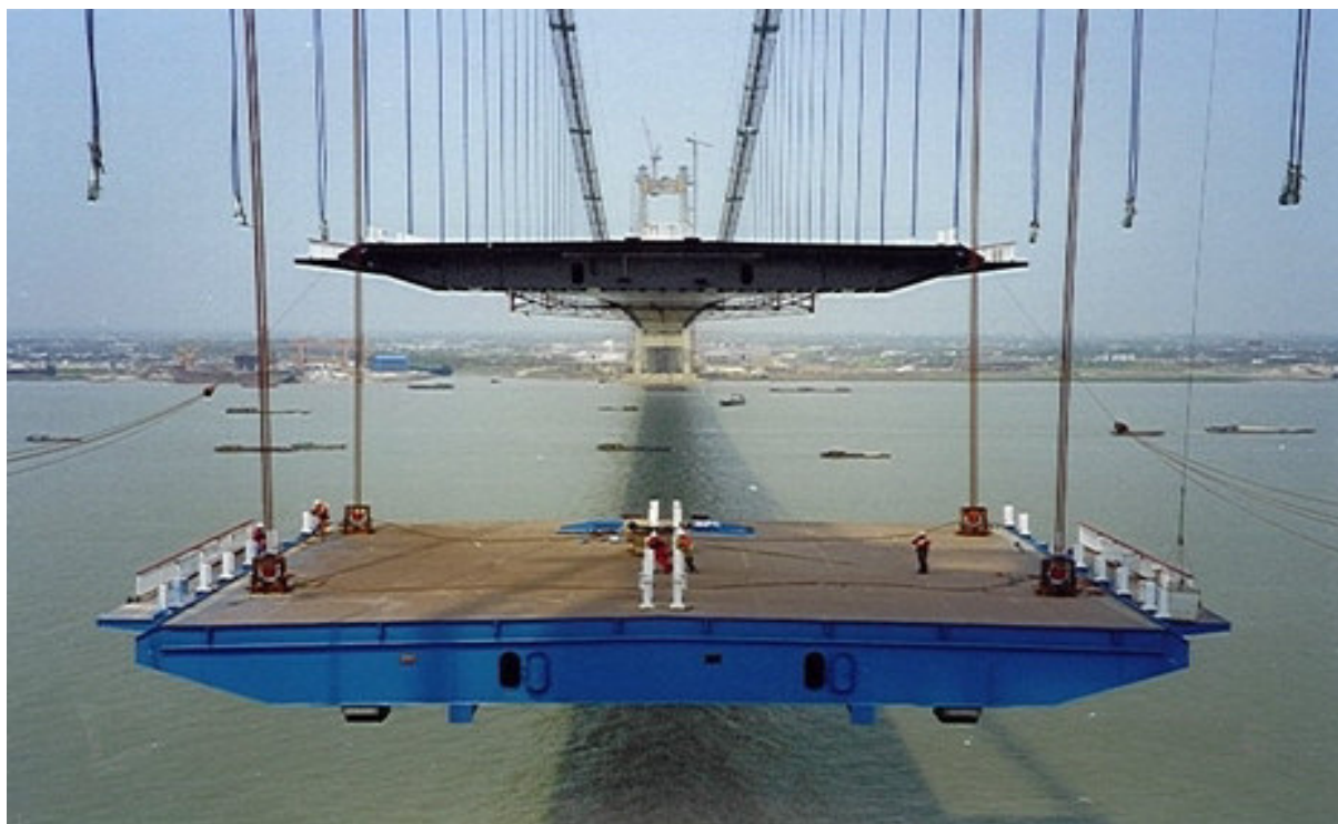
Рис. 9. Монтування елемента прогонової будови моста Цзян'їнь
