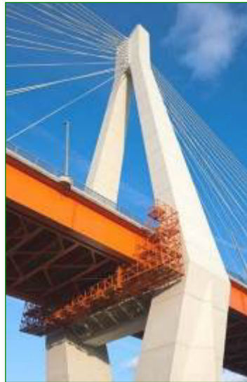
Рис. 8.20. Жорсткий пілон мосту через Оку біля Мурому
