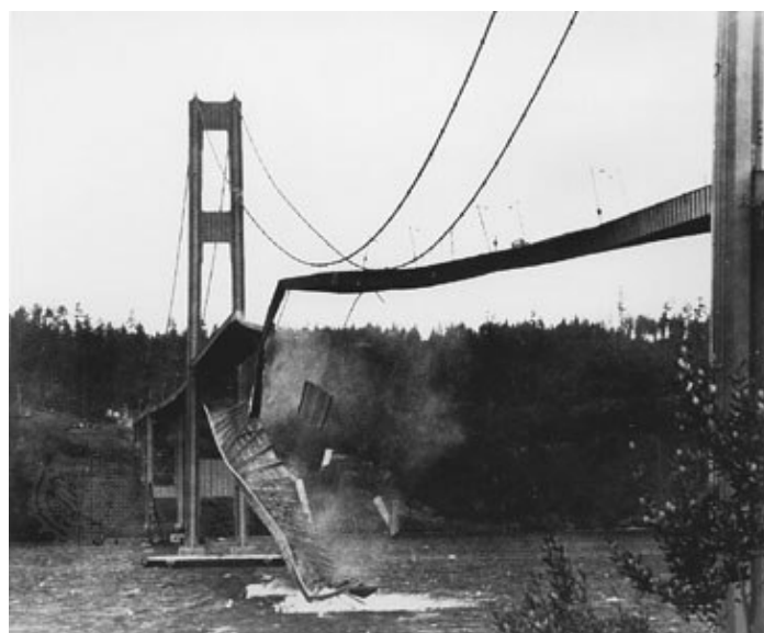
Рис. 43. Момент руйнування головного прогону Такомського моста (США)
