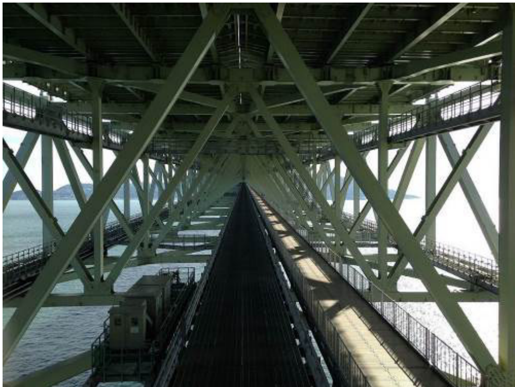
Рис. 3. Конструкція прогонової будови мосту Акасі в Японії
