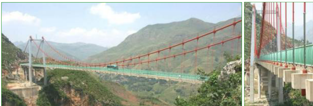
Рис. 4.27. Підвісний міст із залізобетонною балкою жорсткості в Китаї
