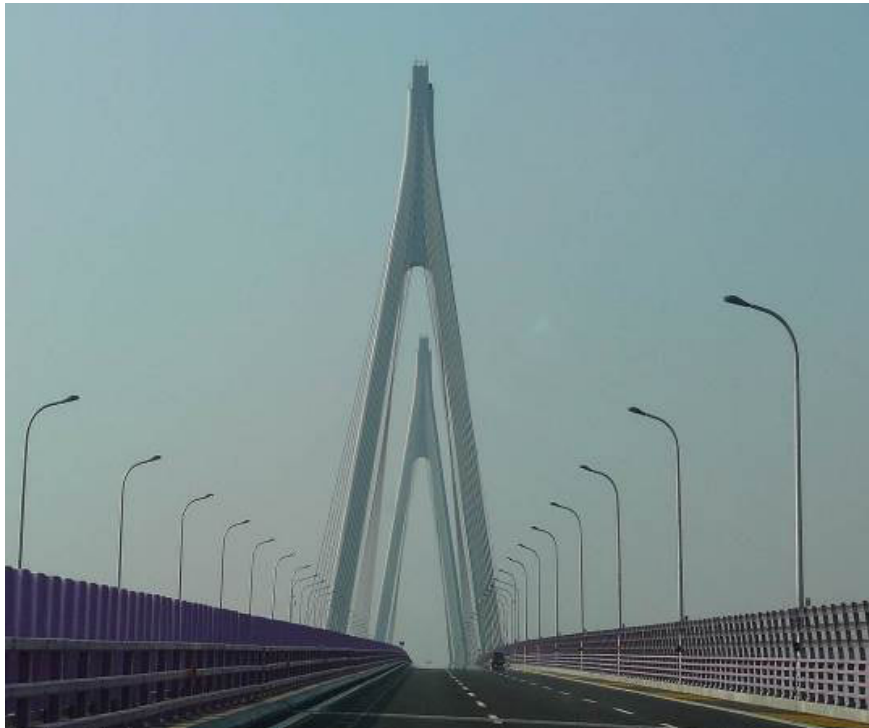
Рис. 115. Міст через затоку Ханчжоувань (Китай)
