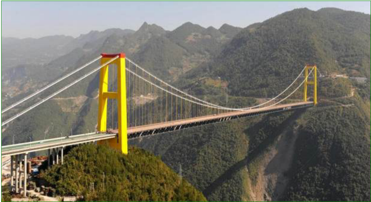
Рис. 4.1. Підвісний однопрогоновий міст Сі Ду в Китаї (висота моста 496 м – один із найвищих мостів у світі, довжина прогону 900 м)
