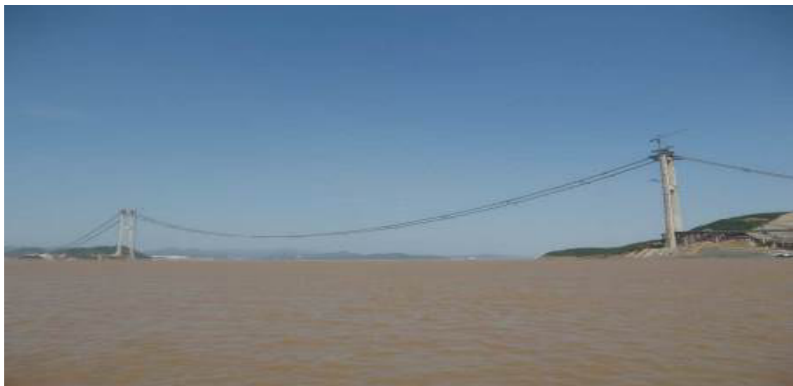
Рис. 6. Процес будівництва підвісного мосту Сіхоумень
