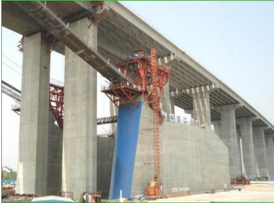
Рис. 3.18. Анкерна опора багатопрогенового підвісного мосту Тайджоу (Китай) у процесі будівництва
