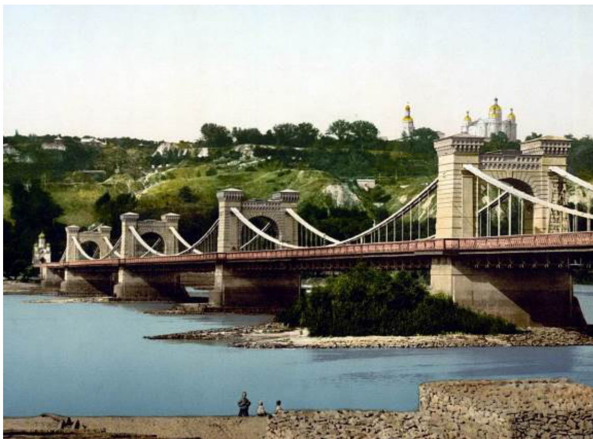
Рис. 1.29. Вигляд на Ланцюговий міст з лівого берега Дніпра, між 1890 та 1898 роками
