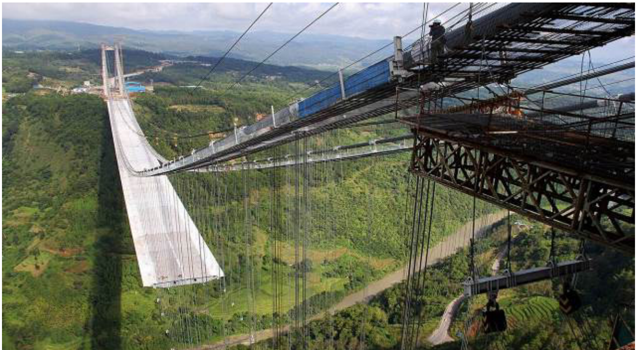
Рис. 36. Вид на процес монтажу прогонової будови моста Лунцзян (Китай)
