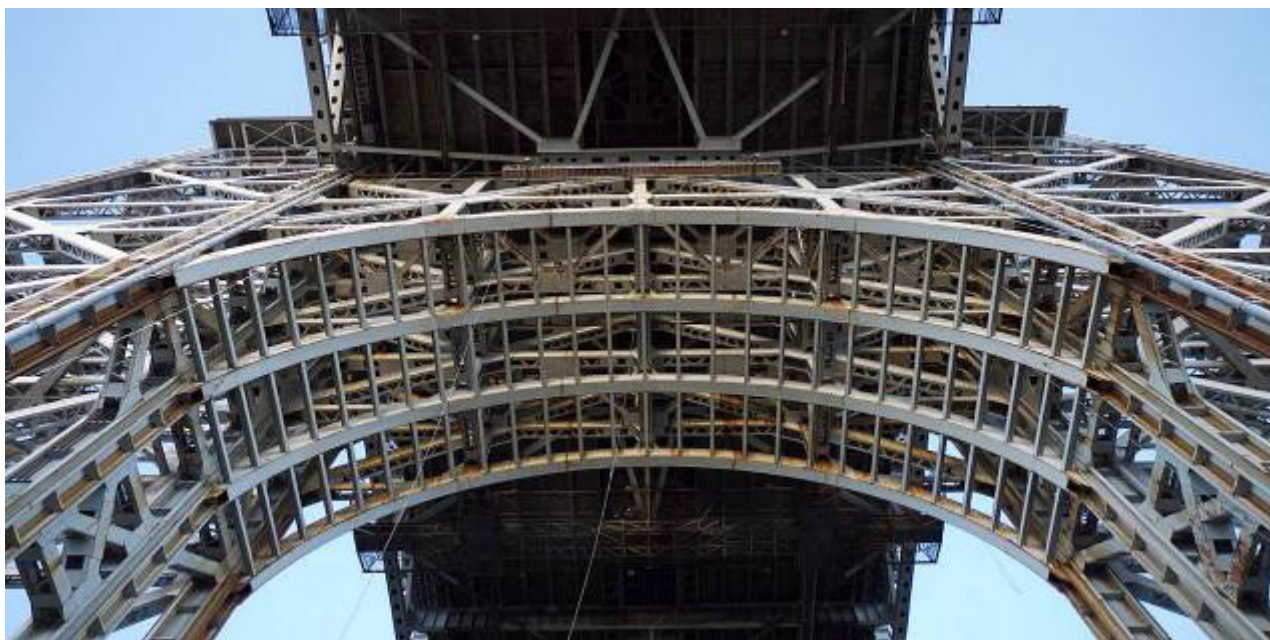
Рис. 26. Міст Джорджа Вашингтона (США). Металеві конструкції пілону
