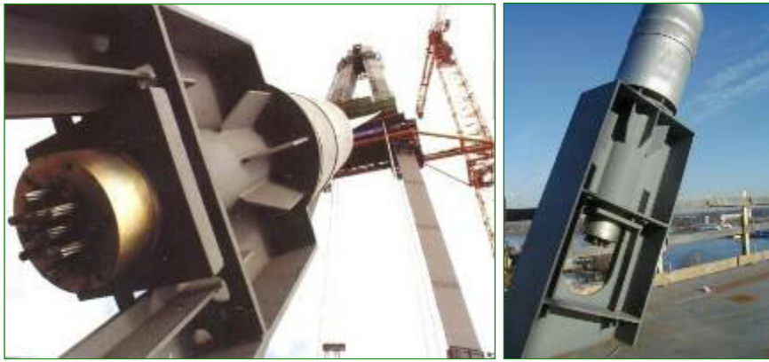
Рис. 3.4. Кінцевий анкер та опорна плита вант
