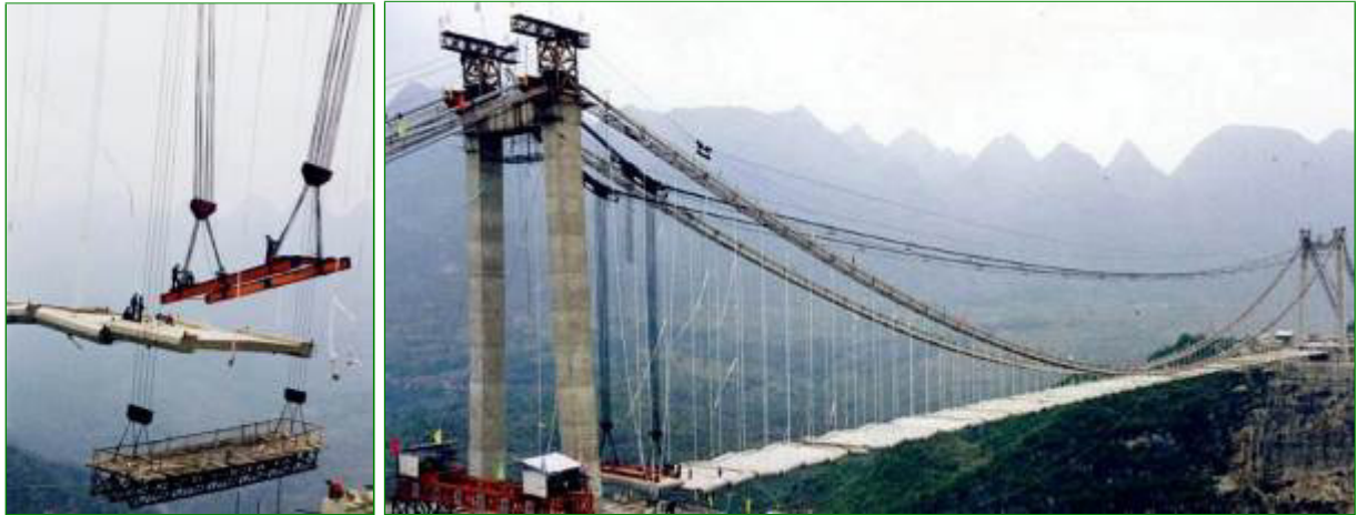
Рис. 4.5. Складання залізобетонної балки жорсткості підвісного мосту в Китаї (введення тимчасових шарнірів)
