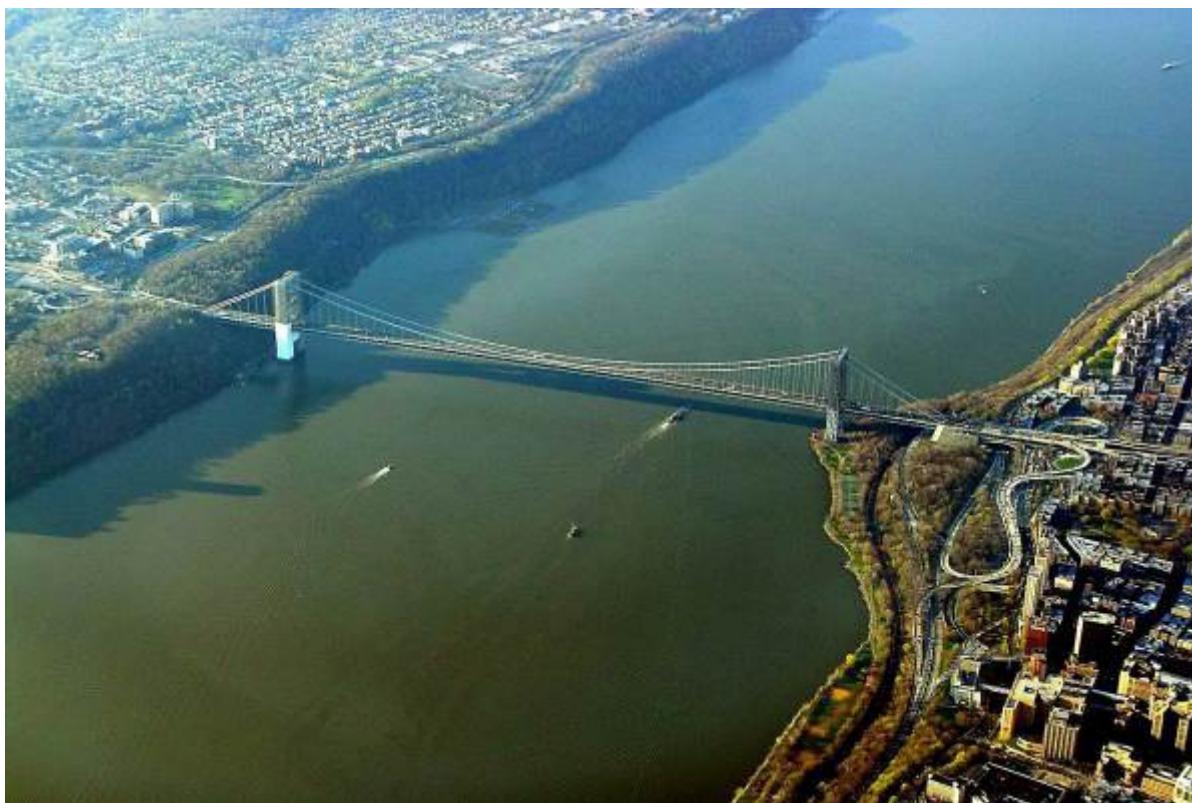
Рис. 25. Міст Джорджа Вашингтона (США). Аерознімок мосту
