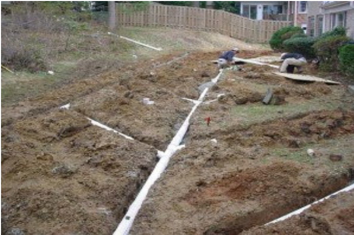
Рис. 3.15. Укладання дренажних труб з гравійною обсіпкою у геотекстильному чохлі у траншеї
