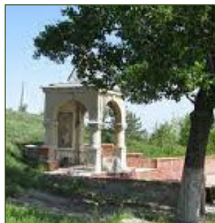
Рис. 2.5. Шахтовий колодязь: а ) у розрізі; б ) зовнішній вид; 1 – водоприймальна частина (через дно і (або) через стінки); 2 – ствол; 3 – глиняний замок; 4 – коловорот; 5 – шатровий дах; 6 – відмостка; 7 – водоносна порода; 8 – водоупорний пласт
