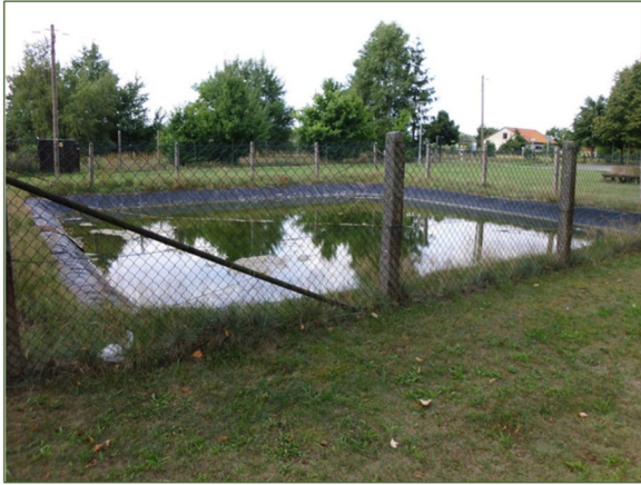
Рис. 2.20. Загальний вигляд пожежної водойми ( a ) та знаків для її маркування ( б )
