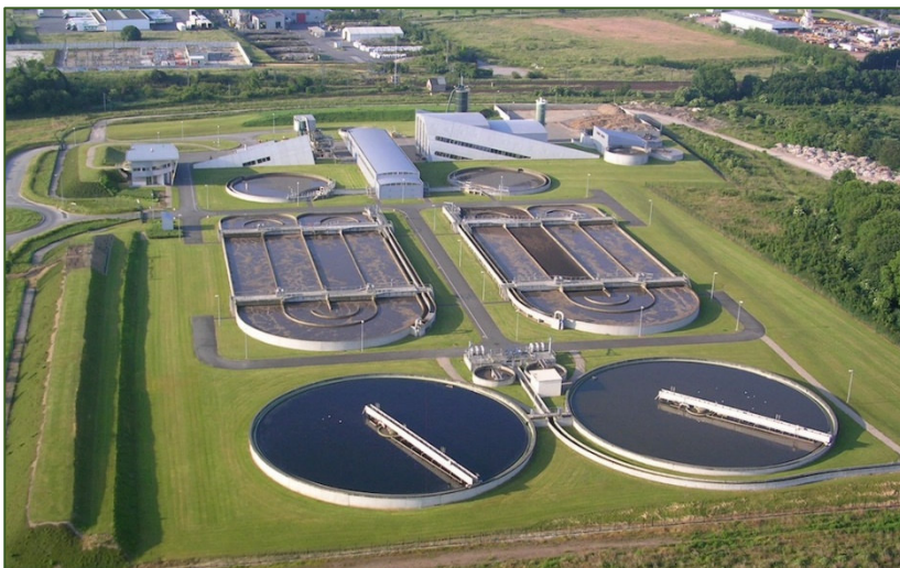
Рис. 3.2. Загальний вигляд майданчика КОС з аеротенками коридорного типу, вертикальними первинними і радіальними вторинними відстійниками та будівлями механічної очистки
