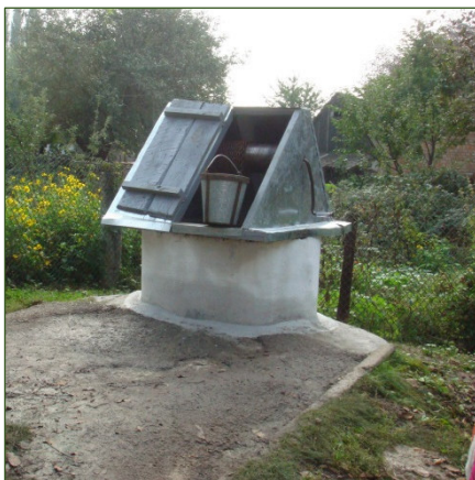
Рис. 2.5. Шахтовий колодязь: а ) у розрізі; б ) зовнішній вид; 1 – водоприймальна частина (через дно і (або) через стінки); 2 – ствол; 3 – глиняний замок; 4 – коловорот; 5 – шатровий дах; 6 – відмостка; 7 – водоносна порода; 8 – водоупорний пласт
