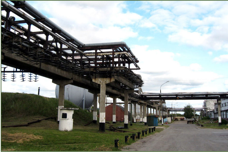
Рис. 5.5. Надземне прокладання мереж на високих опорах
