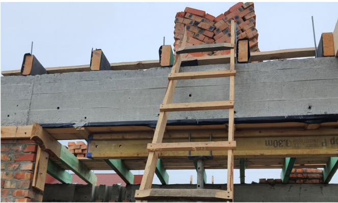
Рис. 1. Натурна балка покриття, для якої проводилось визначення міцності бетону
