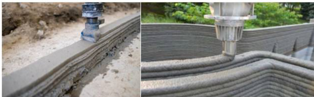
Рис. 1. Пошарове укладання будівельної суміші за допомогою 3D-принтера
