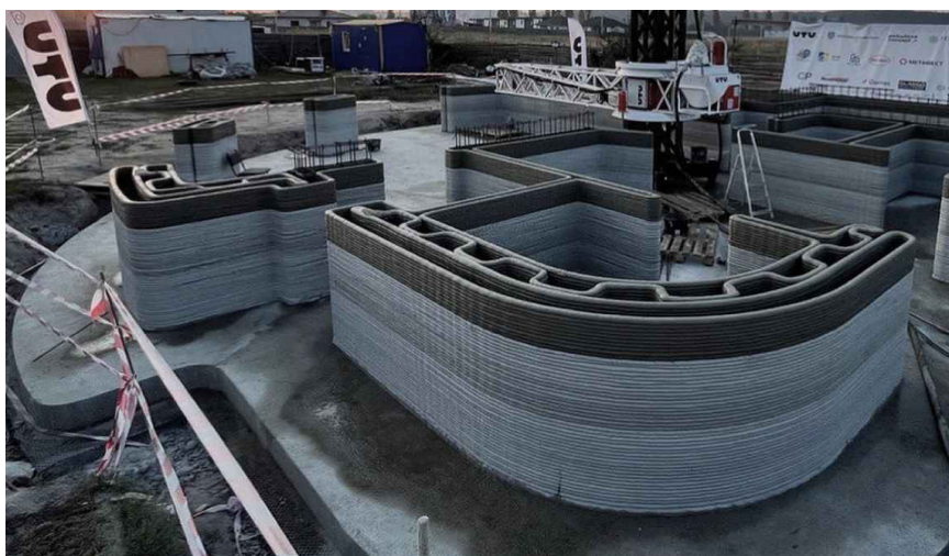
Рис. 2. Будівельний 3D-принтера компанії UTU
