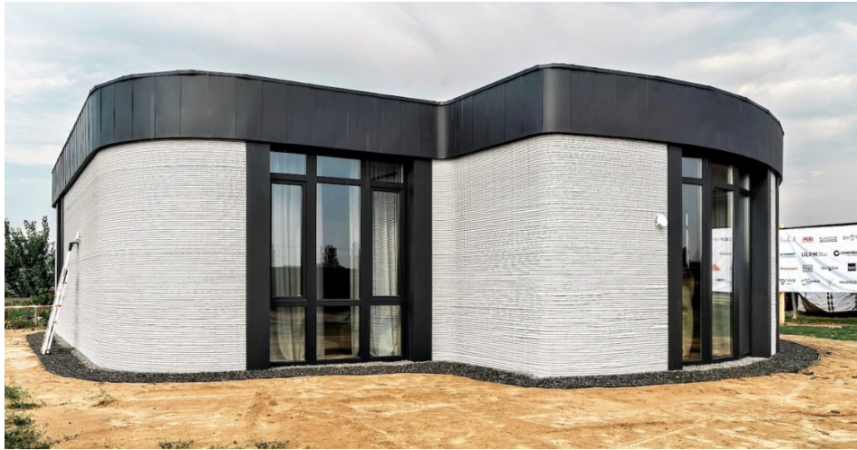
Рис. 3. Будинок зведений за допомогою 3D-принтера
