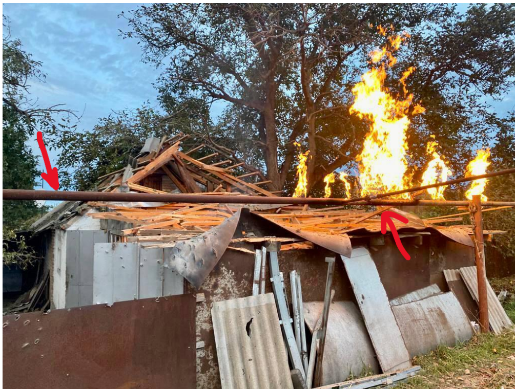
Рис. 1.5. Руйнування житлових будинків на Нікопольщині [6].
