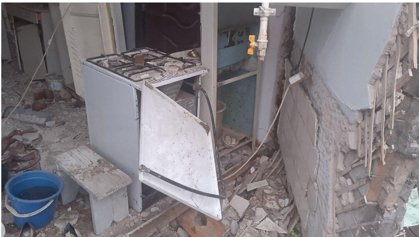
Рис. 2.2. Наслідки вибуху в житловому будинку (система газопостачання) [35].
