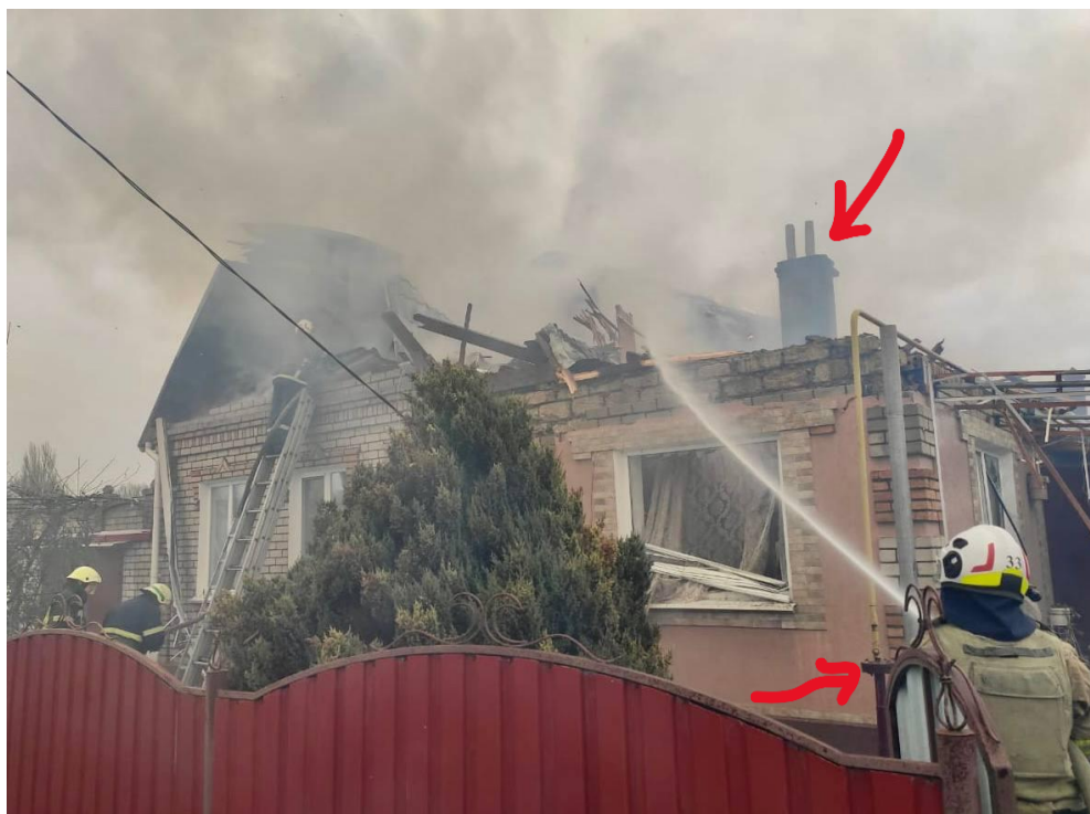
Рис. 1.2. Пошкодження житлового будинку та систем газопостачання і вентиляції (Нікопольщина) [3].
