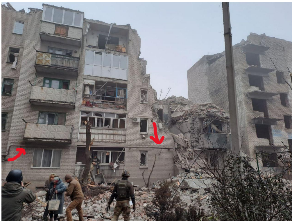
Рис. 1.4. Зруйнований під'їзд п'ятиповерхівки Часів Яр на Донеччині [5].
