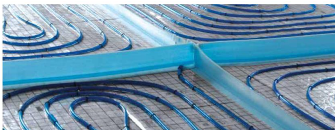
Рис. 14. Поділ гріючої поверхні демпферними швами
