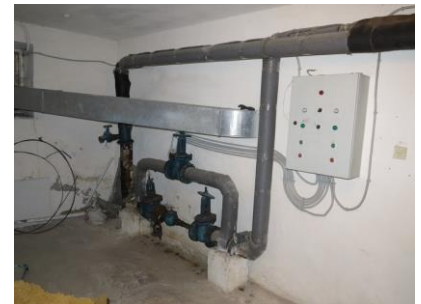
Рис. 2.9. Стан системи теплопостачання (ІТП) гуртожитку №2 НУВГП
