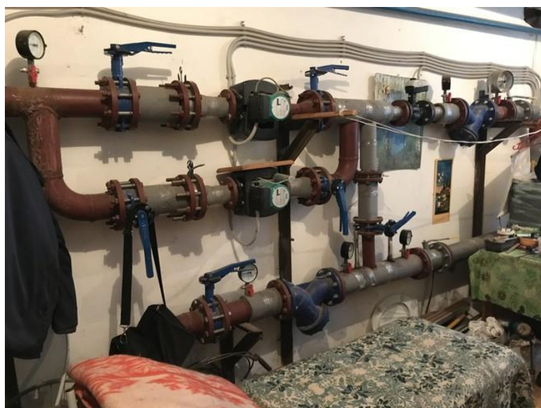
Рис. 2.4. Стан системи теплопостачання (ІТП) гуртожитку №1 НУВГП
