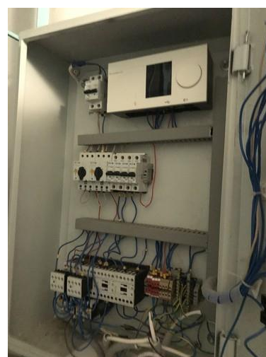
Рис. 2.17. Стан системи теплопостачання (ІТП) гуртожитку №4 НУВГП
