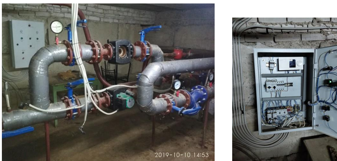
Рис. 2.20. Стан системи теплопостачання (ІТП) гуртожитку №5 НУВГП
