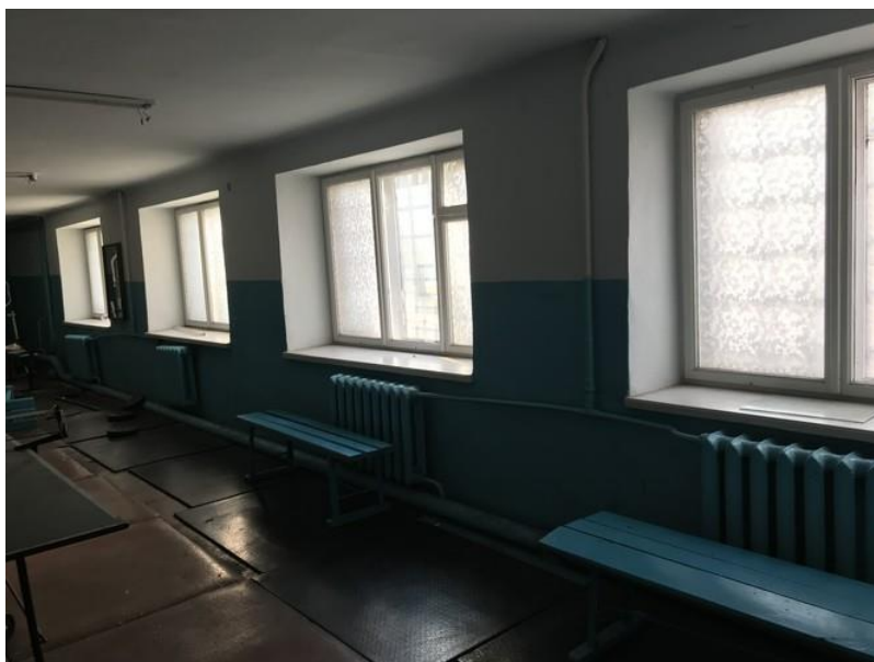
Рис. 2.3. Стан системи опалення гуртожитку №1 НУВГП
