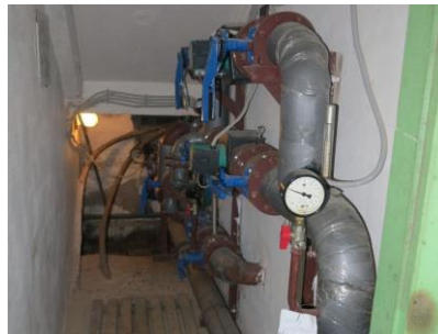
Рис. 2.9. Стан системи теплопостачання (ІТП) гуртожитку №2 НУВГП
