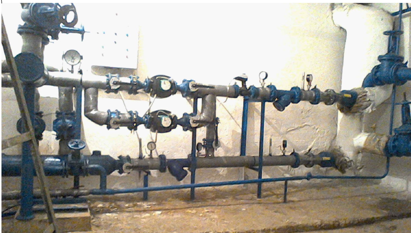
Автоматизований вузол регулювання теплової енергії
