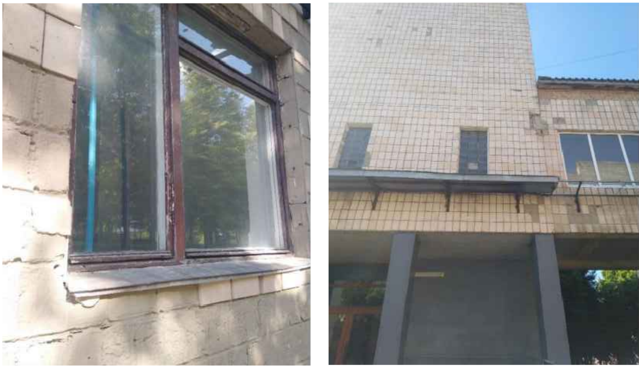
Віконні блоки замінити на енергозберігаючі
