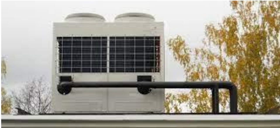
Рис. Варіант розміщення випаровувача на даху котельної
