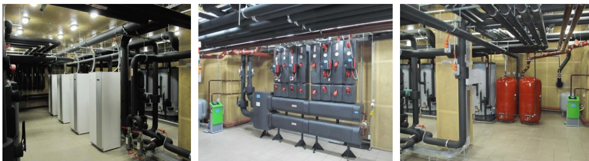
Рис. 4.10 Система генерації тепла / холоду і ГВП з використанням теплових насосів.
