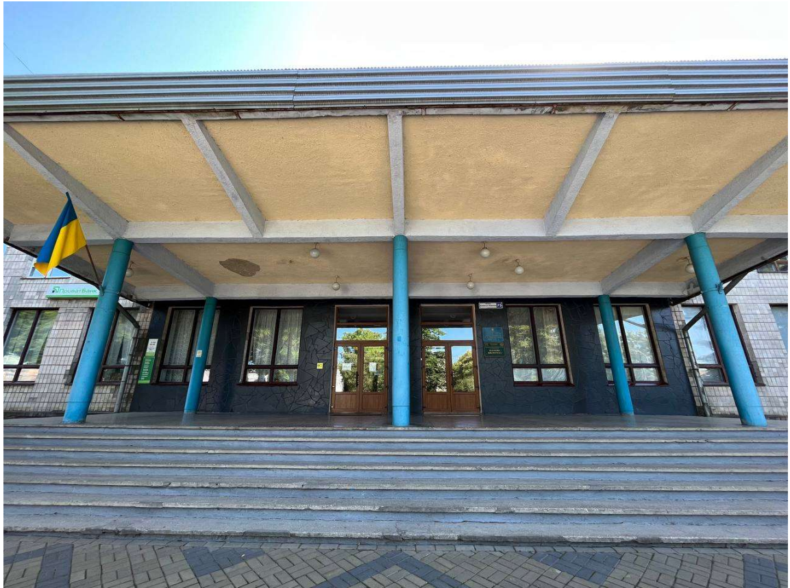
Рисунок 2.1 Зовнішній вигляд корпусу №2 НУВГП
