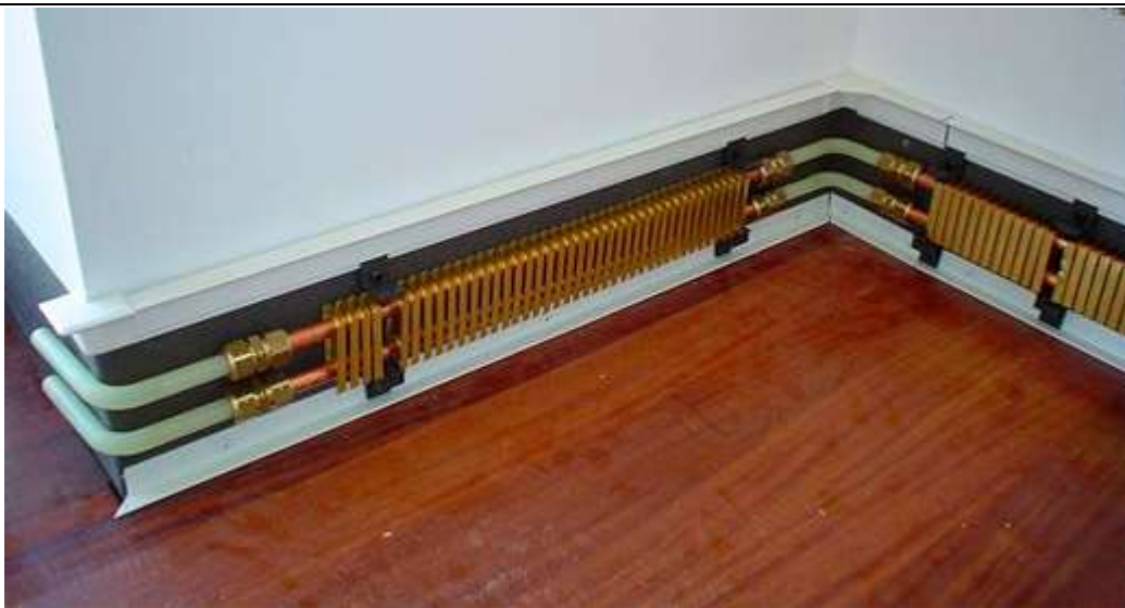
Рис.6.5.1 Плінтусний конвектор без захисного короба
