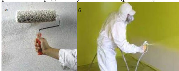
Рис. 7.20. Фарбування стіни: а – валиком; б – пневматичним розпилювачем, https://okraska-profi.com.ua/ua/farbuвання-stin-u-kyievi/
