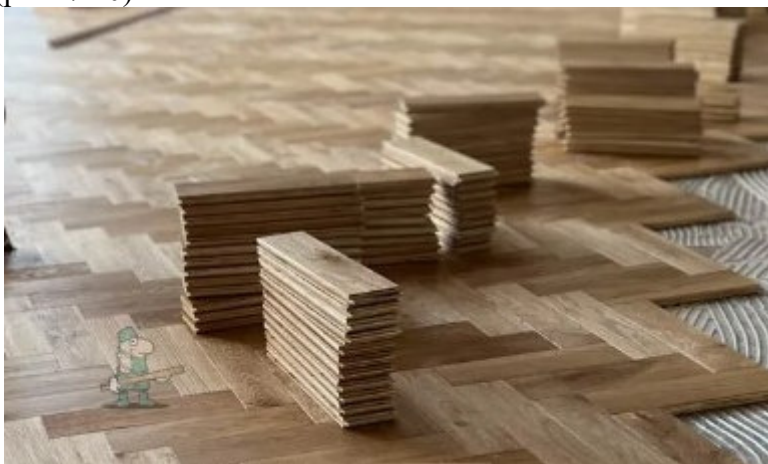
Рис. 7.40. Укладання паркету «ялинкою», https://www.savokusic.com/uk/blog/gra%C4%91evinarstvo/podovi
