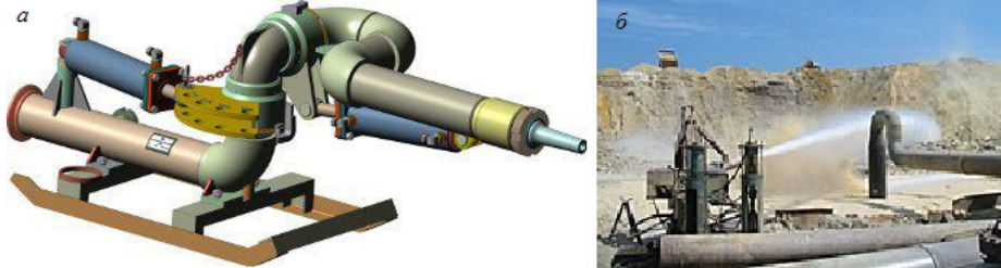
Рис. 2.58. Сучасний гідромонітор з гідравлічним приводом управління (а); розроблення ґрунту гідромонітором (б),
