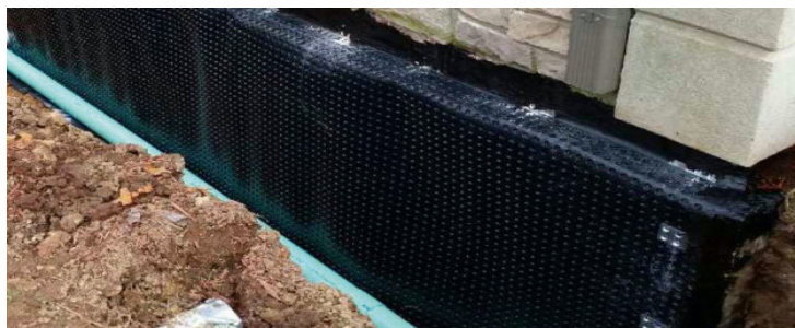
Рис. 7.46. Обклеювальна гідроізоляція вертикальних поверхонь полімерною геомембраною, https://www.maximuscentr.com.ua/hydrozoliatsiya-fundamenta-heopolymernye-membrany/
