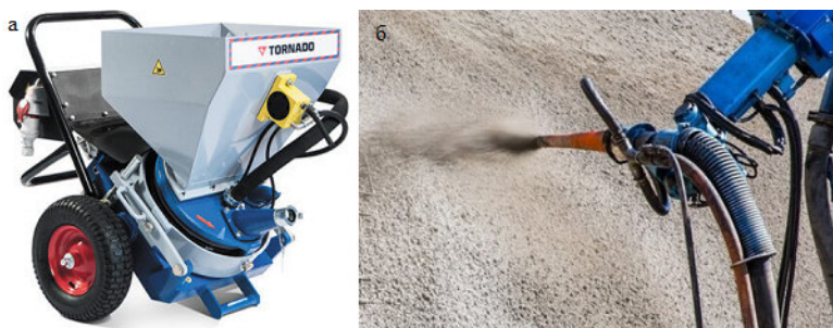
Рис. 7.48. Виконання гідроізоляції методом торкретування: а – торкрет-установка; б – виконання торкретування, https://tornado.torkret.com.ua/products/as-1/ , https://kaskadbeton.com.ua/ru/torkret-beton/
