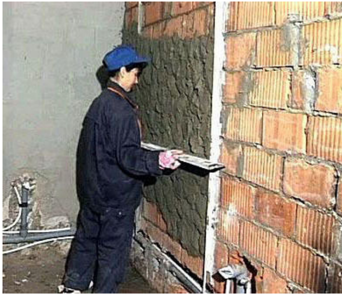
Рис. 7.7. Розрівнювання штукатурного розчину правилом, https://ibud.ua/ua/post/shtukaturnye-raboty-382
