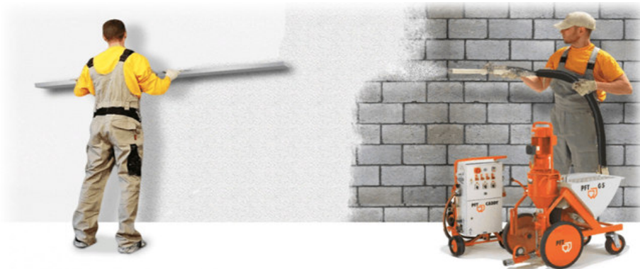
Рис. 7.6. Механізоване нанесення розчину, https://ibud.ua/ua/post/shtukaturnye-raboty-382
