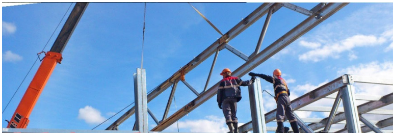
Рис. 6.22. Монтаж металевих ферм,
