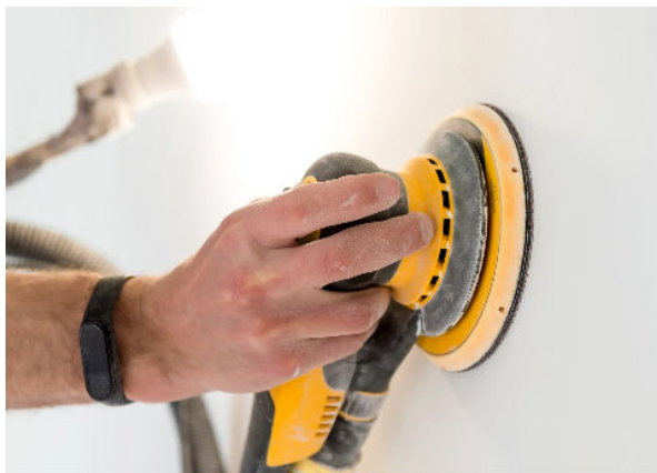
Рис. 7.18. Шліфування стіни електричною шліфувальною
