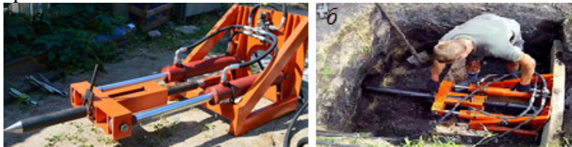
Рис. 2.42. Виконання проколу під дорогою: а – установка для проколу; б – робочий котлован, https://pipemastak.com.ua
