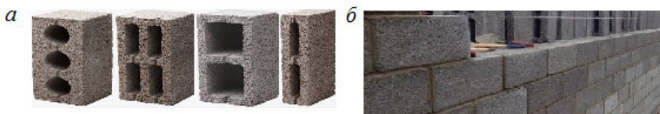
Рис. 5.2. Дрібноблочна кладка: а – форми блоків; б – кладка блоків, https://kontrakty.ua/article/224269
