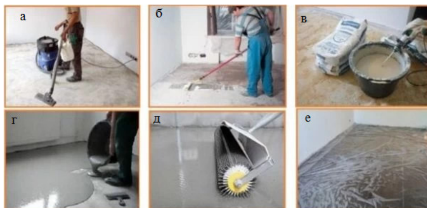
Рис. 7.35. Послідовність облаштування наливної підлоги: а – видалення пилу; б – нанесення ґрунтовки; в – приготування полімерної суміші; г – нанесення суміші на бетонну основу; д – вирівнювання та видалення бульбашок повітря; е – декоративне оздоблення, https://kruizer.com.ua/mokrii-chornovu-pidlogu-vidi-plusi-i-minusi-montaj/
