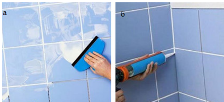
Рис. 7.16. Заповнення швів між плитками: а – гумовим шпателем; б – шприцом, https://remontuem.te.ua/plytochni-roboty/
