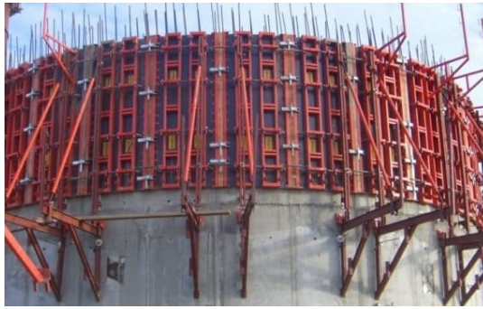
Рис. 4.10. Ковзна опалубка,
