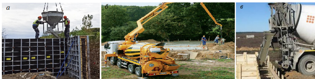
Рис. 4.29. Укладання бетонної суміші: а – краном; б – бетонопомпою; в – автобетонозмішувачем, https://ukraine-standart.com.ua/news/shhitovaya-opalubka-idealnoe-reshenie-dlya-stroitelstva-prochnyh-sten.html
