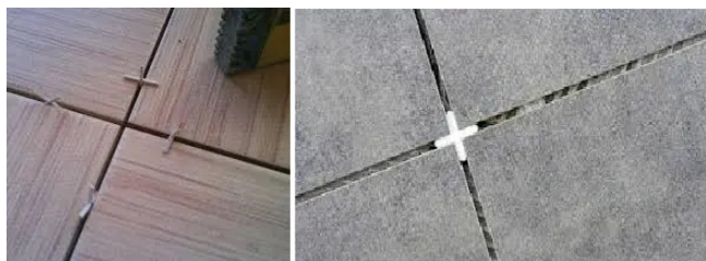
Рис. 7.15. Способи застосування хрестиків для дотримання однакової ширини швів між плитками,
