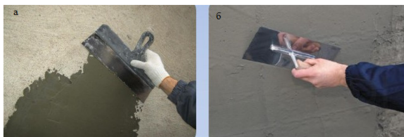
Рис. 7.50. Штукатурна гідроізоляція: а – шпателем; б – теркою, https://ibud.ua/ua/post/vidy-i-kharakteristiki-gidroizolyatsii-oblasti-primeneniya-187
