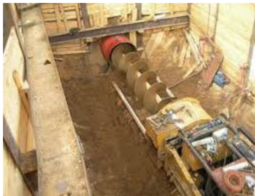
Рис. 2.44. Установка для горизонтального шнекового буріння, https://moodle.znu.edu.ua
