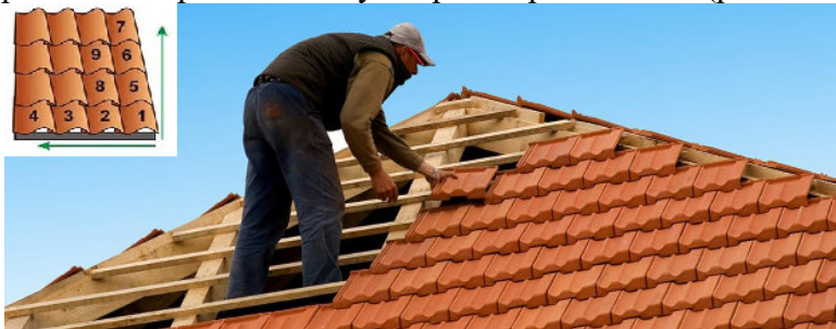
Рис. 7.24. Влаштування даху із керамічної черепиці, https://dahfasad.top/montazh-keramichnoyi-cherepici/
