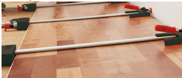
Рис. 7.43. Спеціальні стяжки для вкладання ламінованих панелей, https://remontuem.te.ua/montag-parketnoi-doshky/
