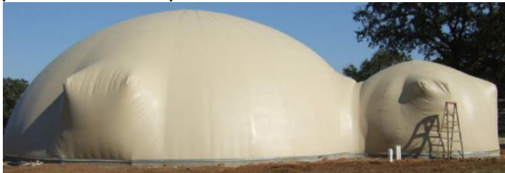
Рис. 4.12. Пневматична опалубка,
