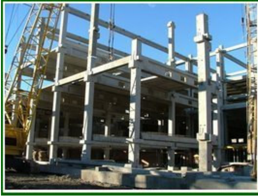
Рис. 6.15. Монтаж колон і балок, http://3betony.com.ua/page-glavnaya
