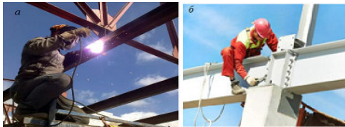
Рис. 6.23. З'єднання елементів металевих конструкцій зварюванням (а), гвинтами (б), https://artbud.kyiv.ua/uslugi/montazhnye-raboty/montazh-metallokonstrukcij/
