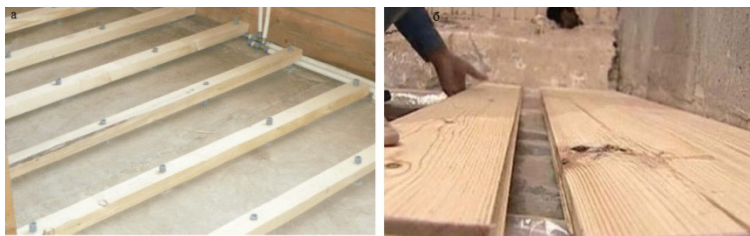
Рис. 7.38. Влаштування підлоги із дощок: а – розташування лаг; б – укладання дощок, https://stroy-blog.info/uk/derev-jana-pidloga-materiali-ukladannja-dogljad/
