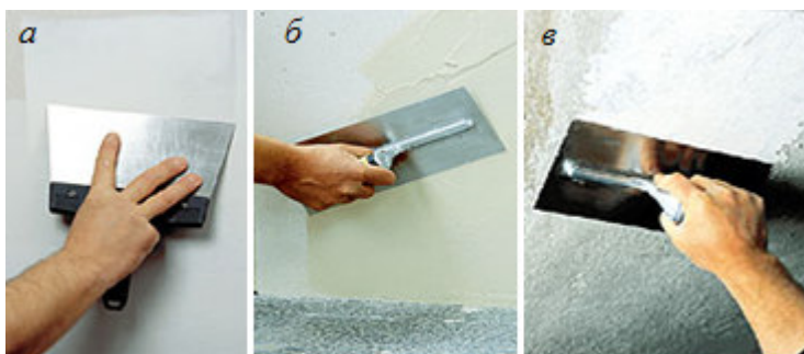
Рис. 7.9. Нанесення шпаклювальної суміші шпателем (а) і металевою теркою (б, в)
