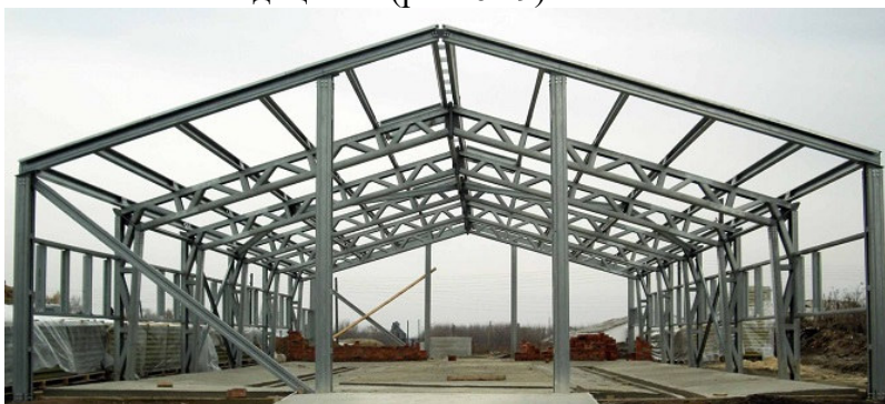
Рис. 6.19. Загальний вигляд каркасу будівлі із металевих конструкцій, https://www.promstan.com.ua/ua/services/montazh-metallokonstruktsij
