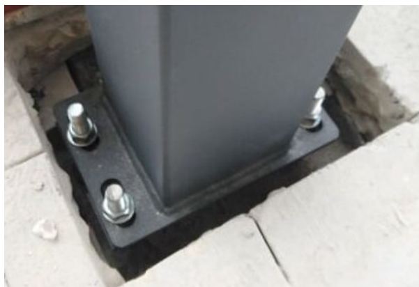
Рис. 6.21. Анкерні гвинти у фундаменті, https://metallservice.com.ua/uk/sposobi-kriplennya-metalokonstruktsij.html
