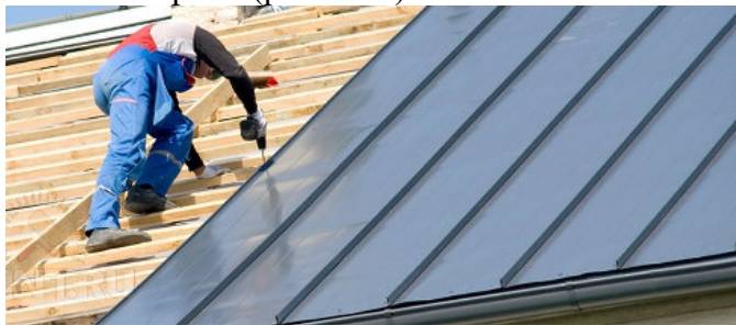
Рис. 7.28. Влаштування металевої фальцевої покрівлі, https://keramodim.com.ua/blog/ustrojstvo-i-montazh-falcevoj-krovli.html
