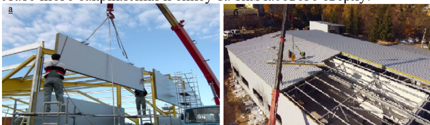
Рис. 6.18. Монтаж стінових панелей і плит покриття
