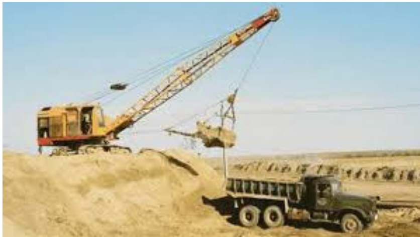
Рис. 2.36. Розроблення котловану екскаватором з робочим обладнанням драглайн із розвантаженням ґрунту в транспортні засоби
