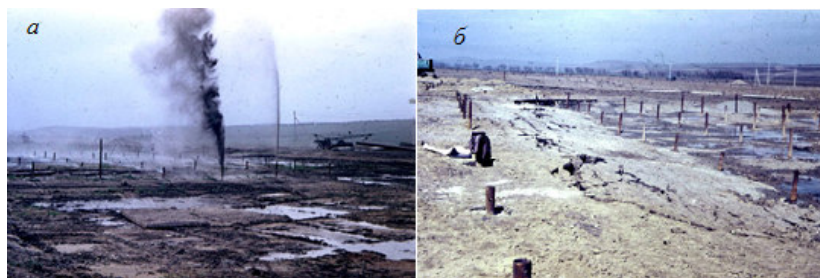
Рис. 2.54. Ущільнення лесового ґрунту гідровибухом: а – до вибуху; б – після вибуху, http://www.niisk.com
