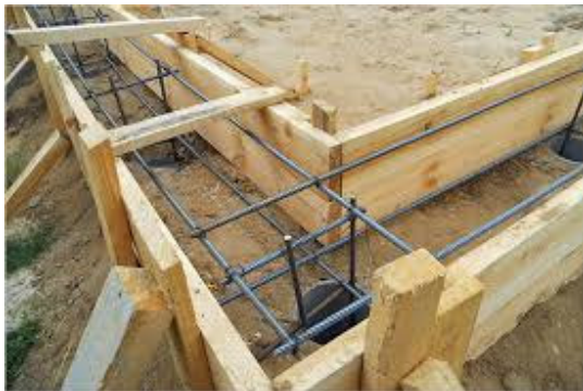
Рис. 4.3. Дерев'яна опалубка, https://yak.koshachek.com/articles/derev-jana-opalubka-svoimi-rukami-vigotovlennja-ta.html#google_vignette
