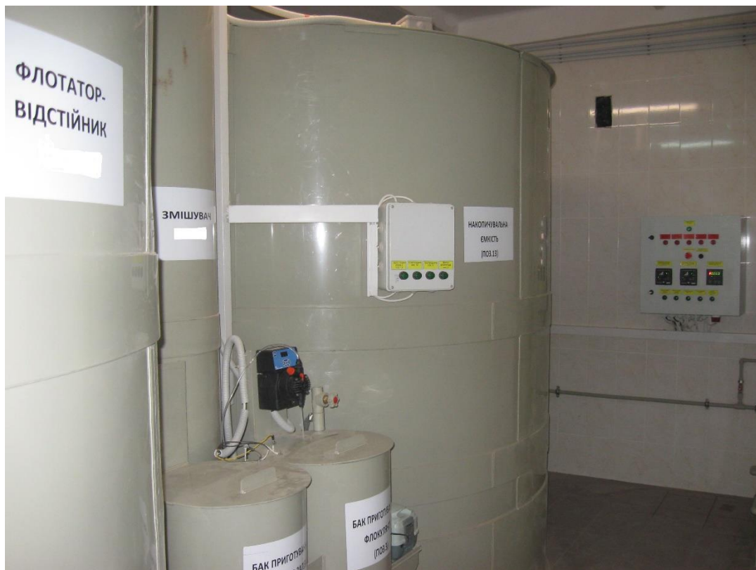
Рис. 3.28. Флотатор-відстійник та змішувач на промисловому модулі глибокого фізико-хімічного доочищення
