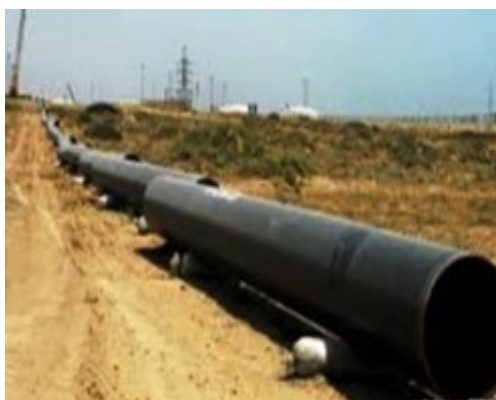
Рис. 3.109. Розкладання труб вздовж траншеї
