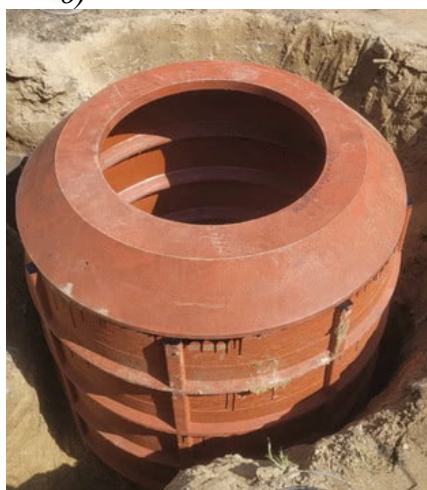
Рис. 1.36. Оглядові колодязі: а – з пластику, [1]; б – полімерний (розбірний) дренажний колодязь VULKAN, vul-kan.com/ , Україна
