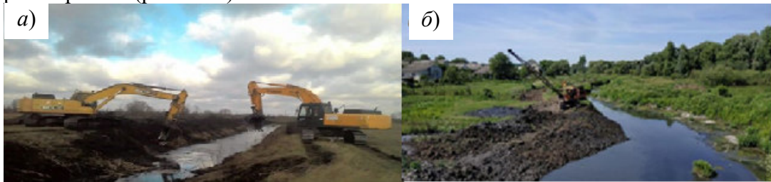
Рис. 7.23. Розширення русла річки однокішневим екскаватором з робочим обладнанням: а – зворотна лопата ( https://pmk77.com/ru/uslugy/gydrosooruzhenyya-beregoukreplenye/ ); б – драглайн ( https://rovrkhm.gov.ua/ )
