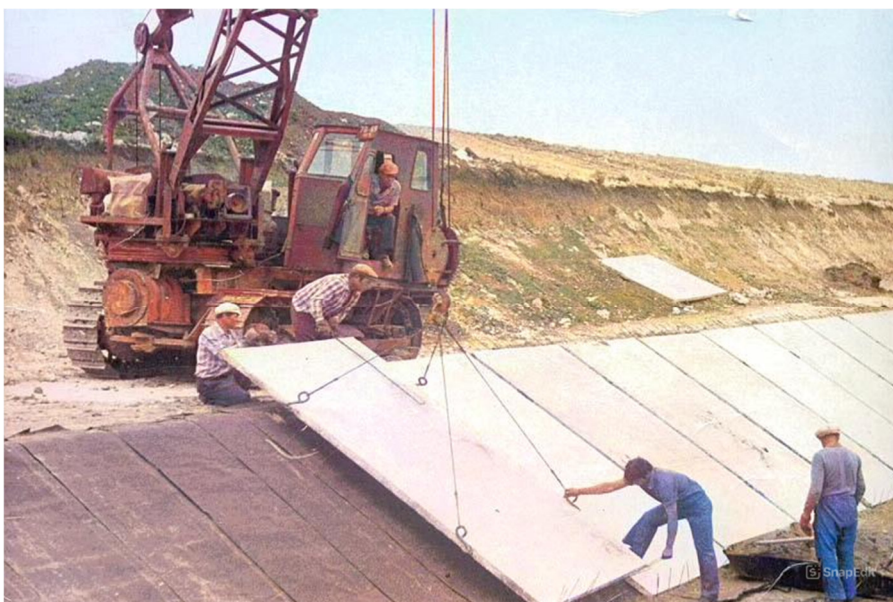
Рис. 3.34. Вкладання залізобетонних плит тракторним краном на укоси каналу з допомогою чотирьох гілкового стропу, [1] кольоризоване ШІ
