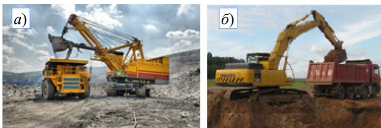
Рис. 2.13. Розроблення ґрунту в кар'єрі однокішшовими екскаваторами з робочим обладнанням: а – пряма лопата, джерело https://strobbe.com.pe/ ; б – зворотна лопата, джерело: https://prom.ua/ua/p1599545-razrabotki-grunta-kieve.html
