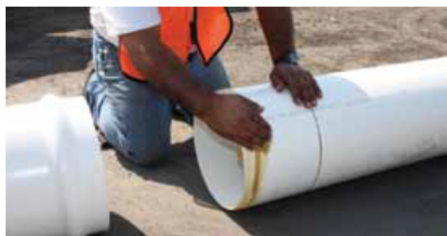
Рис. 3.104. Змащування рідким милом гладкого кінця труби», [1]
