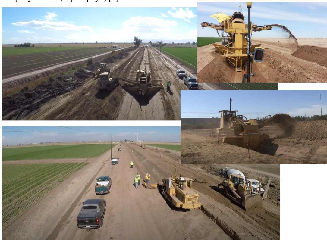
Рис. 3.13. Розробка русла каналу на ділянці в насипу роторним багатоківшевим екскаватором Eagle 6300 з пасивними укісниками: відео youtu.be/8DAc94TsDAA , youtu.be/j7TNK0tBzFc
