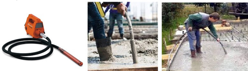
Рис. 5.35. Вібратори з гнучким валом для ущільнення бетонної суміші ( https://ukrsnab.com.ua/blog/stati-pro-vibratory-dlya-betona.html ; https://flagma.ua/uk/products/betonni-roboty/vinnickayaoblast/ )
