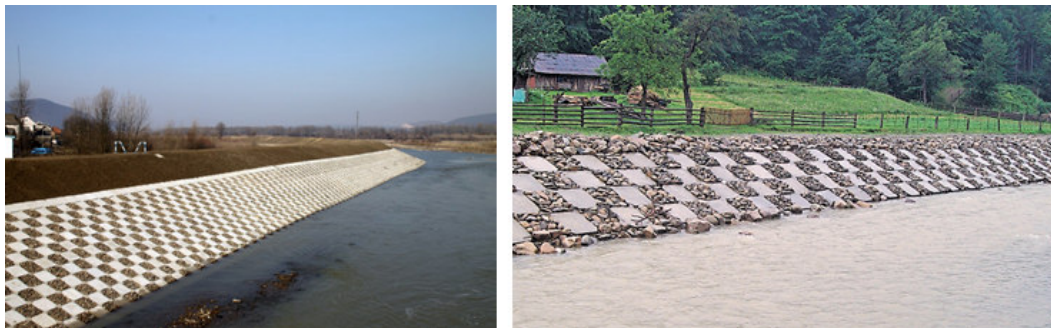
Рис. 6.12. Комбіноване кріплення берега ( https://ukurier.gov.ua/uk/articles/vasil-stashuk-pitannya-yakosti-vodnih-resursiv-nal/ )
