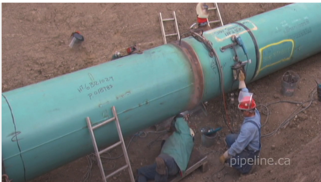
Рис. 3.117. Формування стикового шва вручну, www.youtube.com/@CanadianPipeliners https://youtu.be/HGTASZE9aMk
