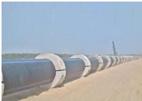
Рис. 3.134, Б. Прямокутні та круглі анкерні блоки (Anchor Blocks), фото з сайту https://www.indomer.com/ , дата доступу 10.01.2025 р.
