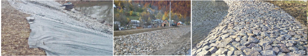
Рис. 6.3. Кріплення берега відсипкою бутового каменю та вимощуванням ( https://ligarost.com.ua/stati-uk/privatne-budivnytstvo-ukriplennia-bereha )
