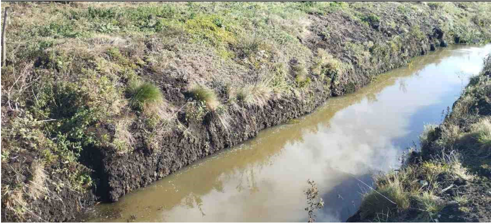
Рис. 1.22. Руйнування укосів каналу при недотриманні закладання укосів та відсутності кріплення, фото автора, Радехів, Шептицький район Львівської області
