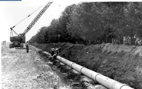
Рис. 3.95. Монтаж залізобетонних труб з допомогою захвата Kenco PL8500 Pipe Lift і штовхача, https://kenco.com/products/pipe-lift/photos-videos/
