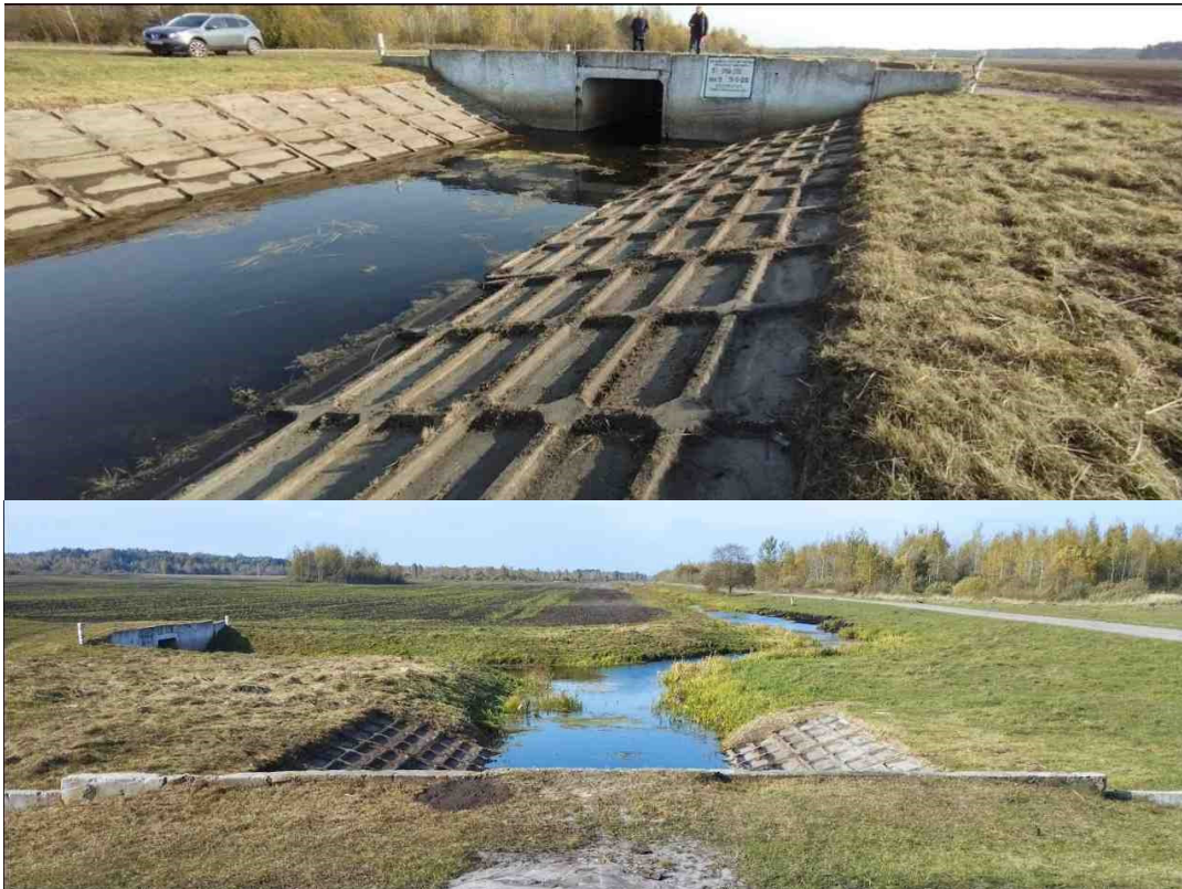
Рис. 1.23. Кріплення нижньої частини каналу залізобетонними плитами, фото автора, Кричевичі, Ковельський район Волинській області
