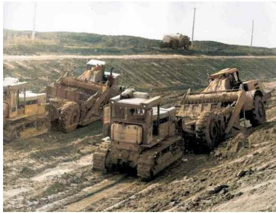
Рис. 3.5. Розробка каналу на ділянці у виїмці самохідними скреперами, [1]
