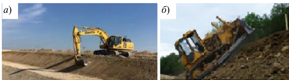
Рис. 2.23. Планування укосів греблі: а – екскаватором ( https://lens.google.com/search?ep=gisbubb&hl=ru-UA&re=df&p=AbrfA8qL ); б – бульдозером ( https://youtu.be/c9Dfqk-A5go )
