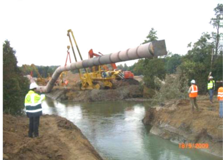
Рис. 3.131, Б. Опускання трубопроводу через водну перешкоду, From Nuova Ghizzoni S.p.A. ( www.ghizzonispa.com ), https://www.northfieldma.gov/sites/g/files/vyhli991/f/uploads/intro_to_gas_pipeline_presentation_of_5-26-15_part_2.pdf
