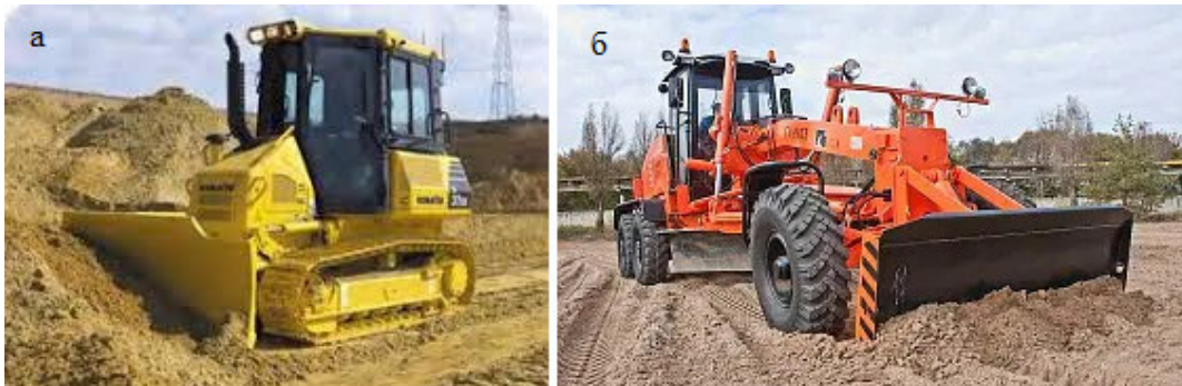
Рис. 7.9. Розрівнювання ґрунту: а – бульдозером ( https://dspace.library.khai.edu/xmlui/bitstream/handle/123456789/3398/Glazkov.pdf? ); б – грейдером ( https://0442332290.kiev.ua/ua/p40978774 )
