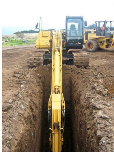
Рис. 3.68. Розробка траншеї екскаватором «зворотна лопата», [1]
