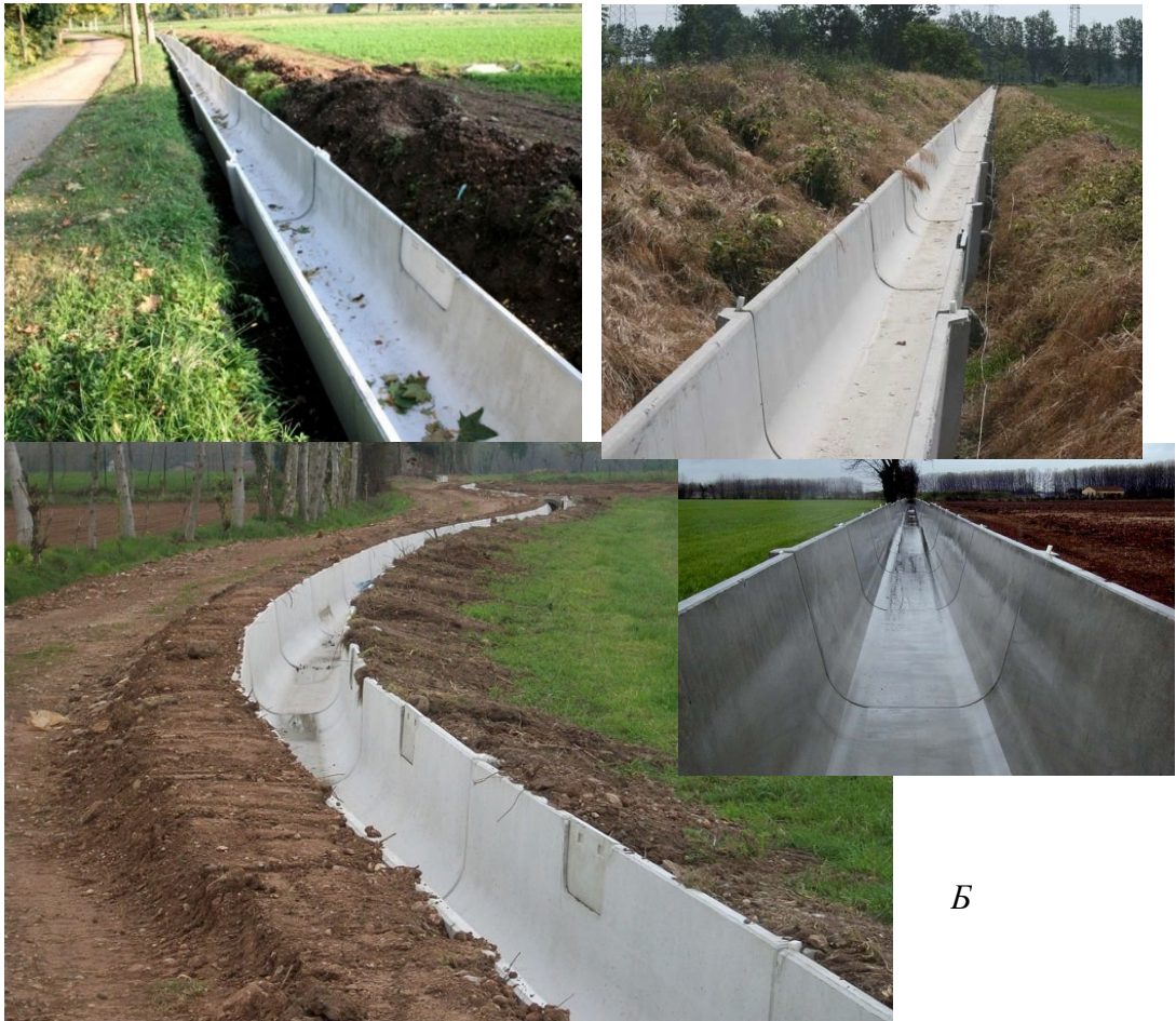
Рис. 3.59, Б. Приклади будівництва лоткових каналів на опорних плитах виробництва Fattori, Італія: https://www.gffattori.com/prefabbricati-irrigazione/canali-irrigazione.html
