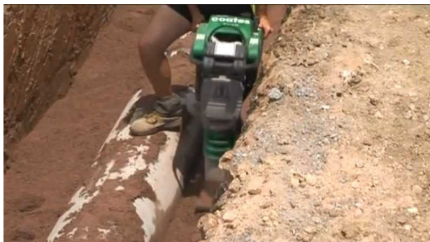
Рис. 3.125. Ущільнення ґрунту в затрубному просторі ручною електротрамбівкою, https://youtu.be/31tOCs2PTwc
