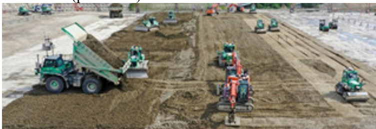
Рис. 2.18. Будівництво греблі при транспортуванні ґрунту автосамоскидами, [1]
