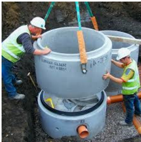
Рис. 5.14. Монтаж залізобетонного колодязя ( https://info-bud.com.ua/materialy-dlya-kanalizatsionnogo-kolodca-rassmatrivaem-podrobno/ )
