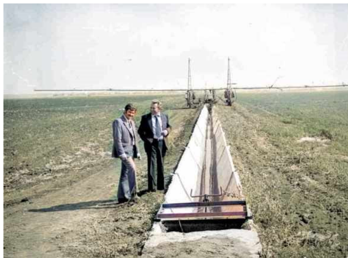
Рис. 3.59, А. «Лотковий канал на опорних плитах», [1], кольоризоване ШІ
