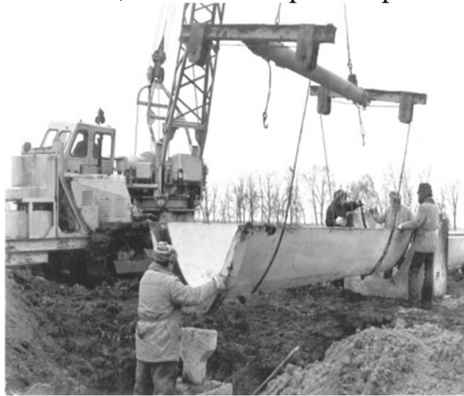
Рис. 3.61. Монтаж лотків з допомогою спеціальної поворотної траверси, [1]
