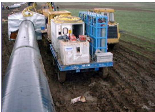
Рис. 3.119. Комплекс для автоматичного зварювання сталевих труб
