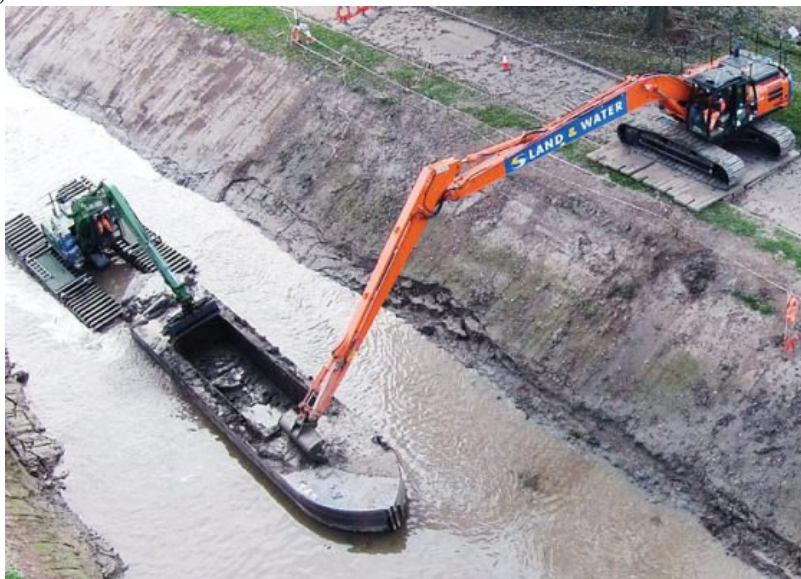
Рис. 1.5. Сумісна робота з очищення каналу (річки) з використанням 38-тонного екскаватора Land & Water з довгим (20 м) вильотом на базі Hitachi ZX350, баржі та малим екскаватором-амфібією Р40, [9]
