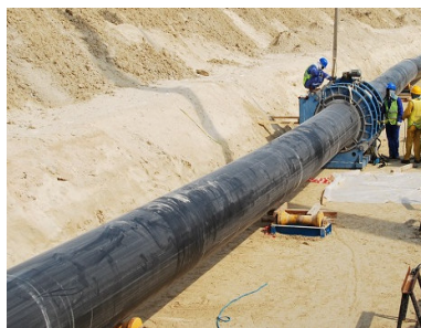
Рис. 3.100. Зварювання пластмасових труб великого діаметра, [1]
