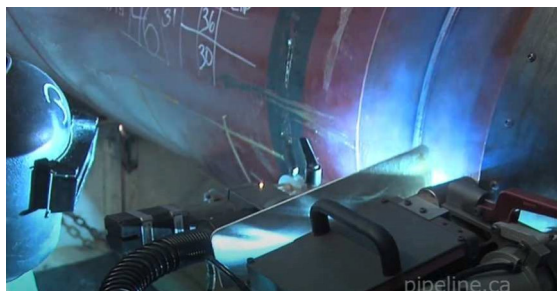
Рис. 3.118. Зварювання труб напівавтоматичною установкою, https://youtu.be/HGTASZE9aMk
