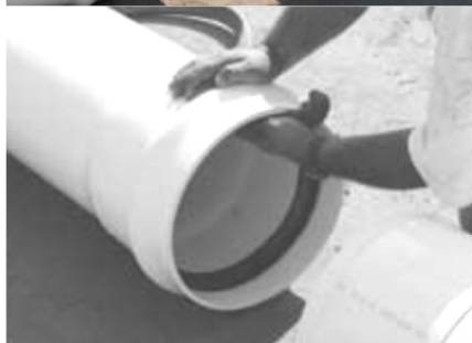
Рис. 3.105. «Змащування гумового кільця», [1].
