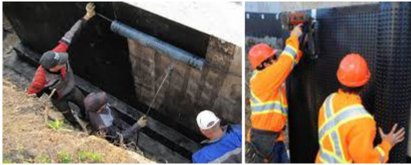
Рис. 7.38. Виконання гідроізоляції фундаменту ( https://dspace.znu.edu.ua/jspui/bitstream/12345/3643/1/ )
