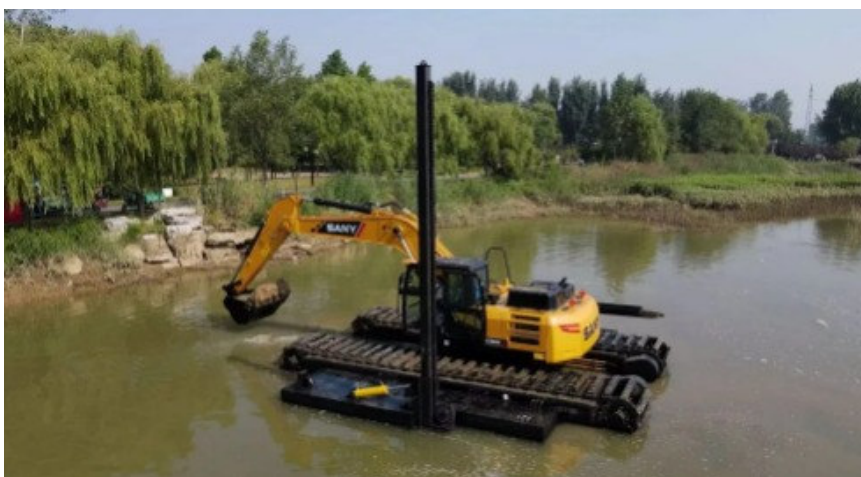
Рис. 1.2. Очищення русла річки глибоководним екскаватором-амфібією Sany Relong RL-AE30, [7]
