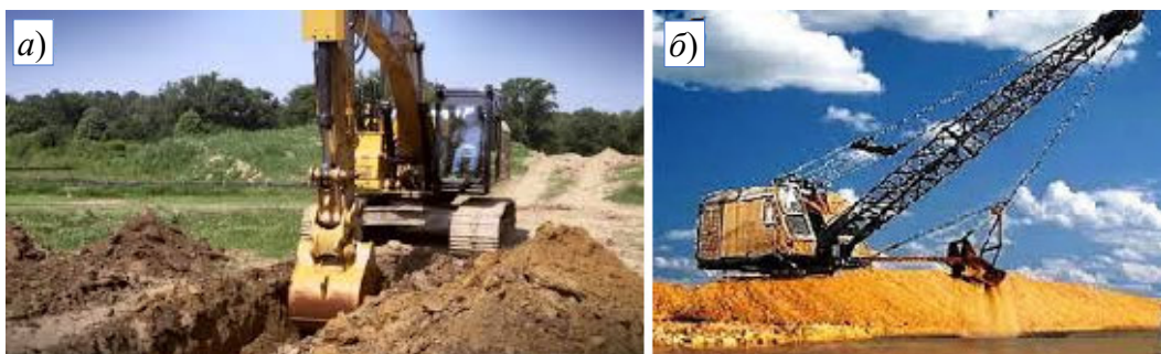
Рис. 2.11. Розроблення траншеї екскаватором з робочим обладнанням: а – зворотна лопата. Джерело: www.youtube.com/ ; б – драглайн, джерело : www.bau.ua/
