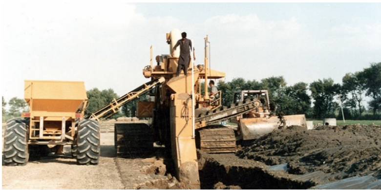
Рис. 4.12. Риття траншеї, вкладання дренажу та формування зворотного фільтру екскаватором-дреноукладачем Mastenbroek 40/36, [24]
