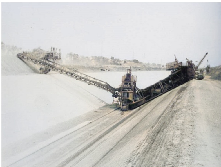
Рис. 3.23. Напівпрофільний екскаватор-планувальник, [1]
