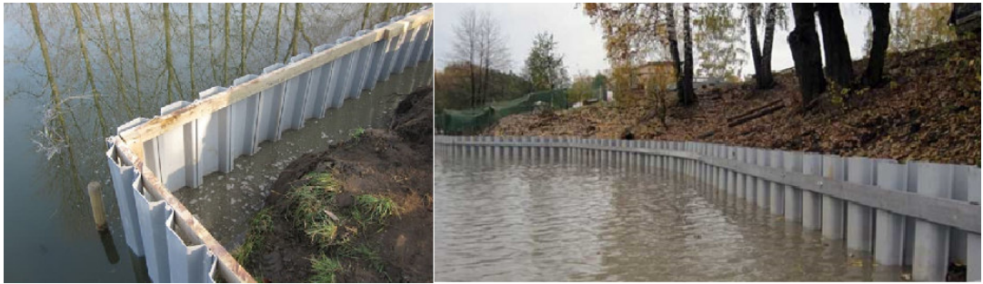
Рис. 6.41. Хвилезахисна стінка з ПВХ-шпунтів ( https://kiev-bereg.com/ua/nashi-roboti/ )
