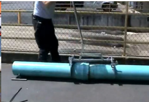
Рис. 3.106. З'єднання розтрубних пластмасових труб за допомогою натяжного пристрою, [1], [3]
