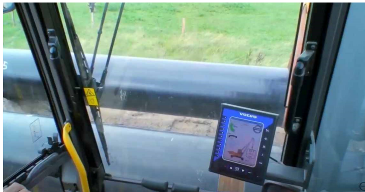
Рис. 3.122. Інформаційна система в кабіні оператора крана-трубоукладача, https://youtu.be/5x9NIOoffFE
