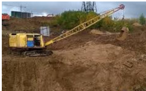
Рис. 3.67. Розробка траншей екскаватором «драглайн», [1]
