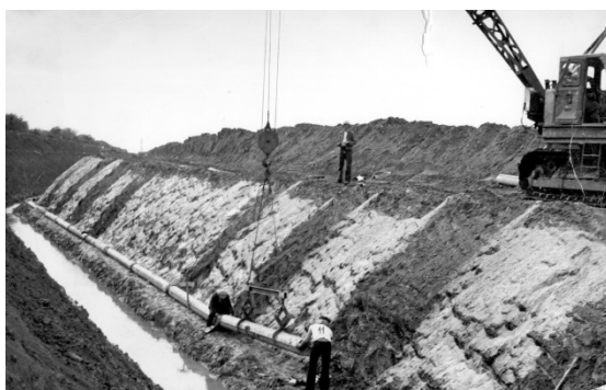
Рис. 4.8. Укладання дренажного колектору з бетонних фальцевих труб на полицку, [3]
