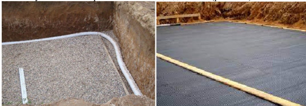
Рис. 7.27. Влаштування пластового дренажу ( https://z500.com.ua/ua/drenazh.html )
