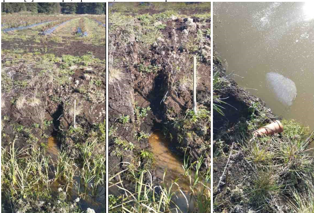
Рис. 1.21. Руйнування укосів каналу при відсутності кріплення та необлаштуванні дренажних гирл, фото автора, Радехів, Шептицький район Львівської області
