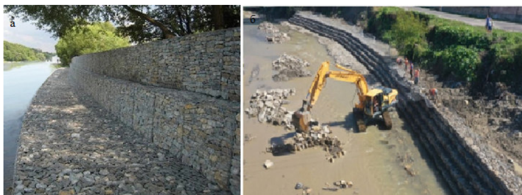
Рис. 6.25. Кріплення берега габійною стінкою ( https://kiev-bereg.com/ua/ukriplennya-berega-gabionami/ )
