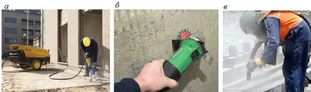
Рис. 5.32. Підготовка поверхні блоку бетонування до укладання бетонної суміші ( https://www.leavittmachinery.com/new-equipment/by-equipment-type/industrial-air-compressors ; https://novahata.kiev.ua/podgotovka-sten-pod-shpaklevku-svoimi-rukami/ ; https://top20.ua/ru/cv/tag/peskostruynaya-obrabotka/ )
