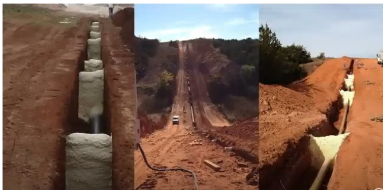
Рис. 3.124, Д. Фіксація та захист трубопроводу й траншеї спіненим поліуретаном: Foundation Supportworks – Foundation Repair, Trenchbreakers and Rock Shield with PolyLevel®, (2014). Дата звернення: 09, Січень 2025. [Online Video]. Доступний у:
