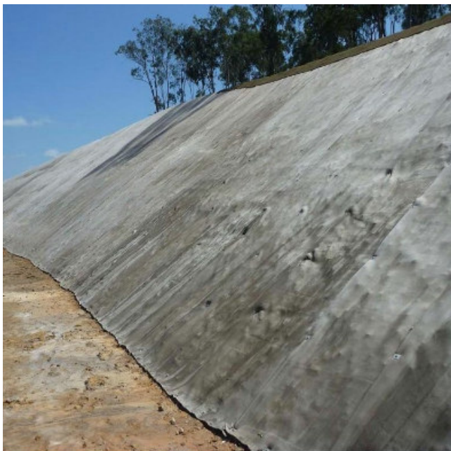
Рис. 6.52. Загальний вигляд кріплення укосу бетонним полотном ( https://www.ymt.com/supply/65002289 )
