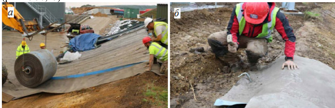
Рис. 6.50. Укладання бетонного полотна на укіс (а) та закріплення в анкерній траншеї (б) ( https://www.concretcanvas.com/uploads/CC-CCH-Compilation-Bund-Lining.pdf )
