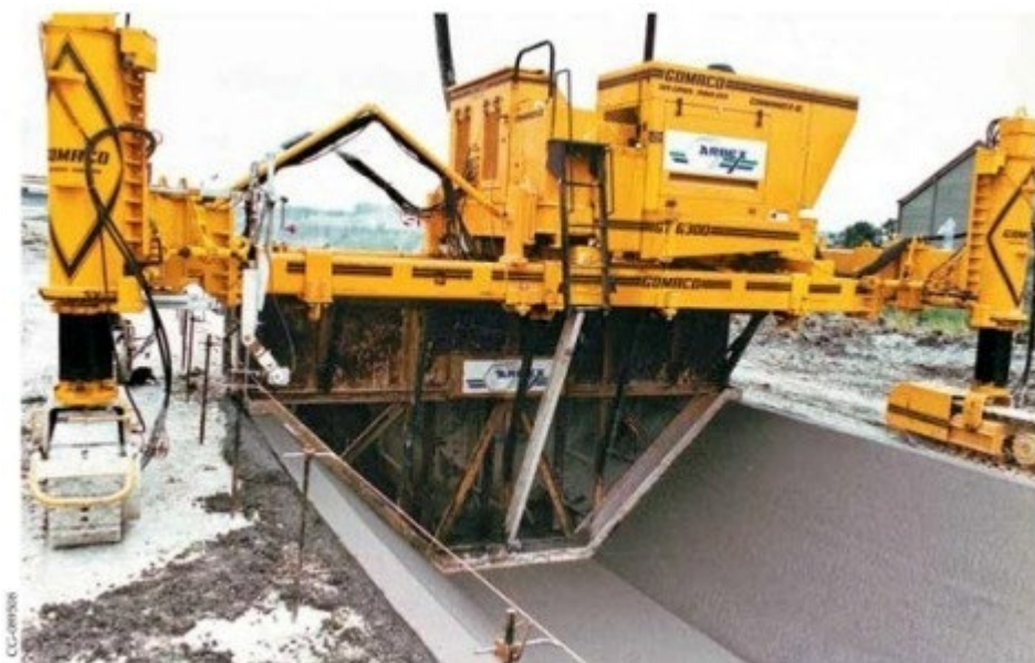
Рис. 3.25. Повнопрофільний бетоноукладач Gomaco, www.gomaco.com/
