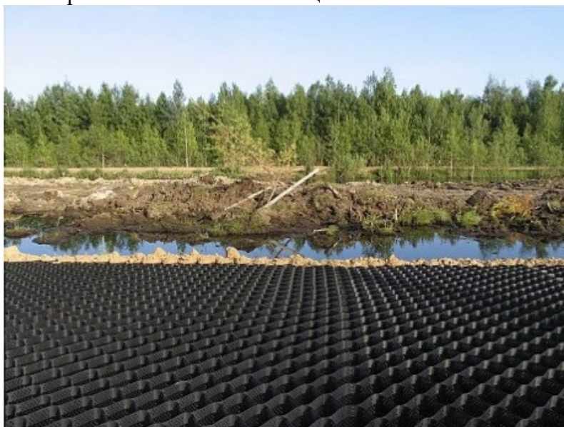
Рис. 1.25. Кріплення каналу георешіткою ArmAll® GeoCell, [20]
