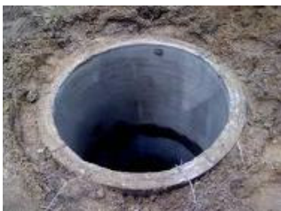
Рис. 1.34. Колодязь з залізобетонних кілець, [1]
