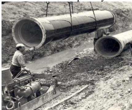
Рис. 3.86. «Монтаж залізобетонної труби, з нанесенням на неї гідроізоляції в два шари бітуму», [1]
