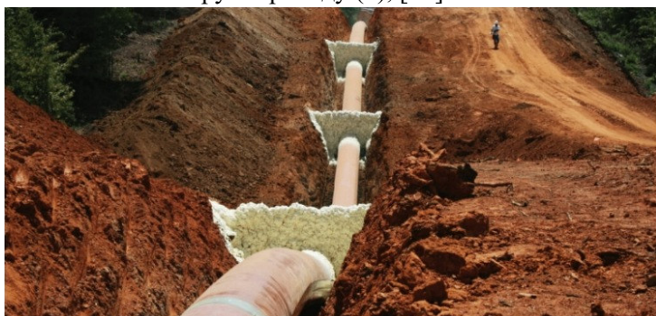
Рис. 3. 124, В. Підкладання мішків з піском в основі (а), [57] та фіксація мішками з піском навколо трубопроводу (б), [58]
