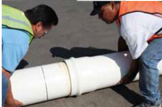
Рис. 3.106. З'єднання розтрубних пластмасових труб за допомогою натяжного пристрою, [1], [3]
