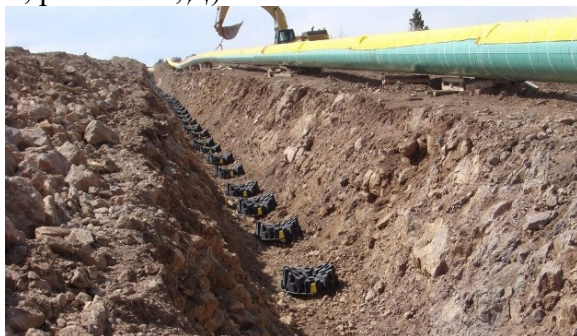
Рис. 3. 124, Б. Встановлення трубопроводу в траншеї на опори, [57]
