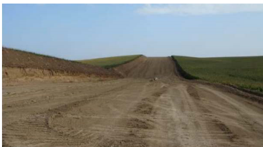
Рис. 3.62, А. Траса трубопроводу зі знятим рослинним ґрунтом, Osmun Armory, keystone pipeline project, (2010). Дата звернення: 09, Січень 2025. [Online Video]. Доступний у: https://www.youtube.com/watch?v=LXZfepzCbB4
