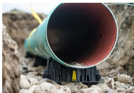
Рис. 3. 124, Б. Встановлення трубопроводу в траншеї на опори, [57]
