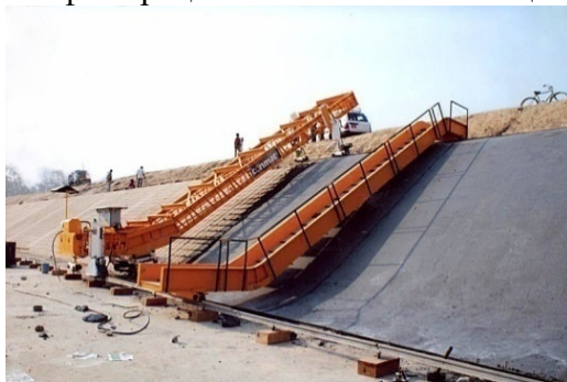
Рис. 3.45. Улаштування монолітного бетоноплівкового покриття, [1]
