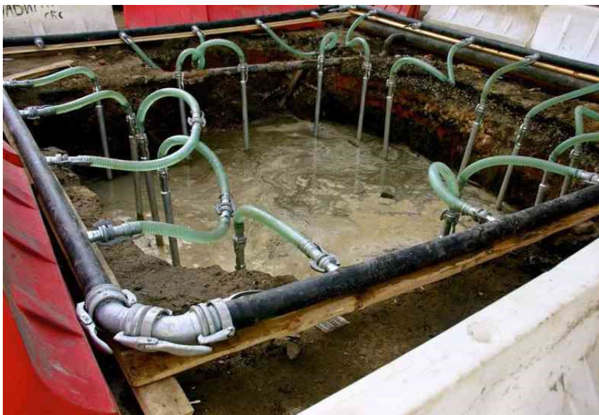
Рис. 5.11. Штучне зниження рівня ґрунтових вод ( https://msk.in.ua/vodoponizhenie )
