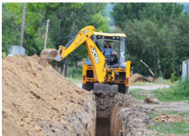
Рис. 7.32. Розробка траншеї однокішшевим екскаватором ( https://flagma.ua/products/zemlyanye-raboty/kirovograd/ )
