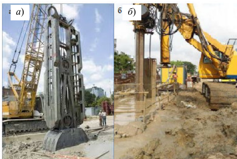
Рис. 7.41. Розробка ґрунту в траншеї гідроґрейфером: а – екскаватор-гідроґрейфер ( https://osnova-group.com.ua/uk/rishennya/tehnologii/stina-u-gru-nti ); б – розробка траншеї ( https://poradu.pp.ua/dim/45625-tehnologiya-virobnictva-robt-metodom-stna-v-grunt.html )
