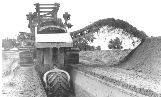
Рис. 3.64. Розробка траншей з вертикальними стінками роторним екскаватором, [1]
