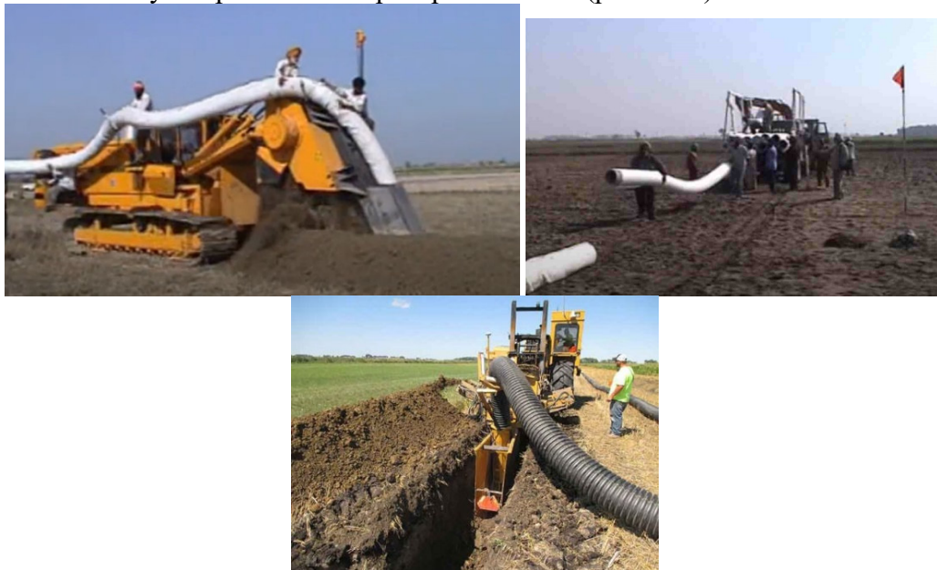
Рис. 4.11. Укладання колекторів екскаватором-дреноукладачем Inter-Drain 3035T, [66]
