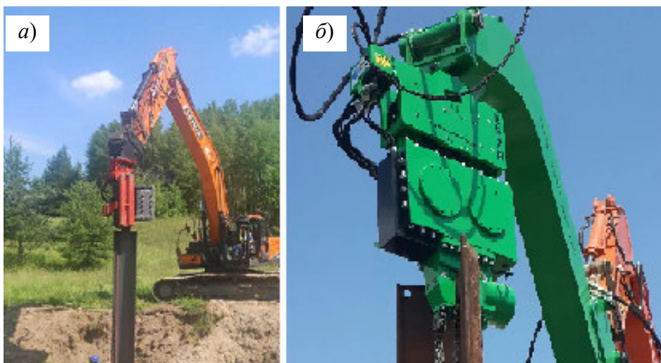
Рис. 6.39. Занурення шпунтини: а – установка для віброзанурення ( https://www.facebook.com/hydrobudkielczyk/ ); б – віброзанурювач ( https://hydrolider.com.ua/ua/p2087604453-mini-vibromolot-ostimex.html )
