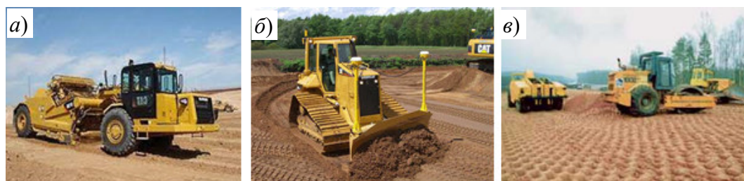
Рис. 2.20. Машини для влаштування якісного насипу греблі або дамби: а – скрепер для розробки, транспортування і укладання ґрунту ( https://www.cat.com/ ); б – бульдозер для розрівнювання ґрунту ( https://www.cat.com/ ); в – коток для ущільнення ґрунту ( https://smk-monolit.prom.ua/ua/ )
