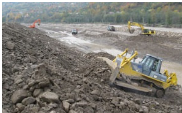
Рис. 6.5. Влаштування підготовки з гравію бульдозером ( http://kova.net.ua/UA/nashi-posluhy-2/5-beregoukriplyuvalni-roboti.html#5257-DSC_1452 )
