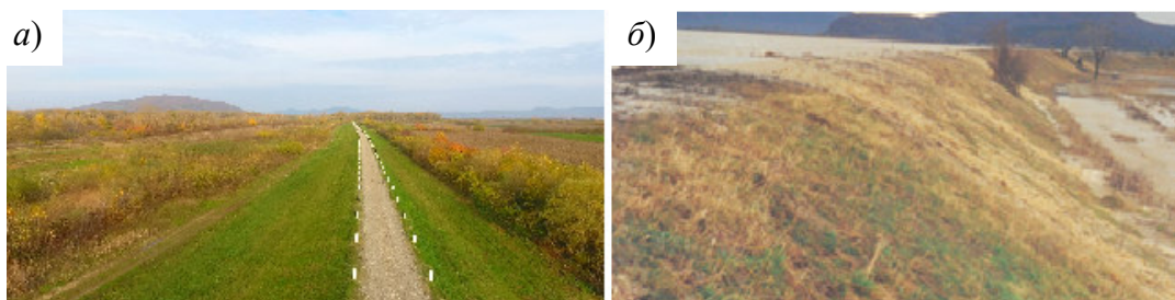
Рис. 7.5. Дамби обвалування: а – незатоплювана; б – затоплювана ( https://buvrtya.gov.ua/newsite/?p=24467 )
