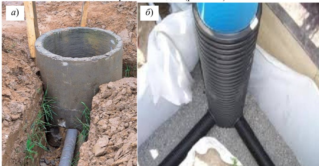
Рис. 7.33. Колодязі на дренажній мережі ( https://remontu.com.ua/drenazhnij-kolodyaz-svo-mi-rukami#google_vignette )
