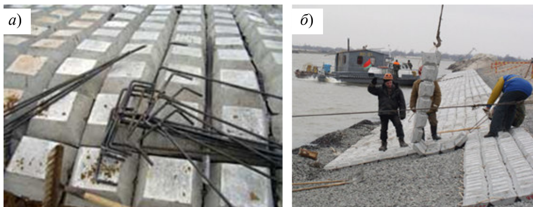
Рис. 6.17. Монтаж полотен із УГЗБМ: а – мати і Т-подібні скоби; б – монтаж матів
