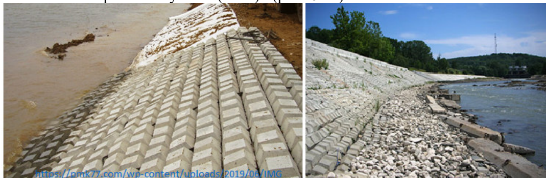
Рис. 6.13. Кріплення укосу універсальними гнучкими захисними бетонними матами (УГЗБМ) ( https://pmk77.com/poslugy/gidrosporudy/ )
