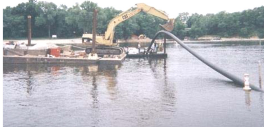
Рис. 3.131, Б. Опускання трубопроводу через водну перешкоду, From Nuova Ghizzoni S.p.A. ( www.ghizzonispa.com ), https://www.northfieldma.gov/sites/g/files/vyhli991/f/uploads/intro_to_gas_pipeline_presentation_of_5-26-15_part_2.pdf
