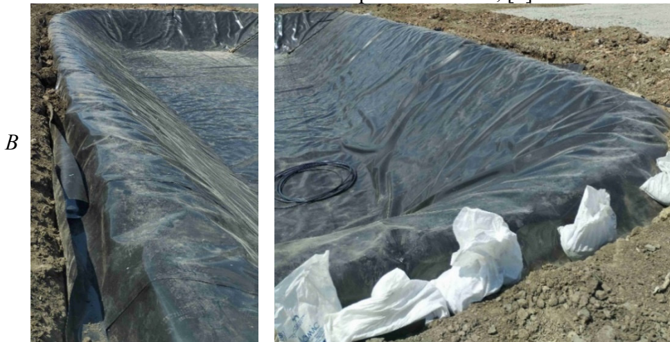
Рис. 3.51, В. Облаштування геомембрани Agru Kunststofftechnik GmbH, 1.5 мм (відповідає ДСТУ Б В.2.7-101-2000) методом гарячого клину за допомогою обладнання Liester, фото автора, https://nuwm.edu.ua/nni-vgp/news/oznaiomlennia-z-tekhnohiiieiu-formuvannia-protyfiltratsiinoho-pokryttia-vodoim
