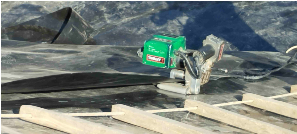
Рис. 3.51, А. Пристрій для електрозварювання плівок (геомембрана Agru Kunststofftechnik GmbH, 1.5 мм), зварювання мембрани проводилося методом гарячого клину за допомогою обладнання Liester, фото автора, https://nuwm.edu.ua/nni-vgp/news/oznaiomlennia-z-tekhnologiiu-budivnytstva-stavka-nakopychuvacha
