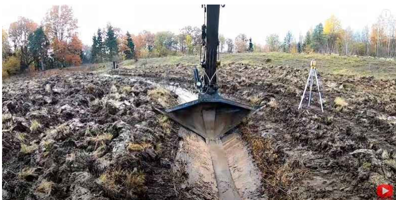
Рис. 1.12. Розробка каналів осушувальної мережі одноківшевим екскаватором Volvo EC220E з профільним ковшем. Відео з youtu.be/P9RR-N-uN3o
