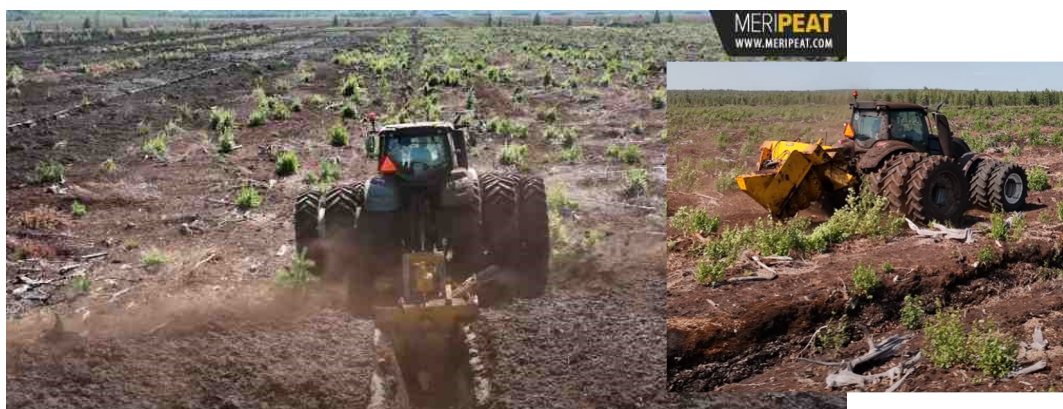
Рис. 1.17. Формування осушувальних каналів MeriPeat ditcher OJK-1.3 на базі колісного трактора, по 6 коліс на вісі. Джерело фото: youtu.be/9vs5ROsuLZE
