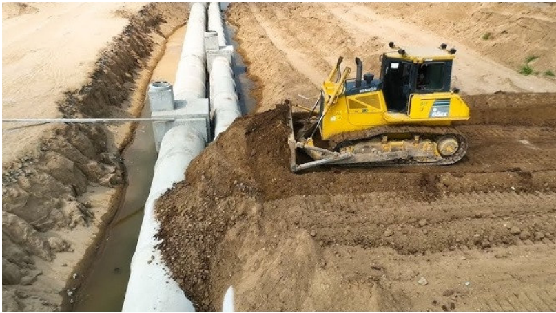
Рис. 3.127. Остаточне засипання траншеї бульдозером, Daily Bulldozer, Processing Bury Drains With 2 Bulldozers Pushing Sand, (2024). Дата звернення: 09, Січень 2025. [Online Video]. Доступний у: https://www.youtube.com/watch?v=ssxBW0E8HsU
