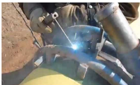
Рис. 3.116. Фіксування торців труб ручним зварюванням через зазори центратора, https://youtu.be/cUNzEDOVg9s
