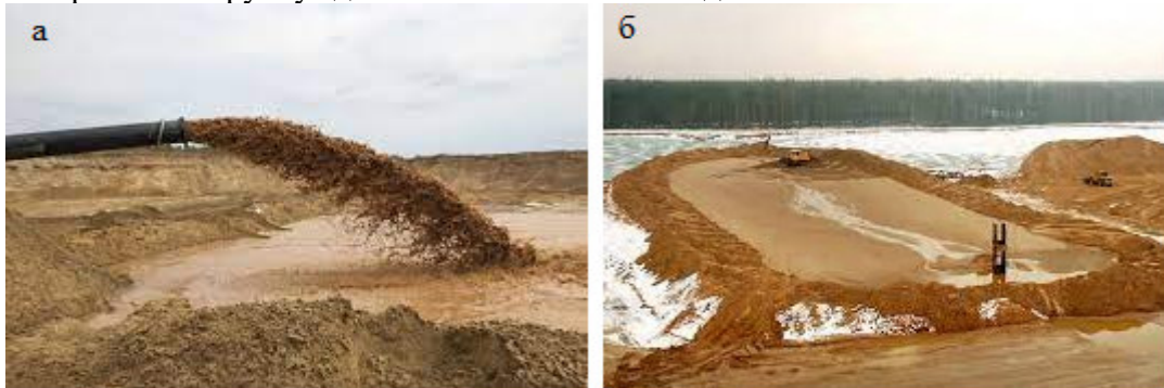
Рис. 7.3. Карта наміву: а – випуск пульпи; б – загальний вид карти наміву ( https://www.youtube.com/watch?v=w0DEPryDgas ; https://youtu.be/p62jMAM4Puk )
