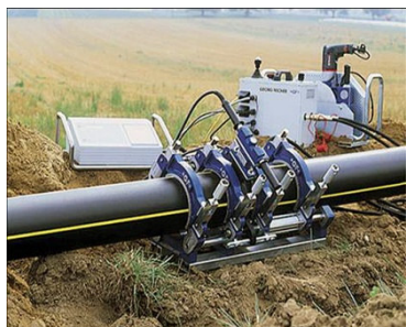
Рис. 3.99. Пристрій для зварювання пластмасових труб, [1]
