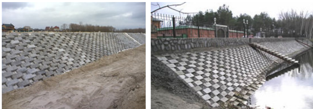
Рис. 6.14. Захист берега блоками кріплення укосів (БКУ) ( https://abeton.ua/produkty/blok-kriplennya-ukosiv-bku/ )
