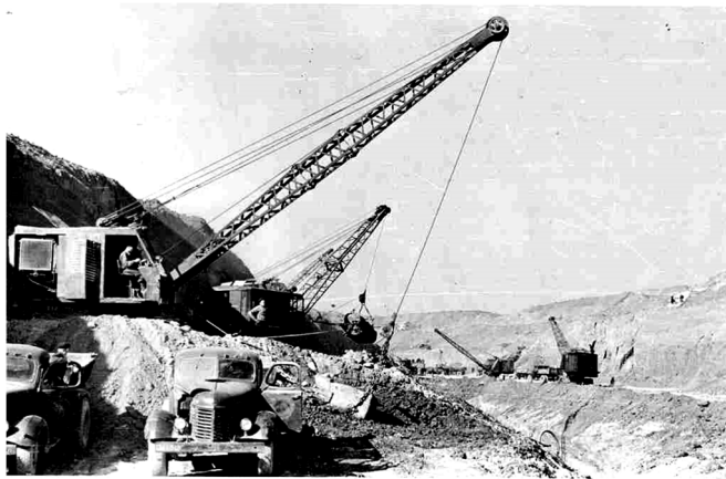
Рис. 3.6. Розробка каналу Дніпро – Донбас, ділянка у глибокій виїмці (фото 1962 року), [1]
