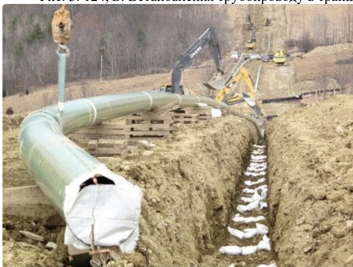
Рис. 3. 124, В. Підкладання мішків з піском в основі (а), [57] та фіксація мішками з піском навколо трубопроводу (б), [58]
