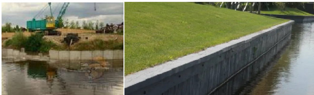
Рис. 6.8. Укріплення берега бетонним шпунтом ( https://kiev-bereg.com/ua/ukriplennya-berega/ )
