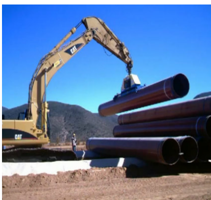
Рис. 3.108. Розвантаження труб вакуумним захватом
