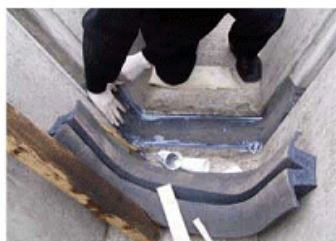
Рис. 3.44. Гідроактивні компенсатори при герметизації швів каналу, [1]
