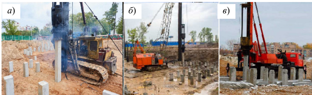
Рис. 6.36. Самохідні палейні установки: а – на тракторі; б – на крані; в – на автомобілі ( https://saucyintruder.org/zabivka-svaj-tehnologia-pogruzenia-zelezobetonnyh-svaj/ )
