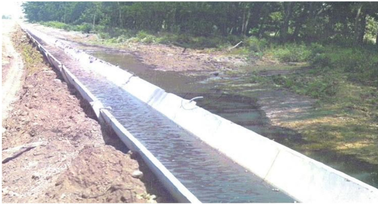
Рис. 3.60. Гідравлічні випробування лоткового каналу на опорних плитах, [[1], кольоризоване ШІ
