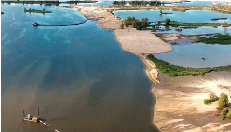
Рис. 7.2. Підвищенням відміток поверхні землі шляхом наміву ( https://dredger.com.ua/uk/uslugi-zemsnaryada/namyv-plyazhej-i-nabereznyh/ )
