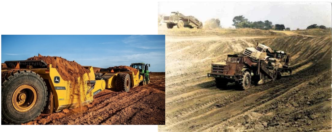
Рис. 3.10. Розробка ґрунту у виїмці каналу з відсипанням його у майбутні дамби, джерело фото: surl.li/xqqsh ; [1], оброблене автором
