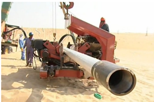
Рис. 3.79. Тонкостінна сталева труба з привареною обичайкою, [1]
