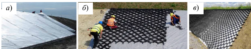
Рис. 6.45. Берегоукріплення георешіткою: а – укладання геотекстилю на укіс; б – укладання георешітки; в – георешітка на укосі ( https://prom.ua/p1188236130-geotekstil-lavsangeo-100.html ; https://prom.ua/ua/p1303181254-georeshetka-obemnaya.html ; https://prom.ua/Ukreplenie-sklonov.html )
