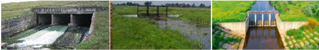
Рис. 5.1. Мережеві збірні гідротехнічні споруди ( https://uk.wikipedia.org/wiki/https://depositphotos.com/se/photo/sewer-city-dirty-waters-in-the-canal-merge-waterfall-155172994.html )
