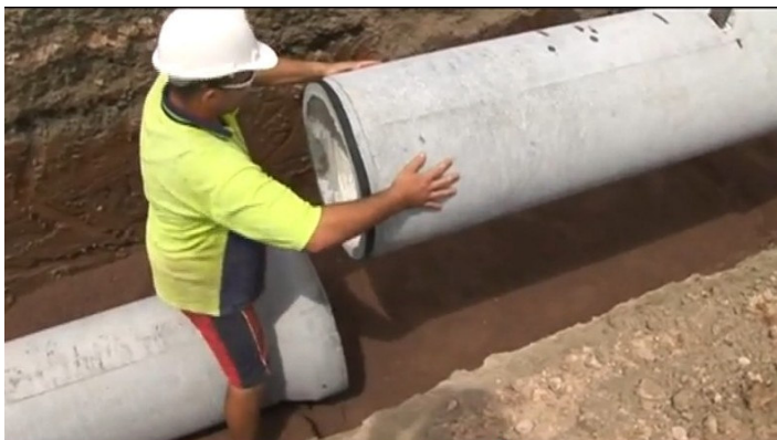
Рис. 3.94. Заведення гладкого кінця в розтруб CРААconcpipe, CРАА Installation of Concrete Pipe, (2013). Дата звернення: 08, Січень 2025. [Online Video]. Доступний у: https://www.youtube.com/watch?v=31tOCs2PTwc
