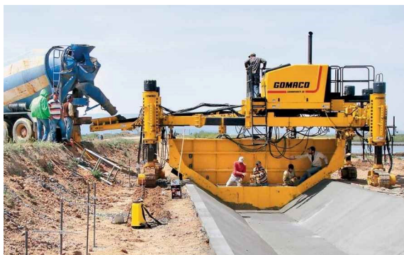
Рис. 3.26. Повнопрофільний бетоноукладач Gomaco, www.gomaco.com/
