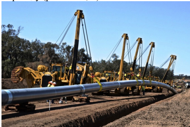
Рис. 3.124, А. Укладання сталевих трубопроводів методом безперервної нитки
