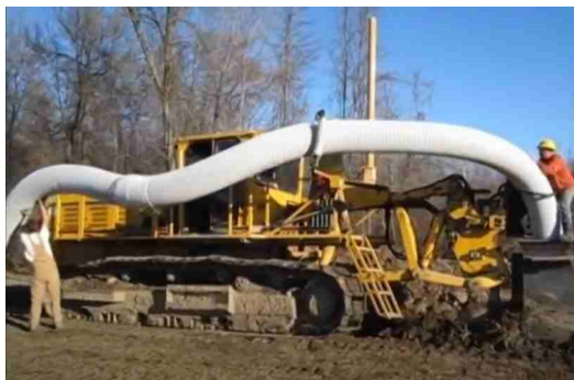
Рис. 4.15. Укладання колектора безтраншейним дрепоукладачем BRON 450, [67], [68]
