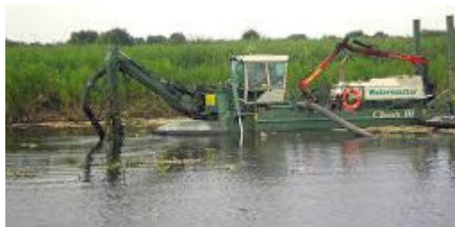
Рис. 3.130. Розробка траншеї на дні річки ґрунтовсмоктуючою установкою (земснарядом), [1]
