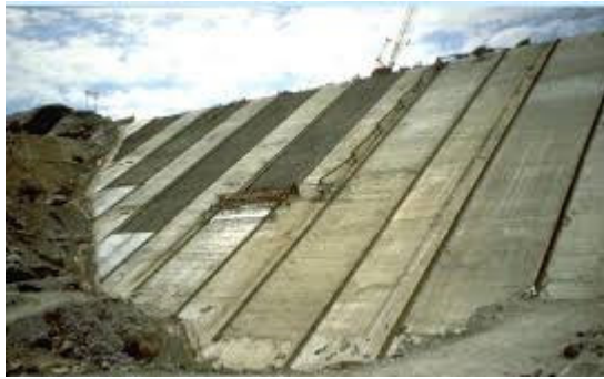
Рис. 2.27. Бетонне кріплення укосу ґрунтової греблі ( https://www.slideshare.net/slideshow/chap-6-b-barrages-en-remblais/33443594 )
