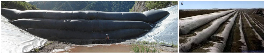
Рис. 7.16. Застосування геотуб в гідротехнічному будівництві: а – гребля ( https://erosionpollution.com/filtration/dewatering/ ); б – захисна протипаводкова дамба ( http://www.tongbaixijin.com/city/suzhou )
