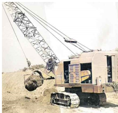
Рис. 3.4. Розробка ділянки каналу у виїмці екскаватором з РО драглайн, [1]
