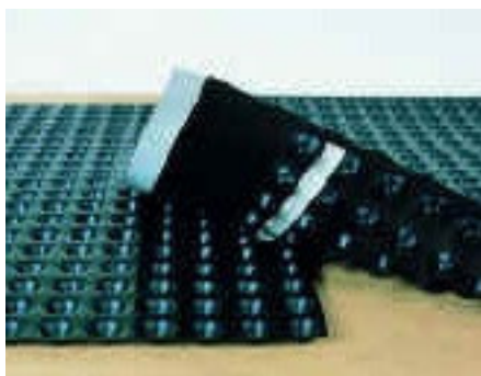
Рис. 7.37. Укладання геомембрани з перекриттям полотен ( https://stroydar.com.ua/ua/a166652-instruktsiya-montazhu-izolit.html )
