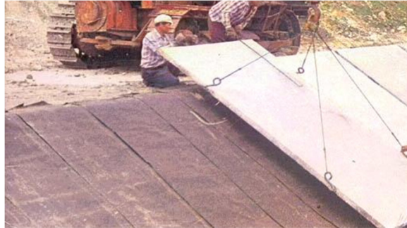
Рис. 3.52. Плівка покрита захисним екраном з пергаміну, [1] кольоризоване ШІ
