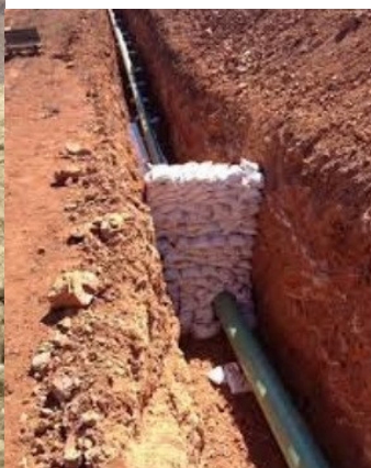
Рис. 3. 124, В. Підкладання мішків з піском в основі (а), [57] та фіксація мішками з піском навколо трубопроводу (б), [58]
