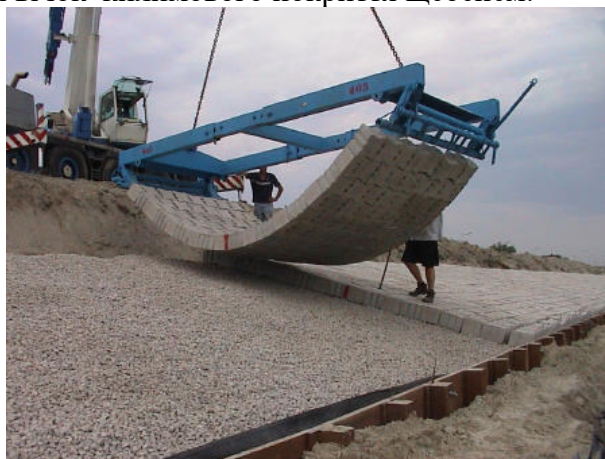
Рис. 6.19. Укладання килима із блоків БКУ
