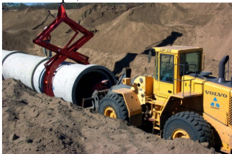
Рис. 3.95. Монтаж залізобетонних труб з допомогою захвата Kenco PL8500 Pipe Lift і штовхача, https://kenco.com/products/pipe-lift/photos-videos/
