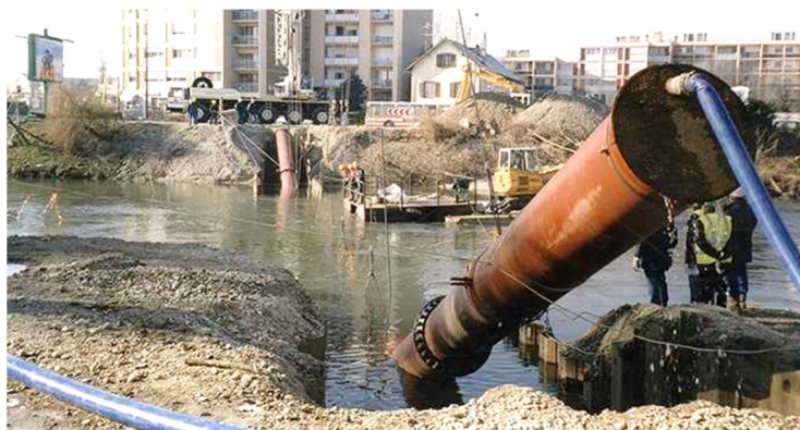
Рис. 3.131, В. Прокладання трубопроводу із заглушеним торцем, фото з сайту: Saint-Gobain PAM International, https://www.pamline.com Дата звернення: 10, Січень 2025
