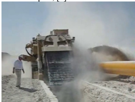
Рис. 3.65. Розробка траншей стрічковим екскаватором безперервної дії, [1]
