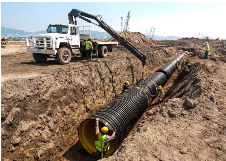
Рис. 4.6. Укладання труб з поліетилену високої щільності. Фото з сайту: https://en.wikipedia.org/wiki/Drainage
