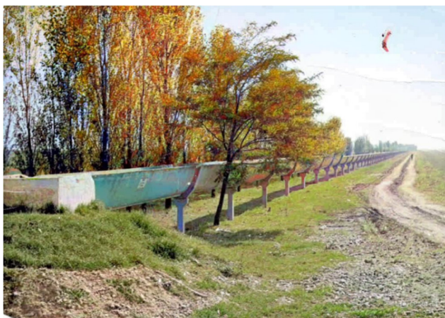
Рис. 3.58. Лотковий канал на опорних стійках, [1], кольоризоване ШІ
