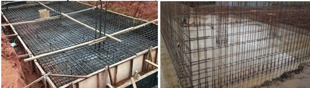
Рис. 5.26. Армування днища плити та стінок шахти водоскиду ( https://teknosel.com.ua/ua/news/materialy-dlya-opalubki/opalubka-dlya-fundamenta-sovety-i-rekomendatsii/ ; https://www.instagram.com/centring_lover/reel/C8eJWLnytKx/ )
