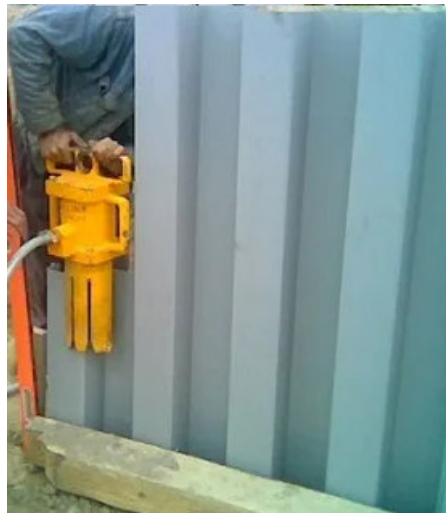
Рис. 6.42. Гідравлічний молоток для занурення ПВХ-шпунта ( https://yak.koshachek.com/articles/shpuntovi-pali-tehnichni-harakteristiki-vidi.html )
