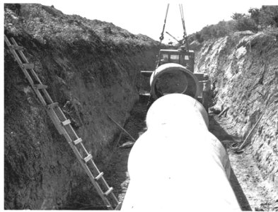
Рис. 3.96. Стикування залізобетонних труб з допомогою бульдозера, [1]
