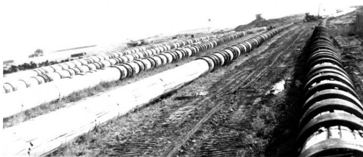
Рис. 3.132. Підготовлені для протягування секції трубопроводу, [1]
