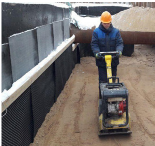
Рис. 5.22. Ущільнення ґрунту в пазах котлованів віброплитою ( https://dimkomfort.kyiv.ua/ )
