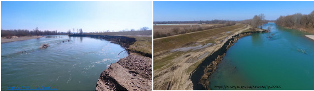
Рис. 6.2. Розмив берега річки ( https://life.ko.net.ua/?p=111551 )
