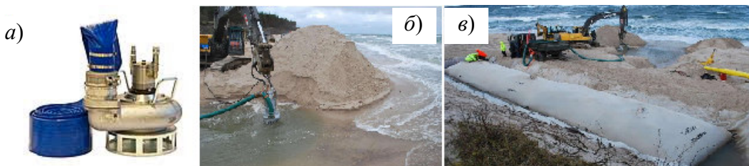
Рис. 7.18. Пульповий насос: а – загальний вигляд ( https://www.goglasia.com/search?q=+potapajuca+pumpa..&start=175 ); б – пульповий насос, підвішений до стріли екскаватора; в – наповнення геотуба пульпою ( https://tecamyser.com/en/applications/dredging-and-drainage/ )
