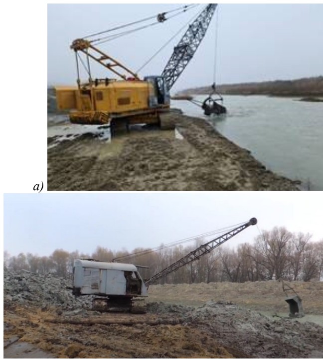
Рис. 1.9. Розробка русла каналу екскаватором драглайн: а – DEMAG, фото з сайту https://www.truck1.eu/construction-machinery/draglines/demag ; б – EO-4111, відео з youtu.be/fOqTcjDKfq0
