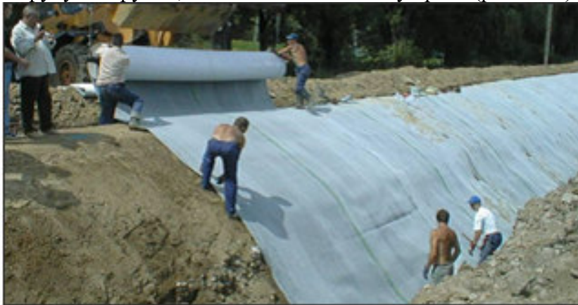
Рис. 6.47. Кріплення схилу геоклимами з бентонітової глини ( https://psm.co.ua/produkcija/bentonitovi-mati-bentomat-actimat-resistex/ )
