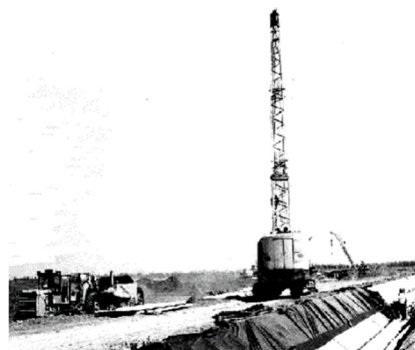
Рис. 3.33. Монтаж облицювання з залізобетонних плит гусеничним стріловим краном, [1]
