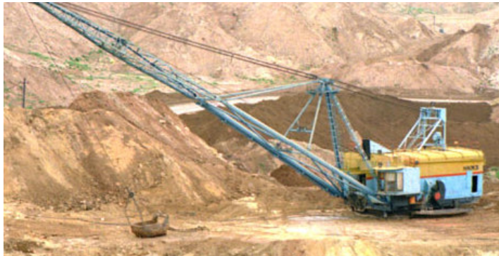
Рис. 3.7. Розробка ділянки каналу у глибокій виїмці крокуючим екскаватором, [1]
