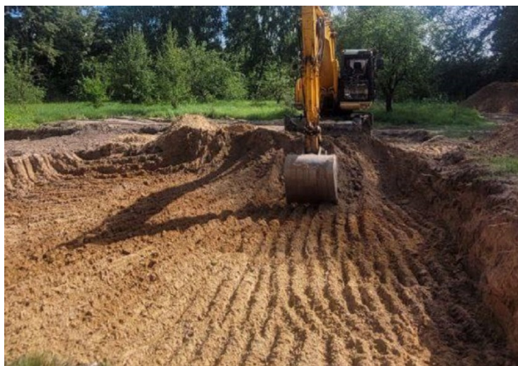
Рис. 5.7. Розробка котловану екскаватором із зворотною лопатою ( https://mykyivregion.com.ua/news/ )
