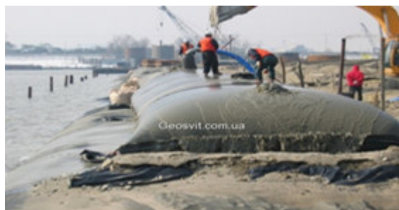
Рис. 7.20. Заповнення геотуба піщаним ґрунтом ( https://geosvit.com.ua/gidrotehniczne-budivnytvo/zastosuvannya-geotub-geosvit-tube-u-gidrotehnicnomu-budivnytvi/ )
