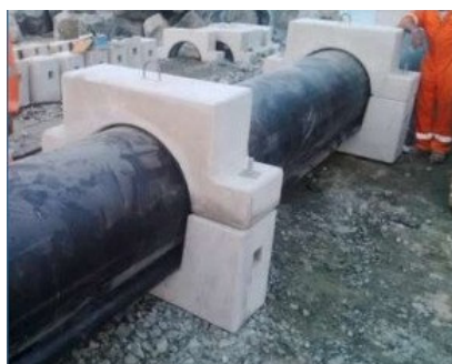
Рис. 3.134, Б. Прямокутні та круглі анкерні блоки (Anchor Blocks), фото з сайту https://www.indomer.com/ , дата доступу 10.01.2025 р.
