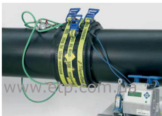
Рис. 3.102. Зварювання труб електрозварною муфтою, [1]
