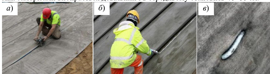
Рис. 6.51. Способи скріплення смуг бетонних полотен: а – зварюванням; б – склеюванням; в – скобами ( https://www.concretcanvas.com/uploads/CC-CCH-Compilation-Bund-Lining.pdf )
