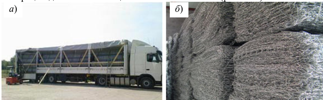
Рис. 6.23. Транспортування каркасів габіонних ящиків і матраців: а – автомобіль для транспортування габіонних сіток; б – пакети габіонних ящиків і матраців у складеному стані, ( https://lens.google.com/search )
