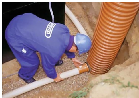
Рис. 1.35. Полімерний колодязь для промивання дрен, [1]
