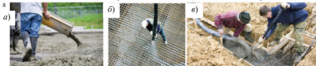
Рис. 5.33. Способи розподілу бетонної суміші на поверхні блоку бетонування: а – лотком ( https://stroy-texnika.com.ua/articles/210-zalivka-betona-poslojno ); б – хоботом ( https://rbt.com.ua/monolitnyie-raboty-v-kieve/ ); в – бетононасосом ( https://t1.ua/porady/44801-varianty-zalivky-fundamentu.html )
