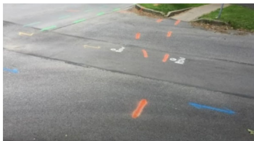
Рис. 3.62, Б. Маркування наявних підземних комунікацій, PA Asphalt Pavement Association, Pipe Installation, (2019). Дата звернення: 09, Січень 2025. [Online Video]. Доступний у: https://www.youtube.com/watch?v=aWG8tPHV5y0
