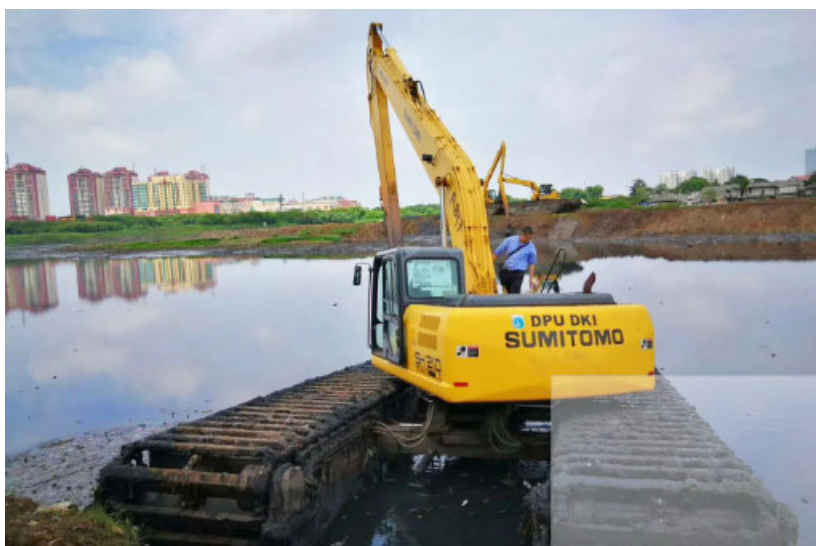
Рис. 1.3. Очищення водойми болотним екскаватором-амфібією на базі Sumitomo SH210, [7]
