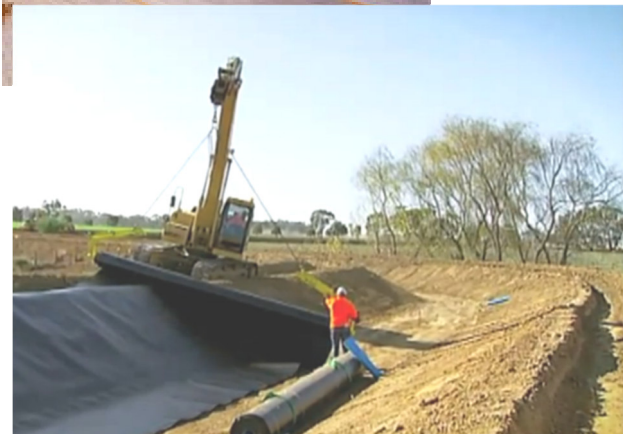
Рис. 3.53. Влаштування гідроізоляційного покриття з бентонітової геомембрани, [1]
