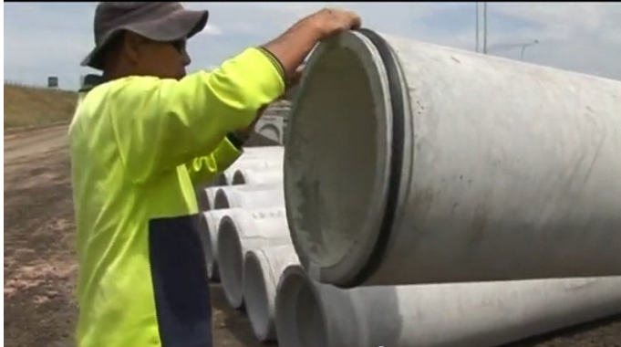
Рис. 3.93. Одягання гумового кільця на гладкий кінець залізобетонної труби, CРААconcpipe, CРАА Installation of Concrete Pipe, (2013). Дата звернення: 08, Січень 2025. [Online Video]. Доступний у: https://www.youtube.com/watch?v=31tOCs2PTwc
