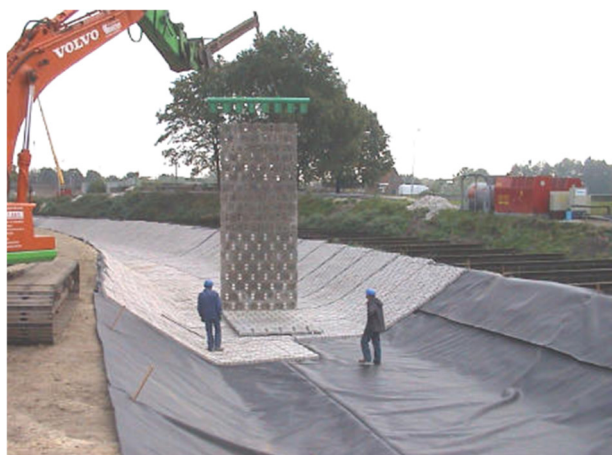
Рис. 3.55. Захист мембранного покриття універсальними гнучкими бетонними матами, [1]
