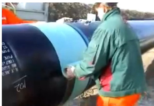
Рис. 3.85. Ізоляція стику після його зварювання, [1]
