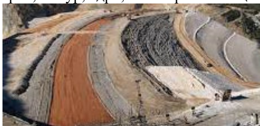
Рис. 2.24. Будівництво неоднорідної греблі
