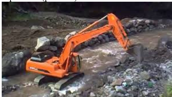
Рис. 6.4. Видобування каменя у руслі ріки ( https://www.youtube.com/watch?v=-DcWcGxweGw )
