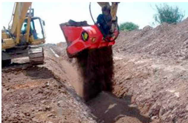
Рис. 3.126. Попереднє засипання траншеї, [1]
