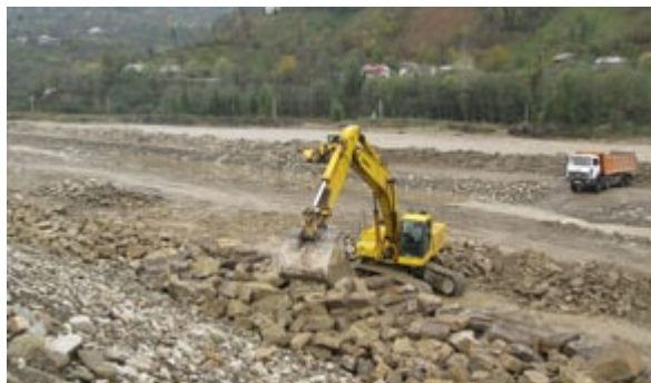
Рис. 6.6. Улаштування кам'яної відсипки екскаватором
