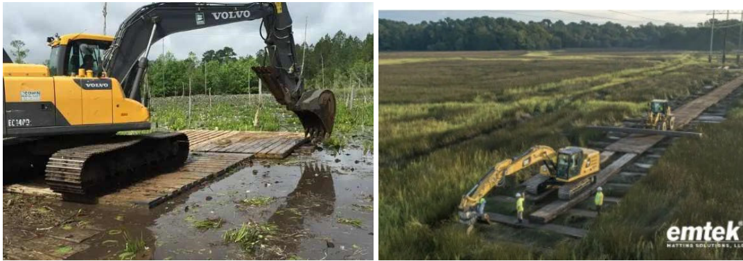
Рис. 1.8. Робота екскаваторів з використанням дерев'яних настилів від Dakota Matting, [14]
