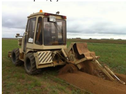
Рис. 3.66. Розробка траншей ланцюговим екскаватором, [1]
