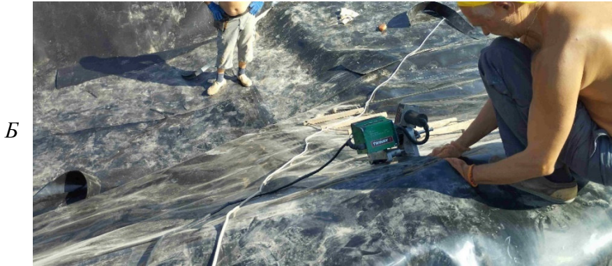
Рис. 3.51, Б. Зварювання геомембрани Agru Kunststofftechnik GmbH, 1.5 мм методом гарячого клину за допомогою обладнання Liester, фото автора, https://nuwm.edu.ua/nni-vgp/news/oznaiomlennia-z-tekhnohiiieiu-budivnytstva-stavka-nakopychuvacha
