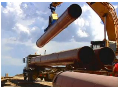
Рис. 3.107. Розвантаження сталевої труби доставленої на будівельний майданчик спеціальним трубовозом
