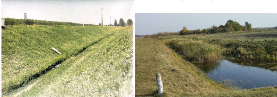
Рис. 1.20. Кріплення осушувального каналу хмизовим плотом і обдернуванням, фото: [1] та автора, Кричевичі, Ковельський район Волинській області
