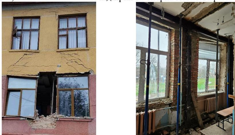
Рисунок. Зруйнований простінок першого поверху зовнішньої стіни будівлі
