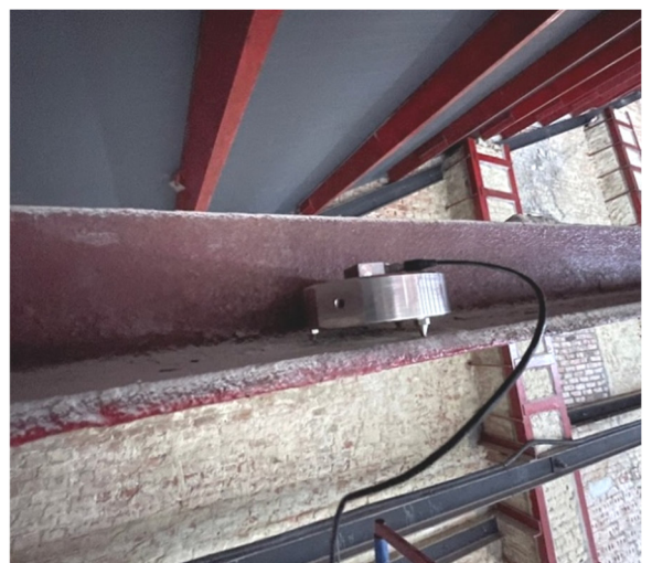
Рис. 4. Розміщення датчика на фермі покриття
