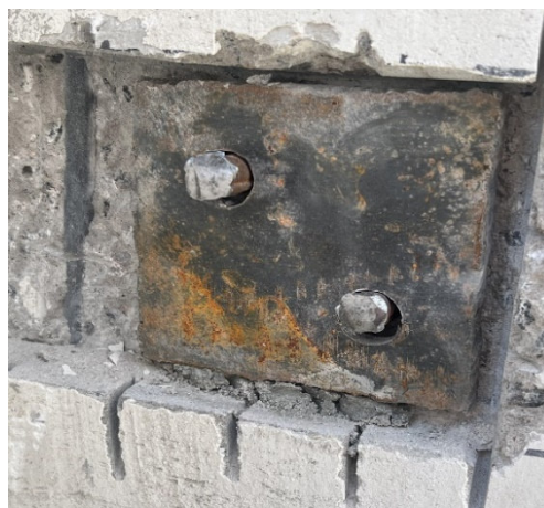
Рис. 3. Підготовлена до зварювання закладна деталь на хімічних анкерах
