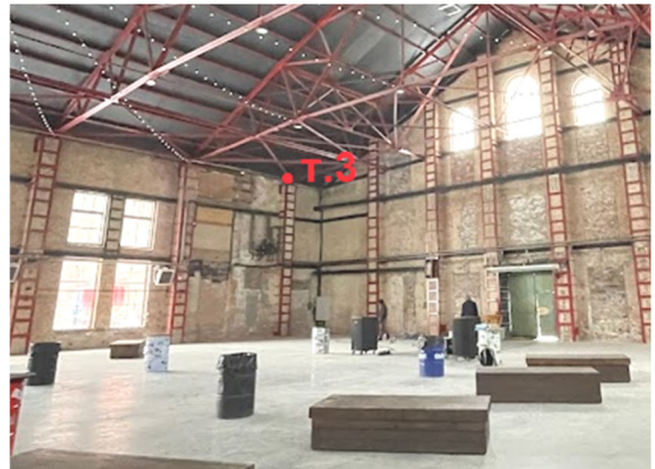
Рис. 2. Розміщення датчика на колоні у точці 3
