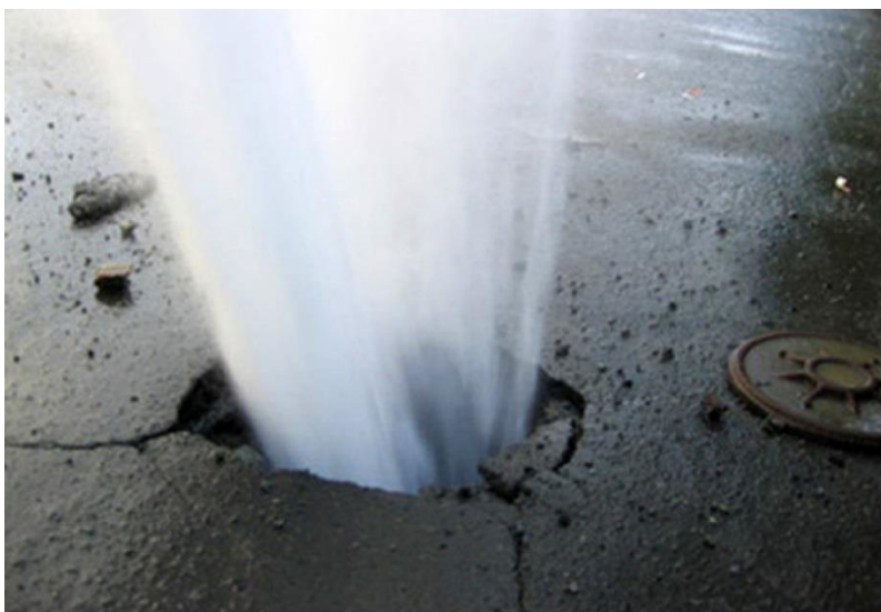
Рис. 26.Порив водопроводу у м. Рівному
