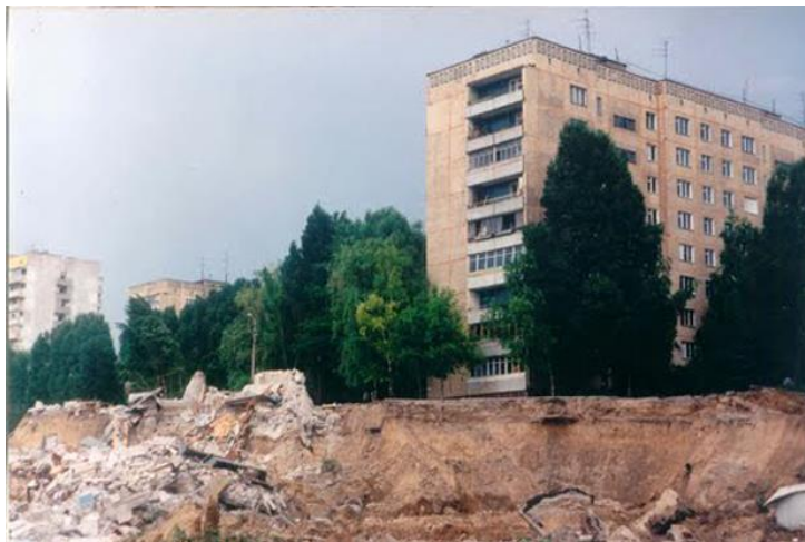
Рис. 15. Занедбаний 9-поверховий будинок
