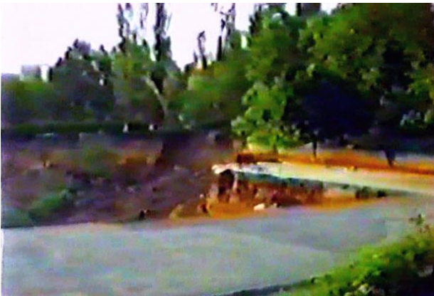
Рис. 13. Залишки будівлі школи
