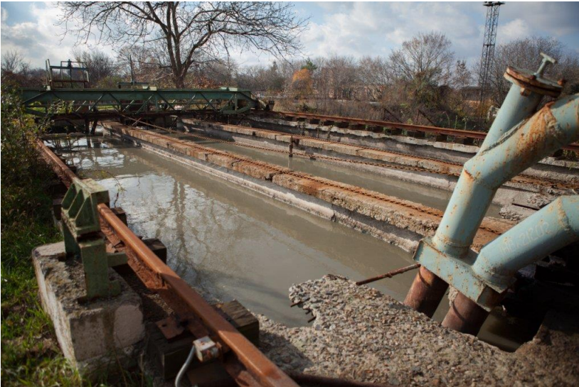
Рис. 33. Незадовільний технічний стан КОС
