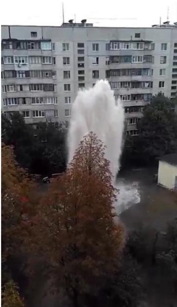
Рис. 27. Порив водоводу у м. Харкові
