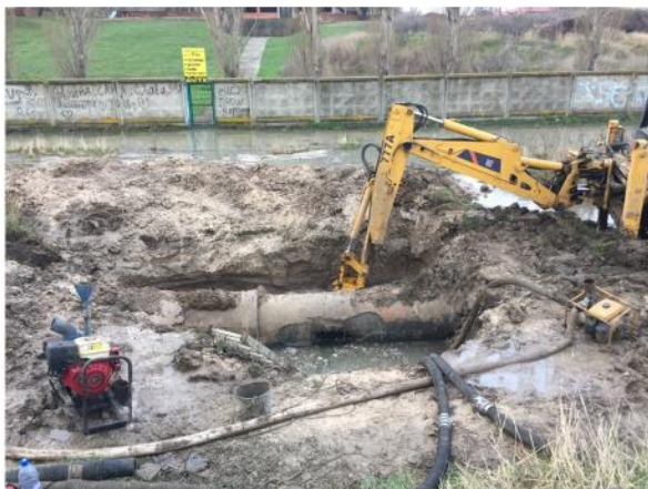
Рис. 32. Аварія на каналізаційному колекторі
