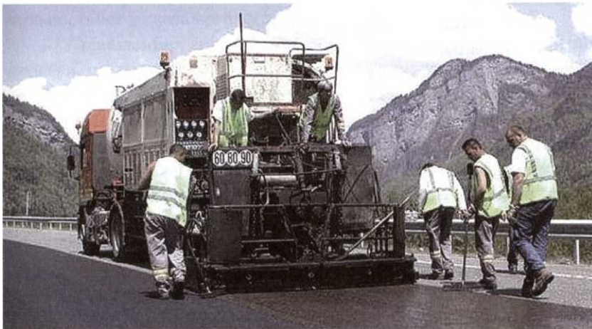
Рис. 6.3. Мобільна установка з розподільчим коробом фірми Akzo Nobel для отримання шару Slurry Seal
