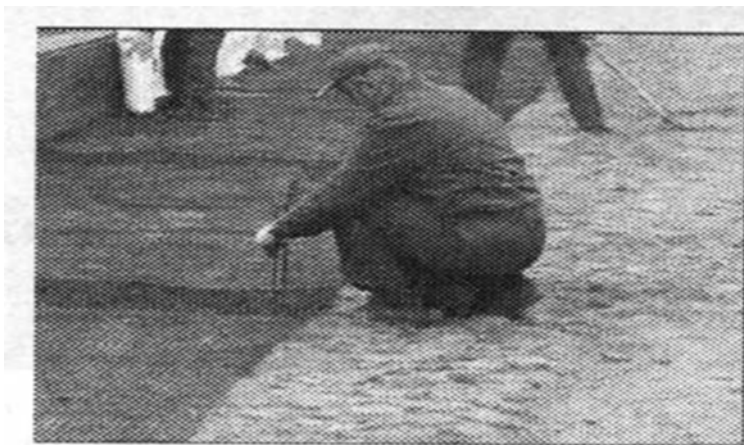
Рис. 4.12. Закріплення полотен металевими скобами
