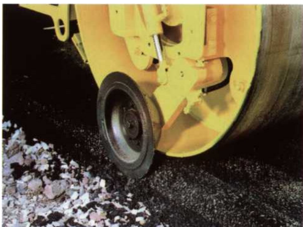
Рис. 5.26. Ущільнюючий ролик, що формує похилу і гладку поверхню кромки асфальтного покриття
