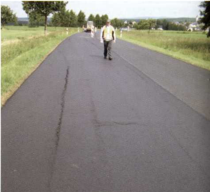
Рис. 5.41. Поперечні та повздовжні тріщини, які утворились в результаті використання занадто важкого катка
