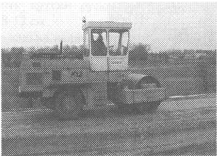
Рис. 4.13. Ущільнення захисного шару ґрунту геополотна
