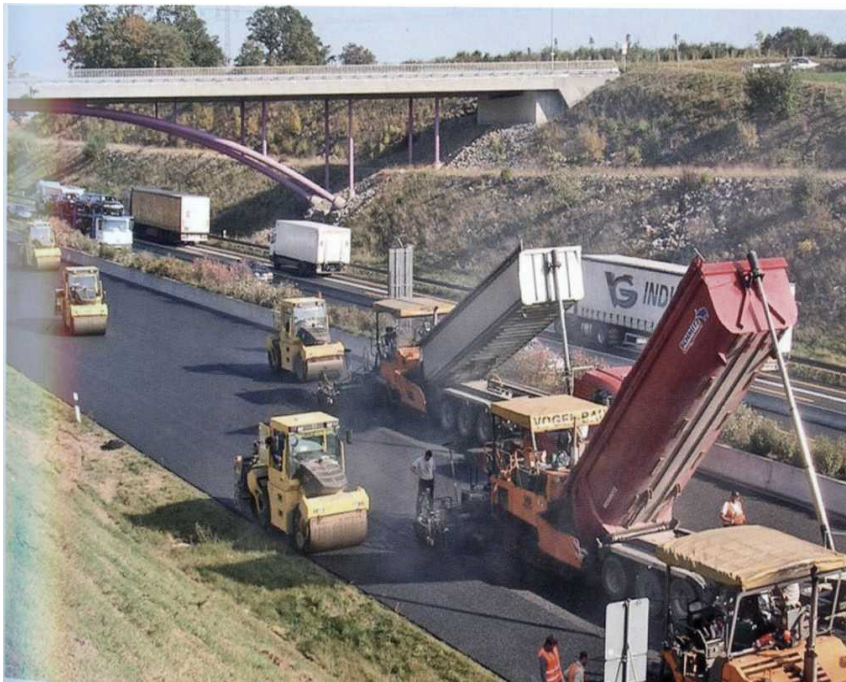
Рис. 5.28. Укладання і ущільнення асфальту за допомогою трьох асфальтоукладачів та п'яти віброкатків (масою 10 т). Ширина укладки >10 м; щоденний об'єм покладеного асфальту >3000 т
