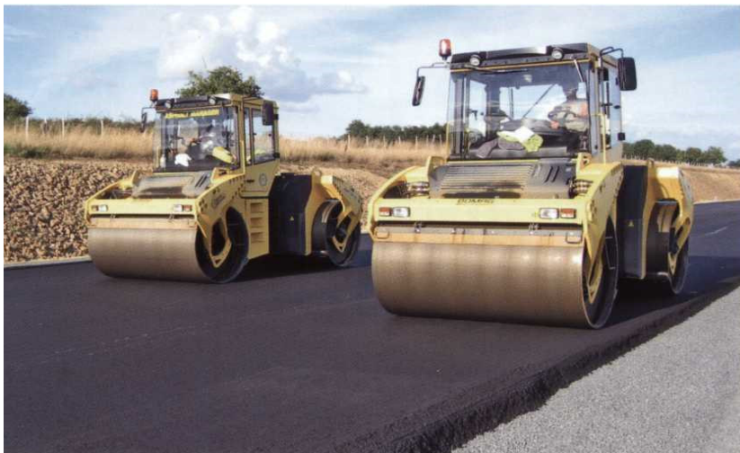
Рис. 5.29. Котки BW 203 AD продуктивністю 250 м/год. працює на несучому шарі асфальтного покриття товщиною 16 см
