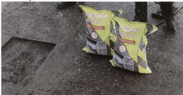
Рис. 3.13. Холодна пакетована асфальтобетонна суміш для ямкового ремонту
