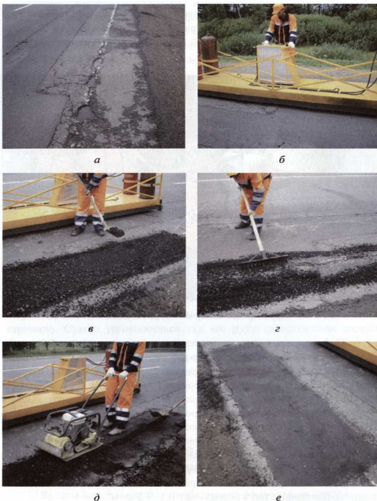
Рис. 3.8. Етапи ремонту покриття за технологією інфрачервоної регенерації: а) ділянка ушкодженого покриття; б) розігрівання покриття; в) розпушування розігрітого покриття; г) додавання нового матеріалу; д) ущільнення покриття; е) відремонтована ділянка
