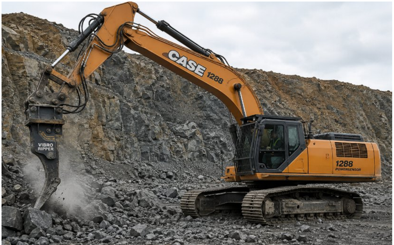
Рисунок 3.3. Гідравлічний екскаватор CASE 1288 з навісним обладнанням у робочому положенні
