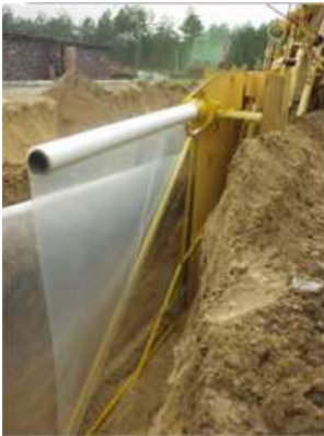
Рисунок. Влаштування дренажно-екранних модулів: а) екскаватор-дреноукладач ЕТЦ-202Б обладнаний пристроєм для влаштування ДЕМ; б) встановлення котушки з плівкою; в) попередньо присипаний ДЕМ
