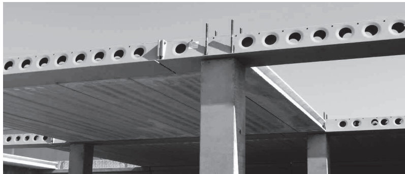
Рис. 2. Збірно-монолітний каркас Delta в процесі зведення
