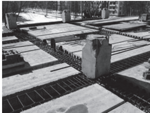
Рис. 3. Будівля конструктивної системи «АРКОС» в процесі зведення
