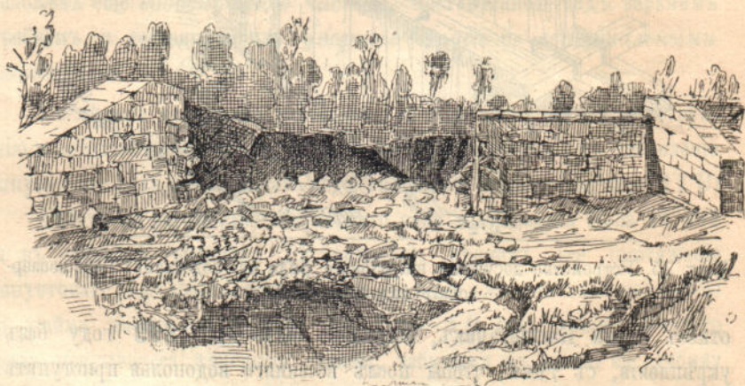
Рис. 16. Водосливъ Большаго водохранилища на Великоанадольскомъ участкѣ послѣ весенняго половодья 1895 года (съ фотографіи Г. Н. Высоцкаго).
