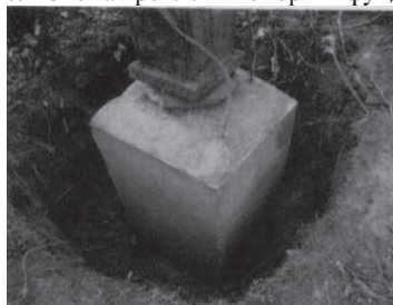
Рис.2 Схема крепления опоры к фундаменту
