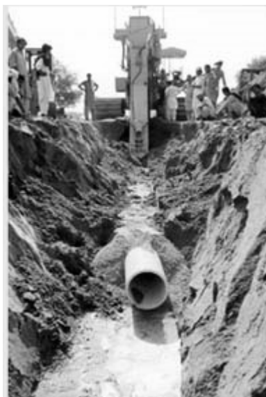
Рис. 5. Формування ґрунтового конверту з фільтруючого матеріалу навколо труби
