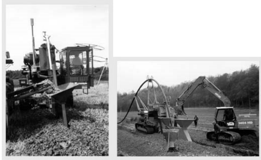
Рис. 6. Способи заправки фільтруючого матеріалу в бункер: а) боковим транспортером з самохідного візка; б) однокішневим екскаватором
