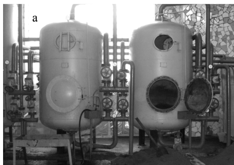
Рис. 2. Зовнішній вигляд напірних фільтрів з засипкою із кварцового піску (а) і схема його роботи (б)
