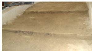
Рис. 6. Ступінчастий рельєф каналу
