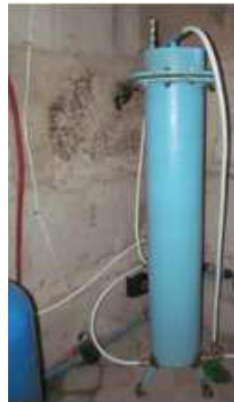
Рис. 5. Напірний пінополістирольний фільтр
