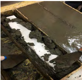
Рис. 2. Укладання шлакобетону
