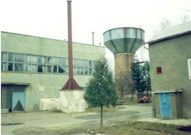
Рис. 2.7. Станція знезалізнення «Новий Двір» (будівля основних споруд – вид зліва, промивна башта – по центру, хлораторна – вид справа)
