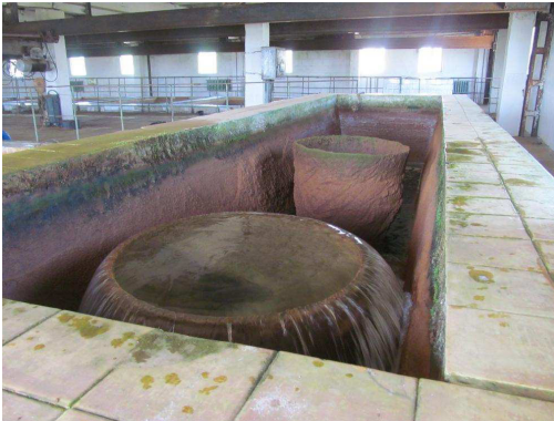
Рис. 2. Блок аерації із чашоподібною конструкцією
