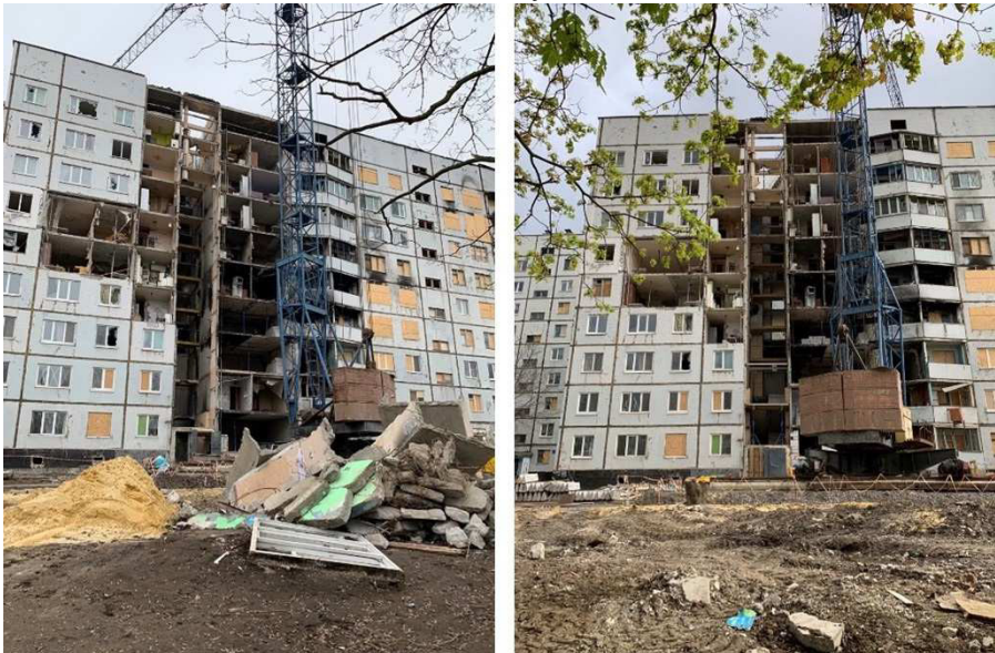
Рис. 2. Реконструкція великопанельного житлового будинку у м. Харків, С. Салтівка
