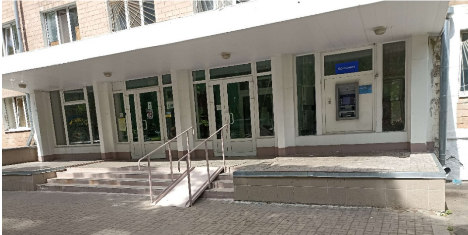
Рис. 1. Вхід у гуртожиток університету до капітального ремонту
