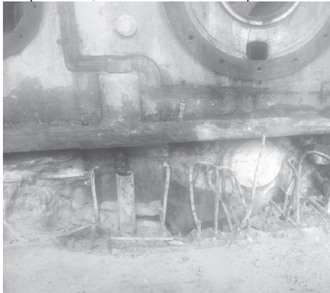
Рис. 2. Вплив агресивного середовища на анкер
